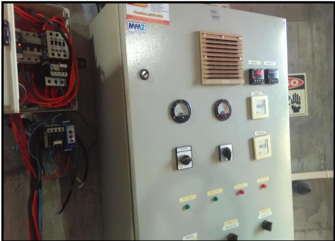
Imagem 17: Quadro de comando e quadro de comunicação via rádio da Estação Elevatória do Reservatório Elevado
