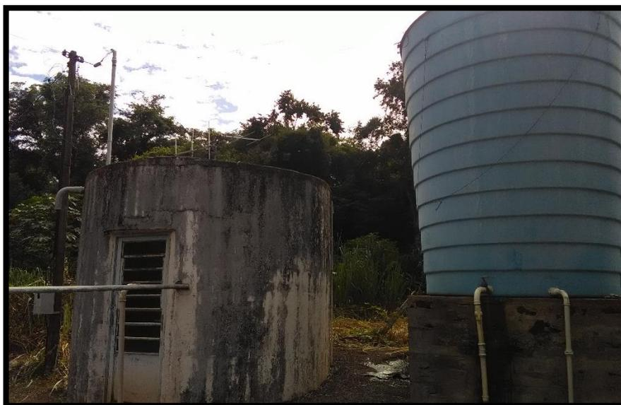
Imagem 31: Reservatório elevado e abrigo da bomba de recalque
