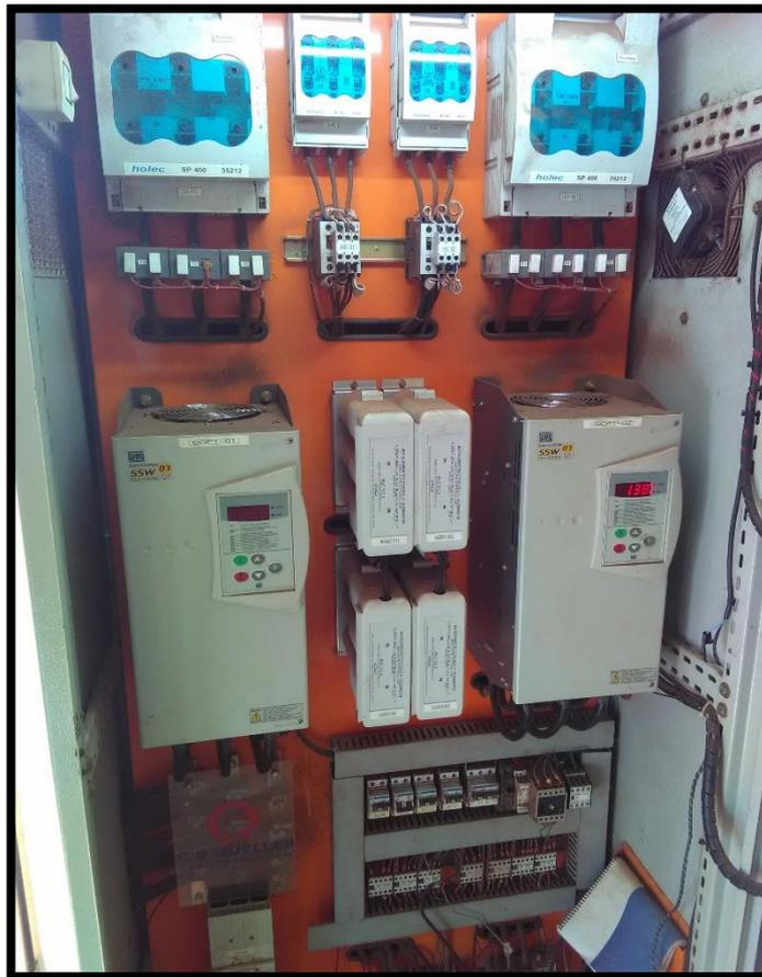
Imagem 15: Quadro de comando da Estação Elevatória da mina
