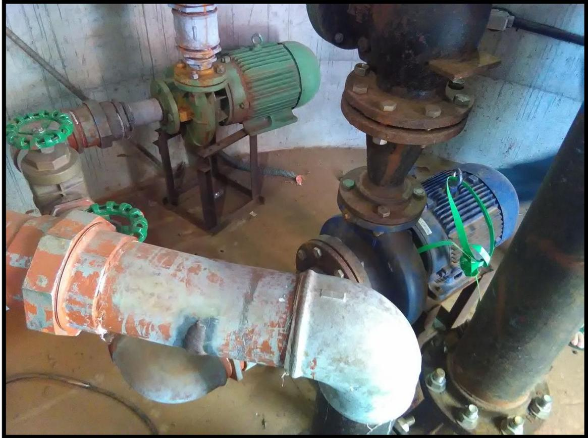
Imagem 16: Conjunto Moto-bombas da Estação Elevatória do Reservatório elevado
