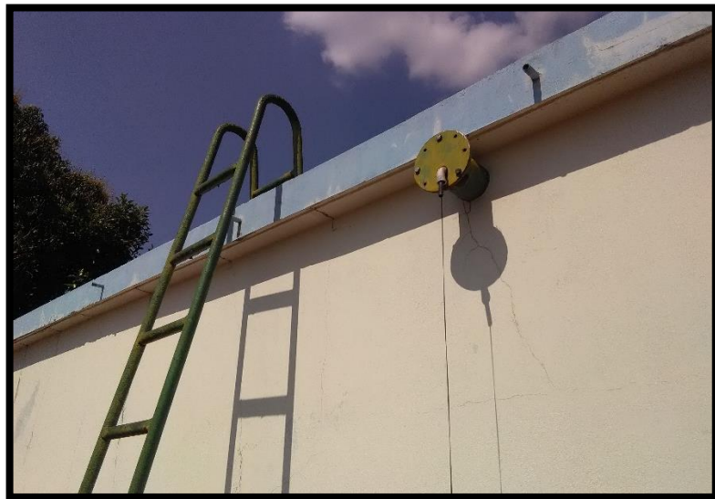
Imagem 18: RAP 02 – nível e escada fixa
