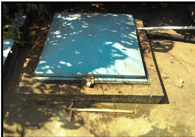
Imagem 19: RAP 02 - Abertura de inspeção
