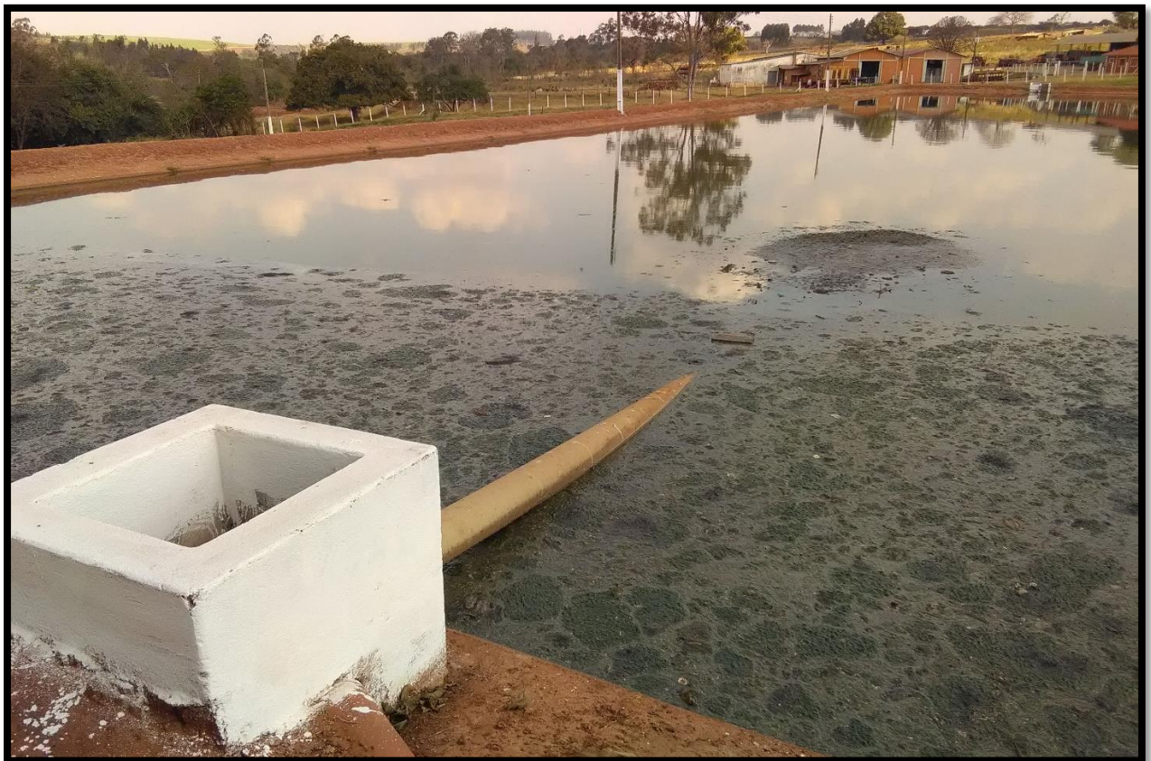
Imagem 29: ETE – Lagoa Anaeróbia 1
