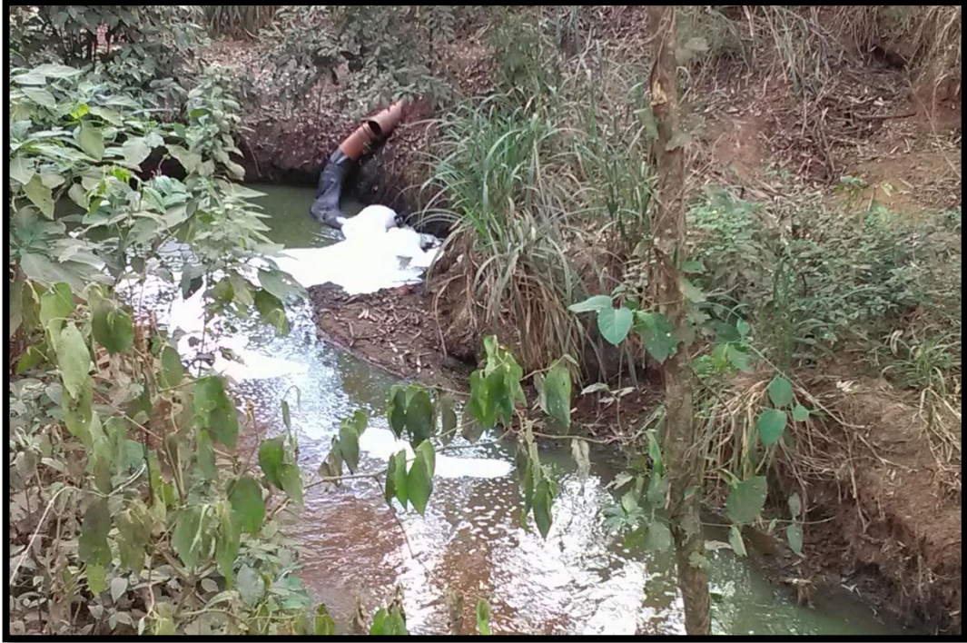
Imagem 32: Emissário de efluente no corpo receptor
