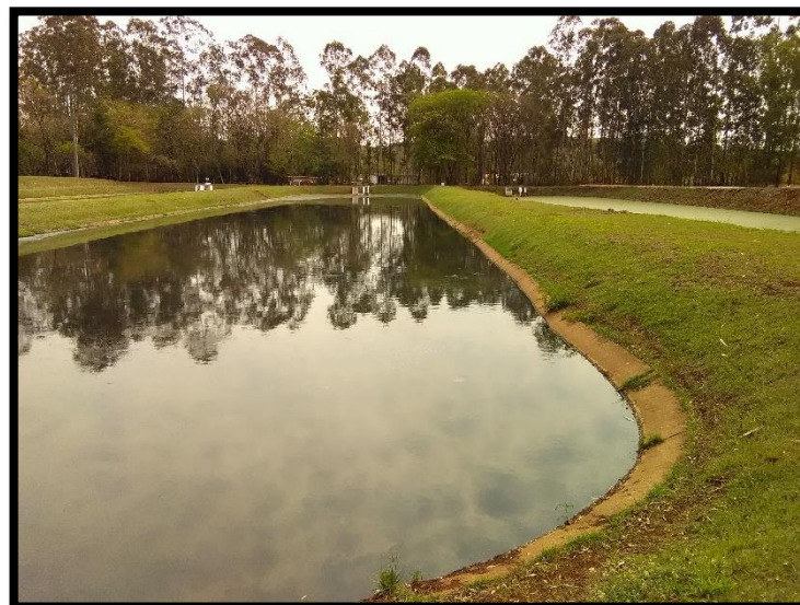
Imagem 40: ETE – Lagoa Anaeróbia
