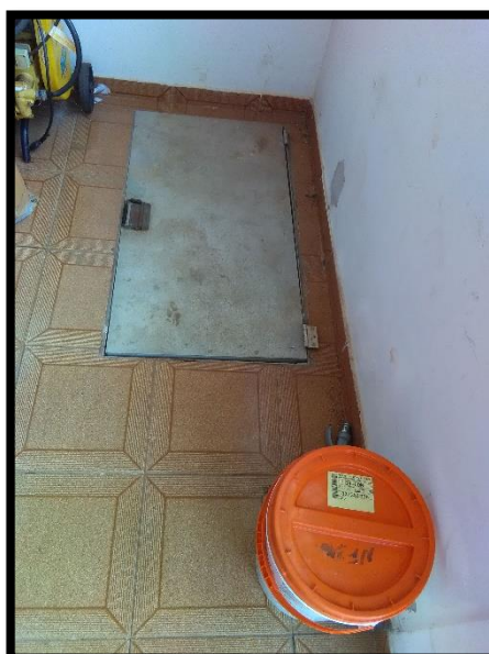
Imagem 15: Abertura de inspeção do REN 2
