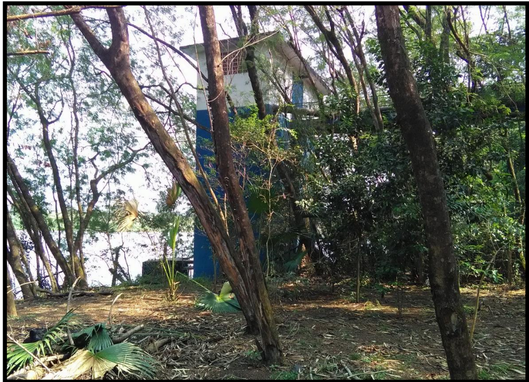
Imagem 5: Captação e casa de máquinas
