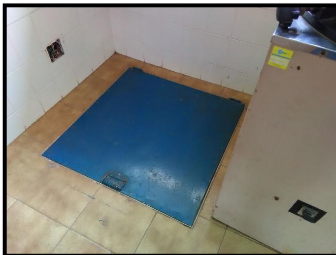
Imagem 14: Abertura de inspeção do REN 1
