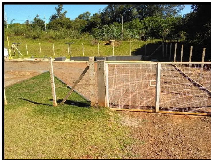
Imagem 25: Estação elevatória de esgoto
