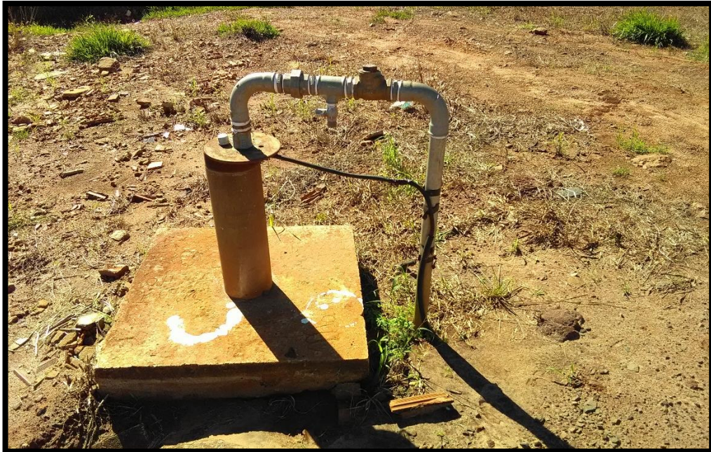
Imagem 22: Poço tubular profundo - sistema Novo Horizonte
