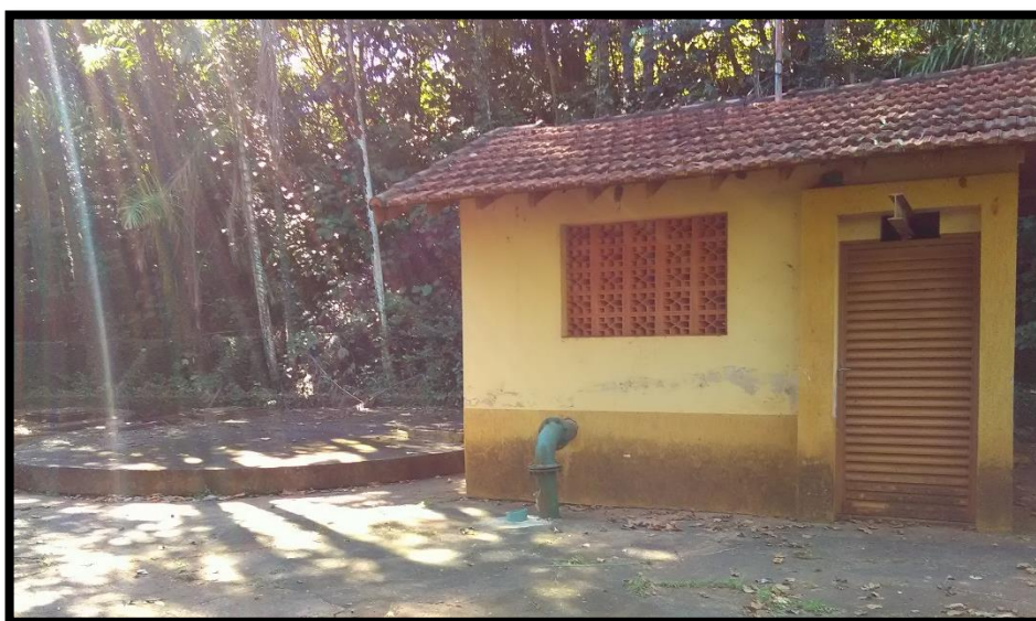
Imagem 7: Reservatório de recalque do Poço e Mina Aguapeí
