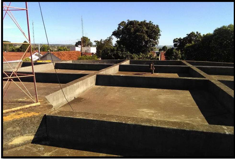
Imagem 14: Reservatório apoiado – laje de cobertura
