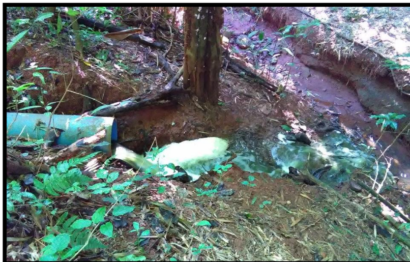
Imagem 30: Emissário de efluente no corpo receptor
