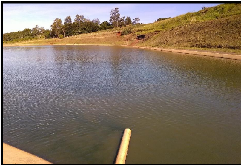
Imagem 29: Estação de Tratamento de Esgoto – Lagoa Facultativa
