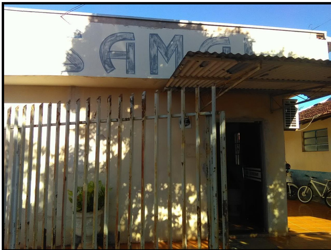
Imagem 1: Fachada área comercial
