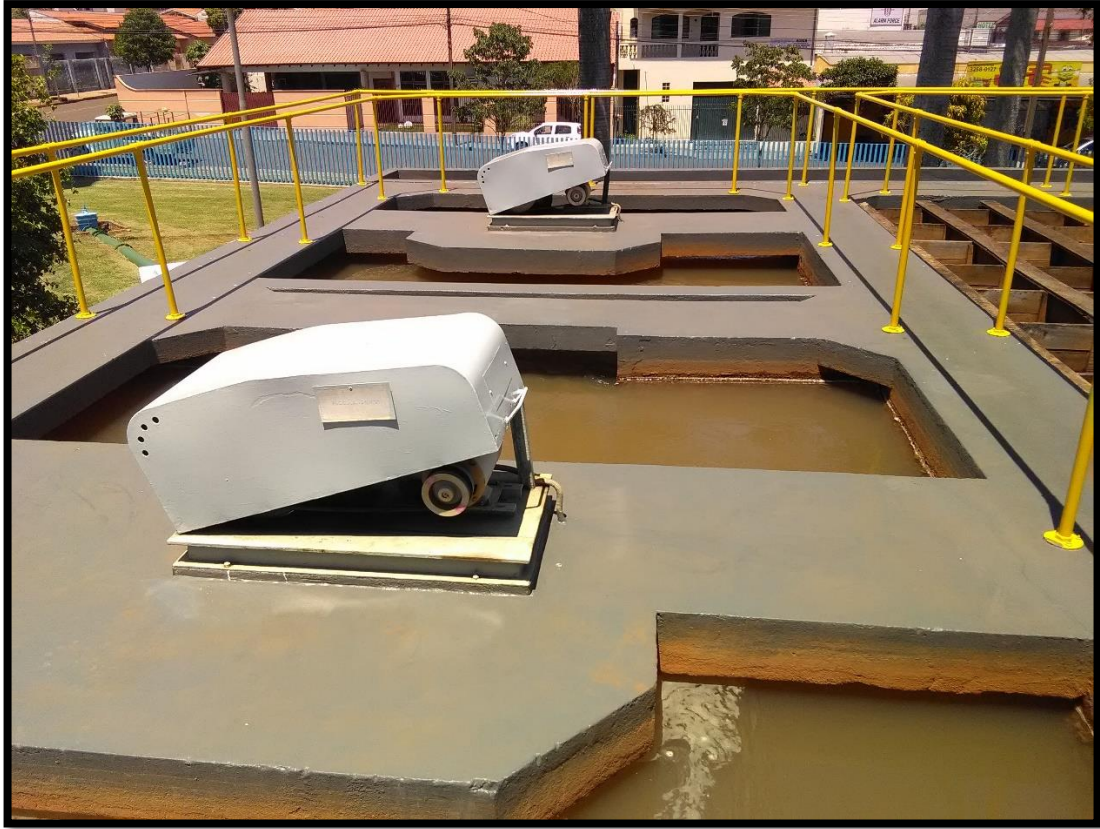
Imagem 16: Flocculadores mecânicos
