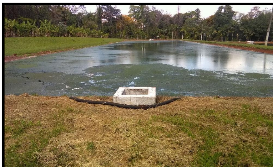
Imagem 47: Entrada da lagoa anaeróbia
