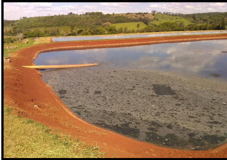
Imagem 35: Entrada da 1ª lagoa anaeróbia
