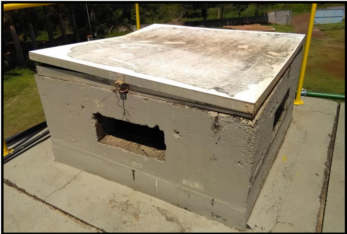
Imagem 12: Abertura de inspeção do RAP do Poço 2
