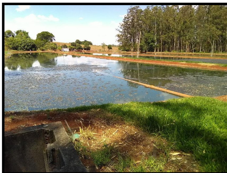
Imagem 42: Entrada da 1° lagoa anaeróbia
