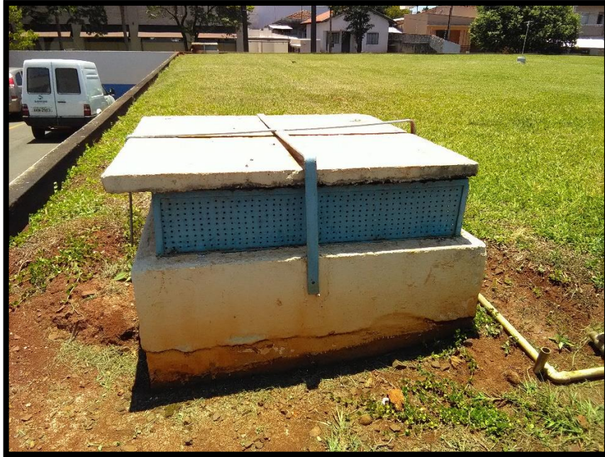
Imagem 23: Abertura de inspeção do reservatório semienterrado
