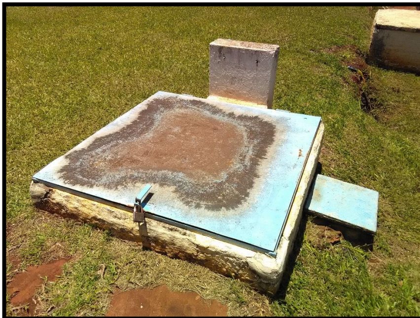
Imagem 22: Abertura de inspeção do reservatório enterrado
