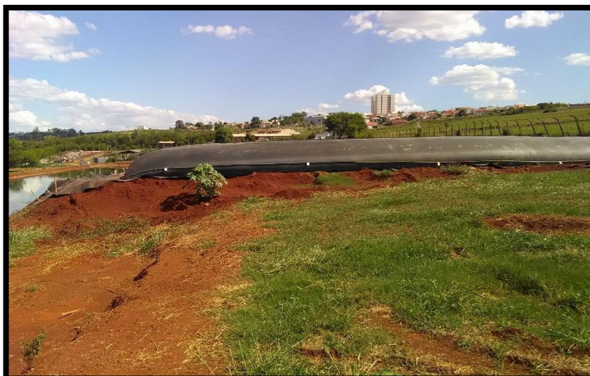
Imagem 34: Bags de Geotêxtil desidratando Lodo
