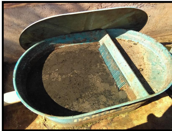
Imagem 51: Tanque de gradeamento
