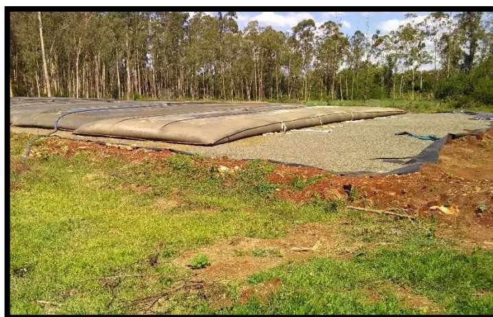
Imagem 41: Bags de Geotêxtil desidratando Lodo
