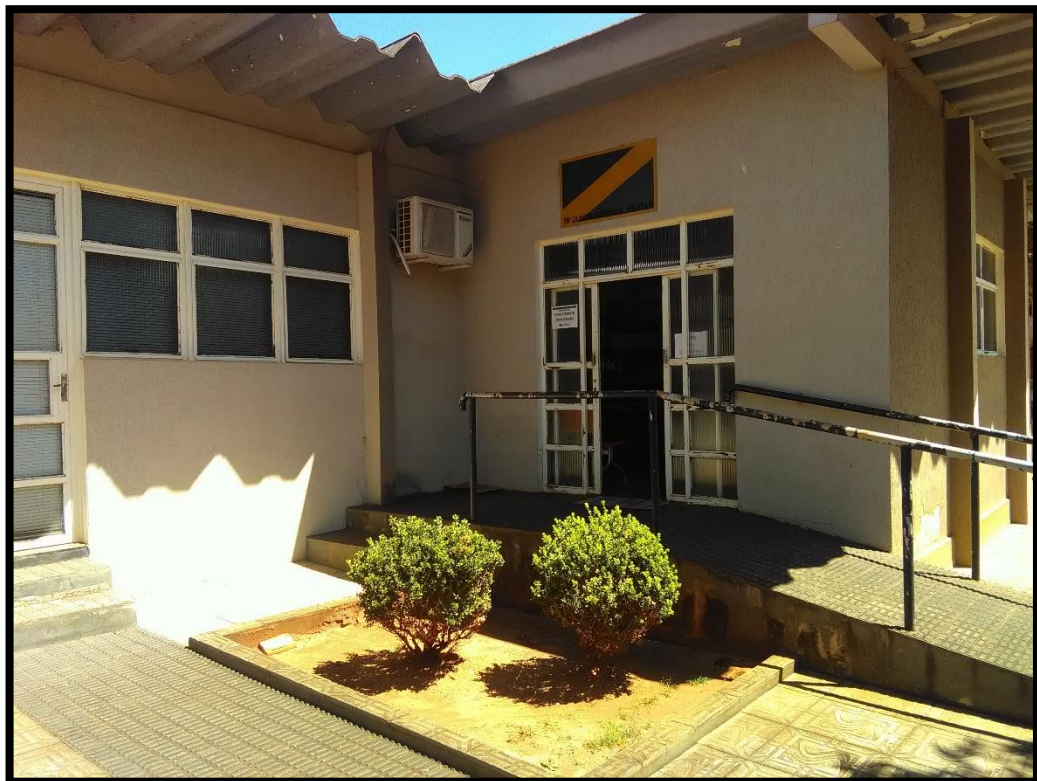
Imagem 1: Fachada da área de atendimento ao público
