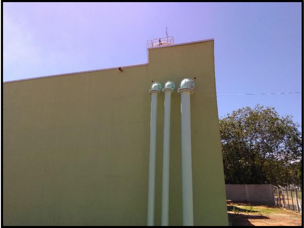
Imagem 15: Reservatório apoiado (RAP 01)
