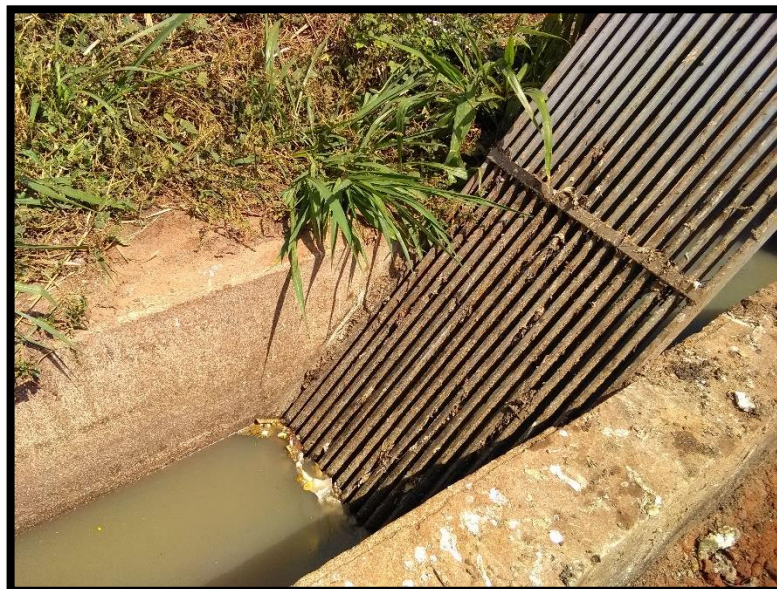
Imagem 23: Entrada da Lagoa Anaeróbia
