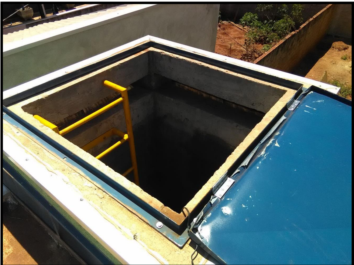
Imagem 16: Abertura de inspeção do RAP 1
