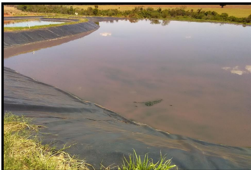
Imagem 26: Dispositivo de saída da lagoa facultativa
