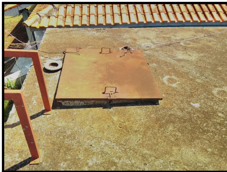
Imagem 11: Abertura de inspeção do RAP da Sede
