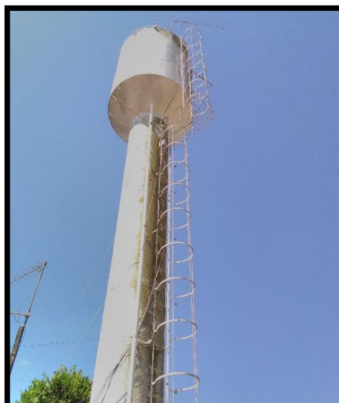
Imagem 12: Reservatório elevado da Sede
