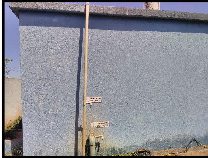
Imagem 10: Reservatório apoiado da Sede
