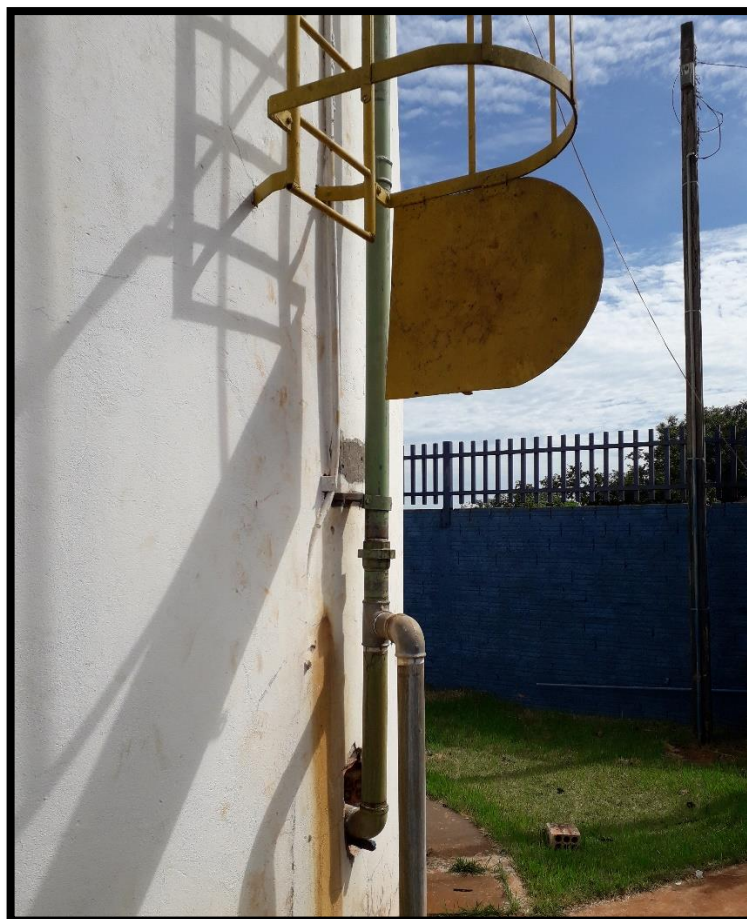
Imagem 19: Escada do reservatório apoiado
