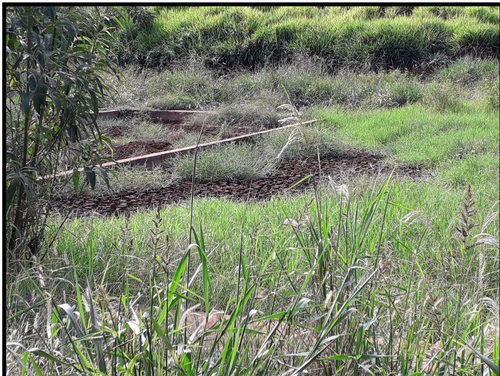
Imagem 33: ETE Barreiro – Leitos de secagem
