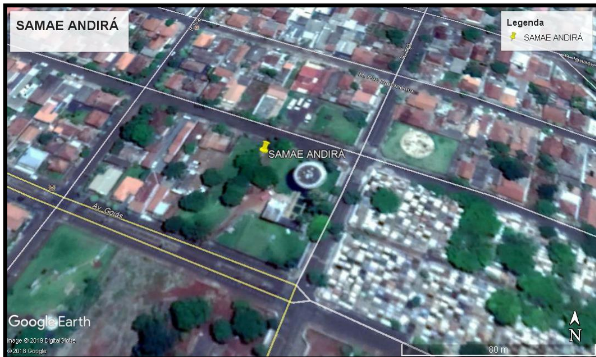
Imagem 1: Localização ETA, reservatório elevado e sede administrativa
