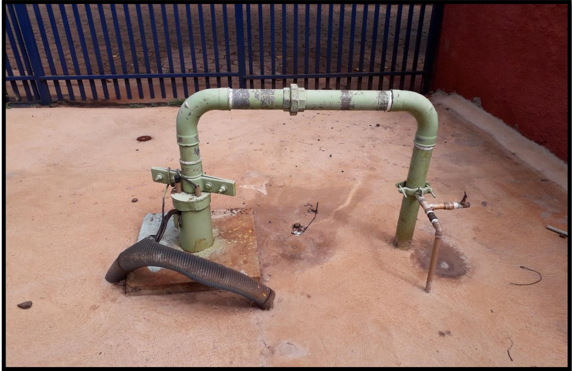
Imagem 10: Captação subterrânea do sistema Americana
