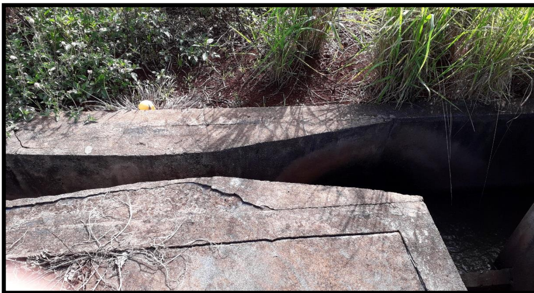
Imagem 30: ETE Barreiro - Calha parshall de entrada em concreto
