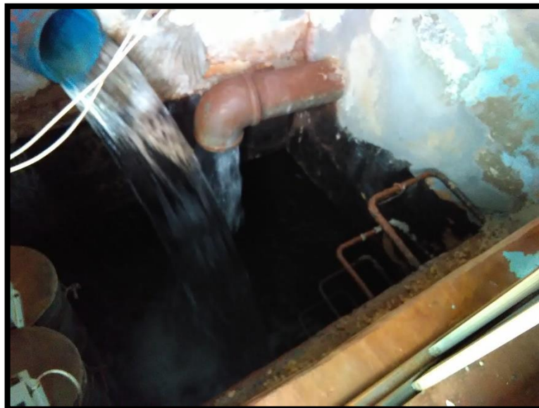
Imagem 16: Reservatório enterrado – abertura de inspeção
