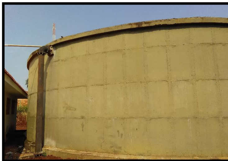
Imagem 19: Reservatório apoiado – em construção
