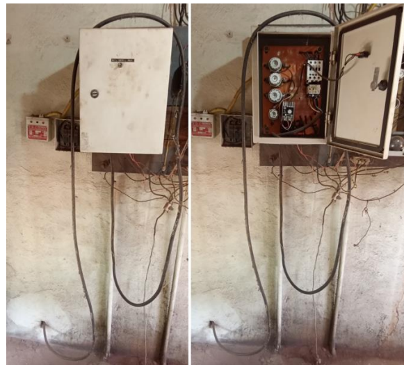
Foto 29 – Quadro de comando (fechado/aberto)
