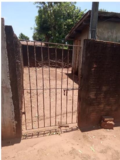
Foto 23 – Entrada da área de captação
