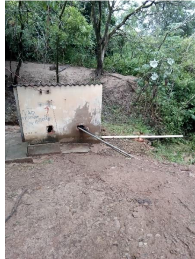
Foto 42 – Área de captação
