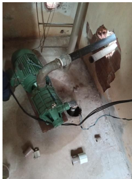
Foto 46 – EEA da Mina 01
