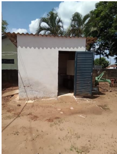
Foto 32 – Casa de comando
