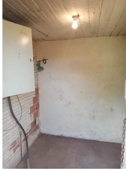
Foto 14 – Casa de comando
