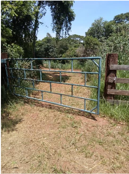
Foto 6 – Entrada da área de captação
