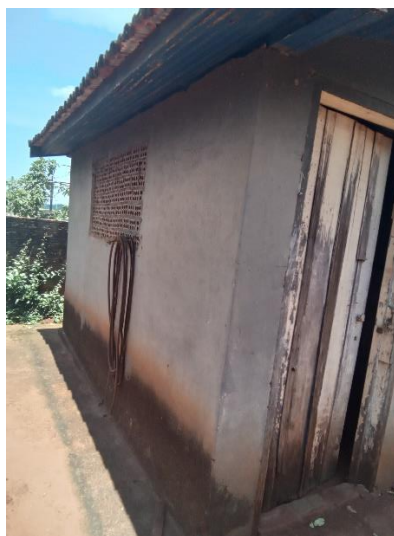
Foto 26 – Lateral de casa de comando
