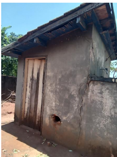
Foto 25 – Casa de comando
