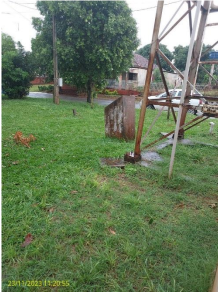
Foto 56 – Entrada do reservatório elevado
