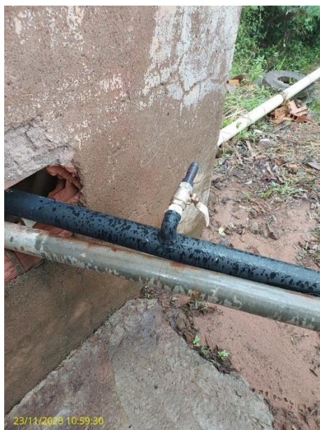
Foto 65 – Adutora de água bruta Mina 01
