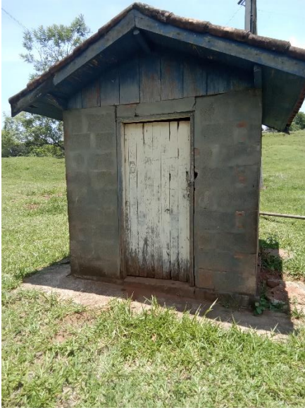
Foto 20 – Casa de comando
