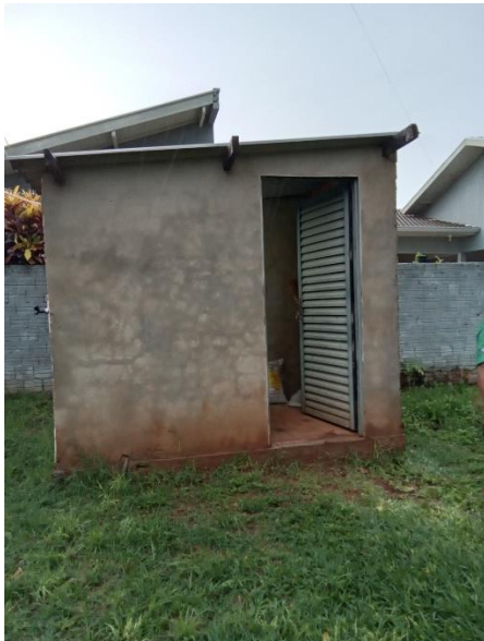
Foto 37 – Casa de comando
