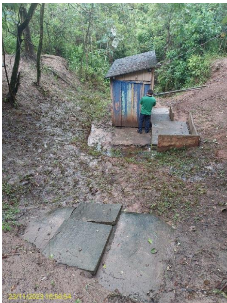
Foto 43 – Casa de comando e caixa de inspeção
