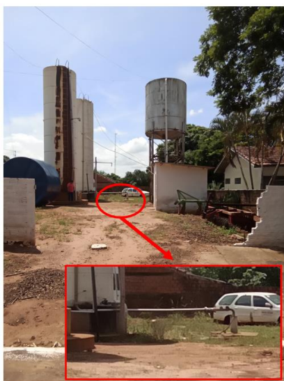
Foto 30 – Entrada da área de captação
