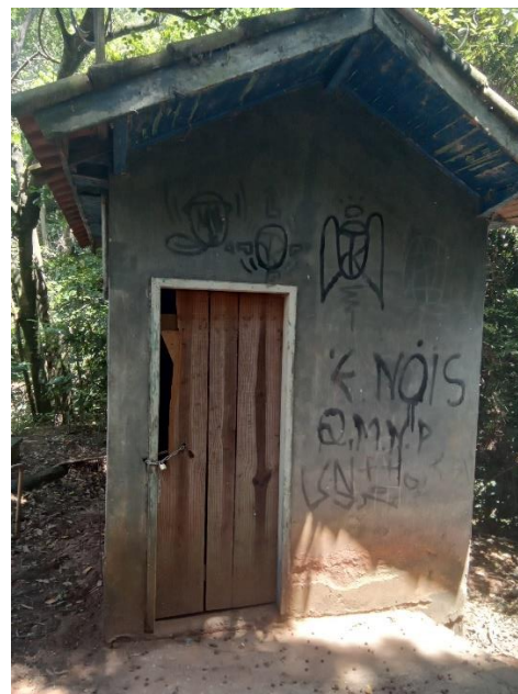
Foto 9 – Casa de comando
