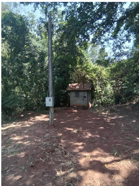
Foto 8 – Área da casa de comando
