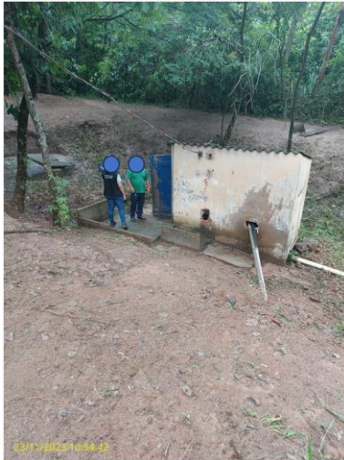
Foto 41 – Área de captação
