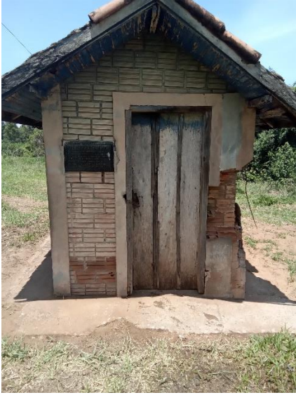
Foto 13 – Casa de comando
