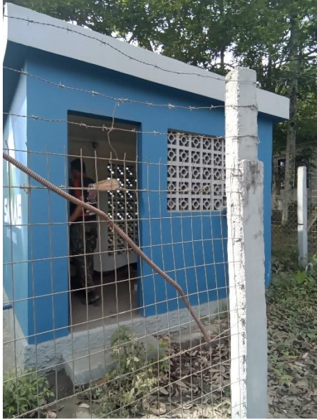
Foto 91 – Falta de identificação EEA 03
