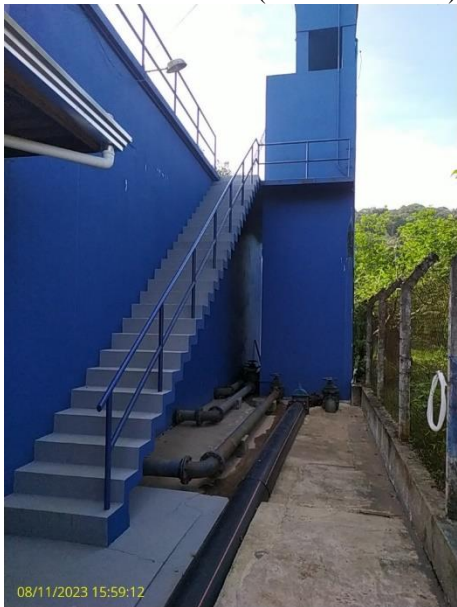
Foto 53 – ETA Central (acesso aos filtros)
