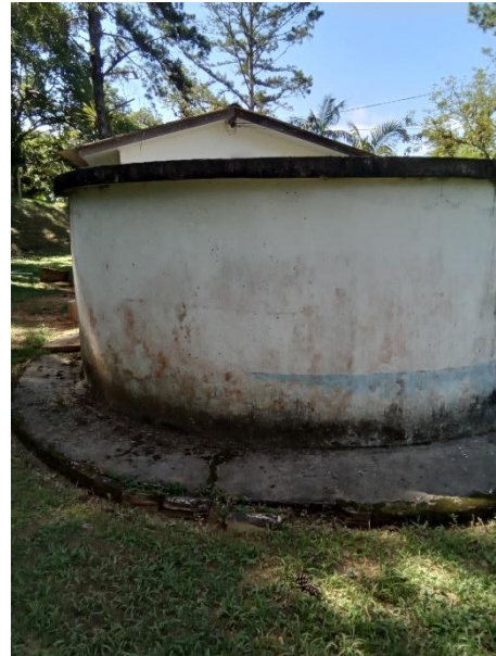
Foto 58 – RAP Bairro Alto Parte de trás
