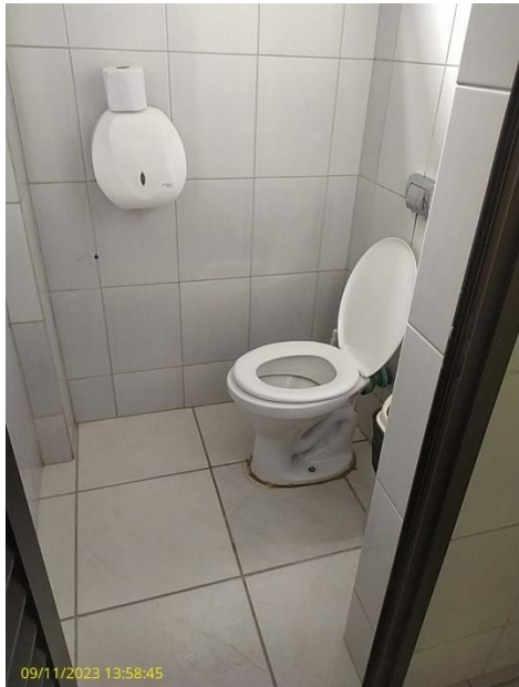
Foto 03 – BWC sem barra para PNE
