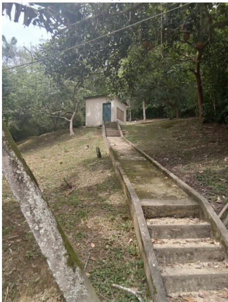
Foto 117 – Falta e isolamento e identificação EEA 06
