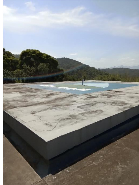
Foto 68 – Laje superior RESENT Itapema
