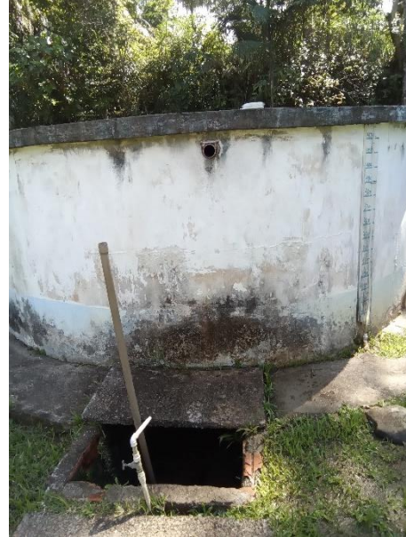
Foto 56 – Sem tela extravasador RAP Bairro Alto
