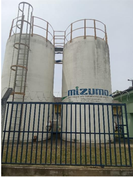
Foto 131 – Sem identificação ETE
