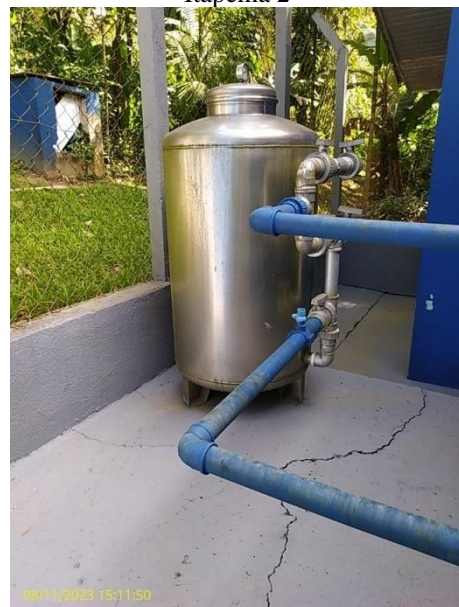
Foto 52 – Filtro portátil com fluxo descendente ETA Itapema 2
