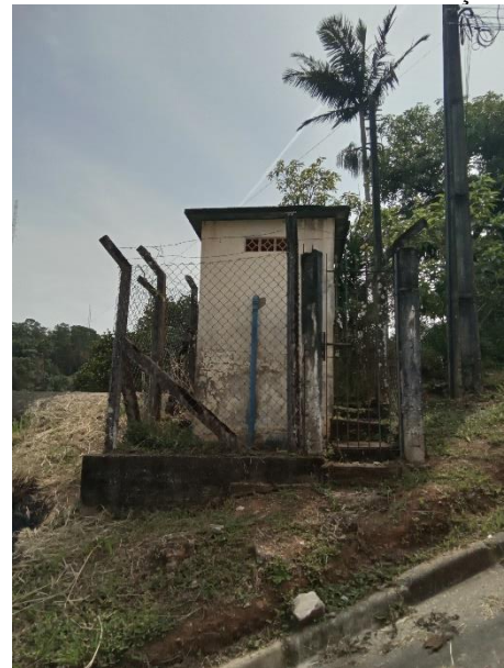
Foto 102 – EEA 05 – Falta identificação
