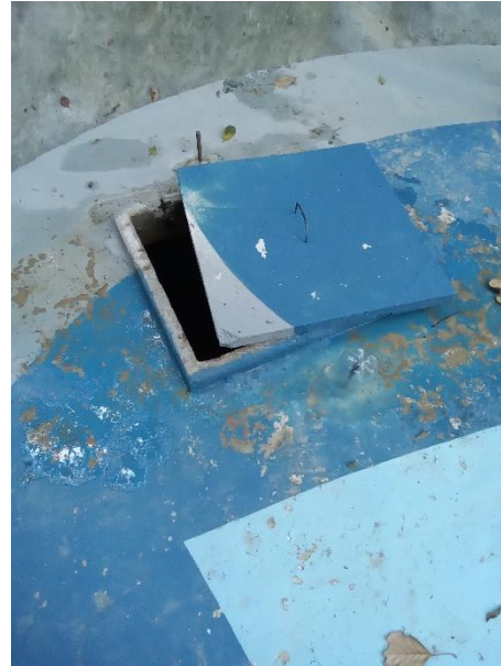
Foto 60 – Tampa de abertura RAP Penha
