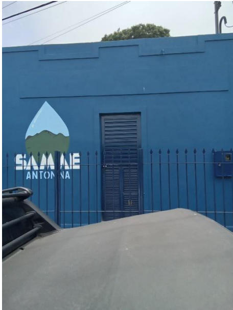
Foto 111 – Falta de identificação EEA 02
