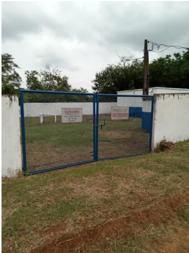
Foto 22 – Acesso e identificação Poço 07
