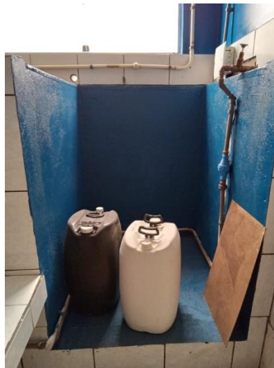
Foto 31 – Estocagem de produtos químicos
