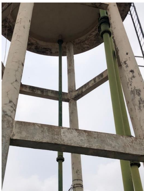
Foto 36 – Pilar comprometido
