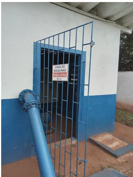
Foto 57 – Casa de máquinas elevatória
