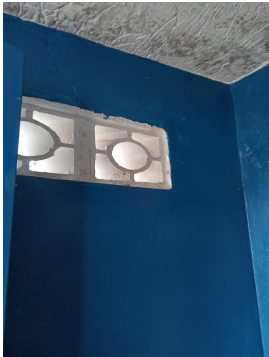
Foto 20 – Entrada de ar e iluminação natural
