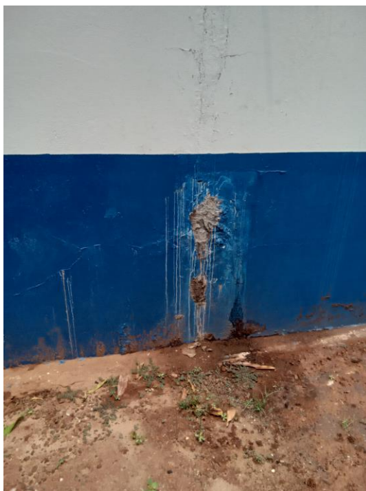
Foto 42 – Vazamento aparente
