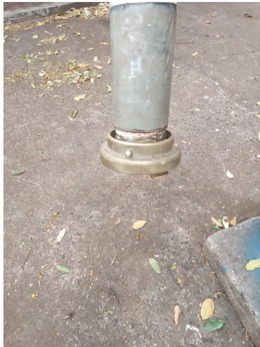
Foto 21 – Tomada de água bruta
