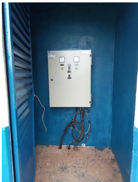
Foto 27 – Acesso ao poço
