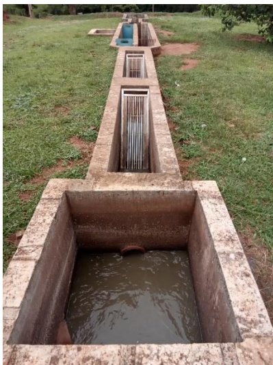
Foto 75– Caixa receptora e gradeamento
