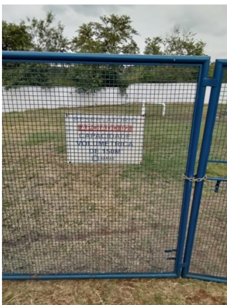
Foto 44 – Acesso e identificação ao reservatório
