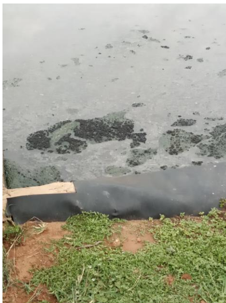
Foto 83 – Lodo na superfície da lagoa anaeróbia 02
