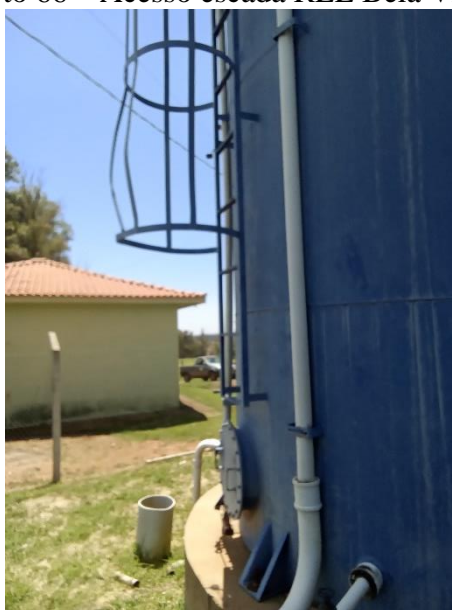
Foto 66 – Acesso escada REL Bela Vista
