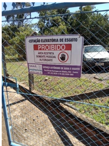
Foto 122 – Identificação EE esgoto sede
