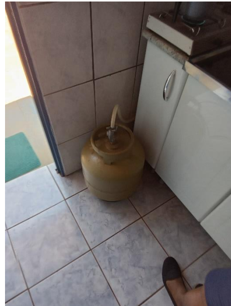
Foto 8 – Botijão de gás dentro da cozinha da sede
