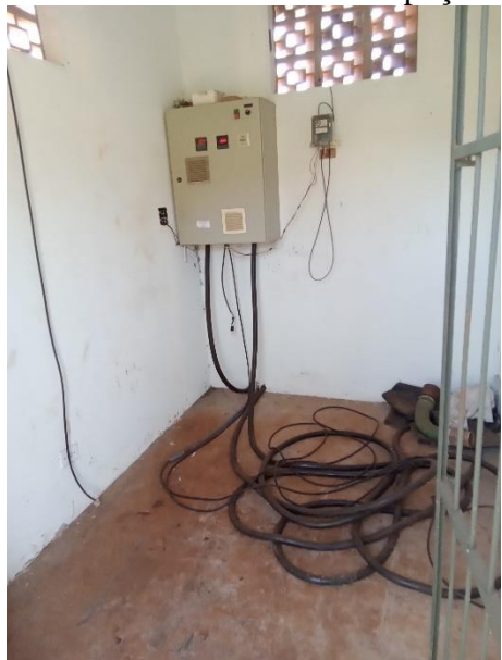
Foto 21 – Casa de comando poço Araucária
