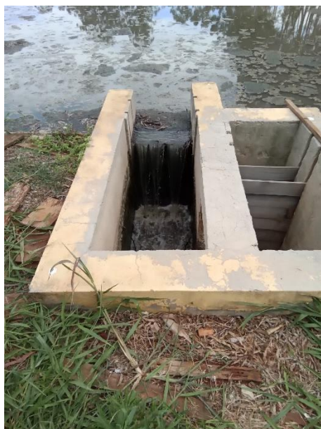
Foto 96 – Saída lagoa anaeróbia 01
