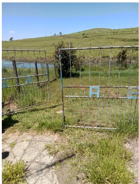
Foto 129 – Falta de identificação EE esgoto Cachoeira
