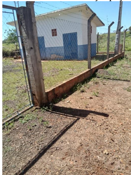
Foto 19 – Sem identificação poço Araucária
