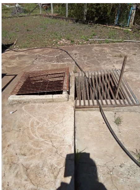
Foto 124 – Acesso gradeamento EE esgoto sede
