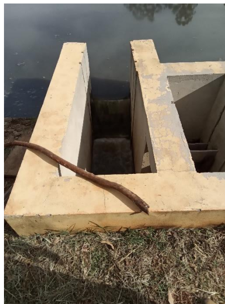
Foto 99 – Saída lagoa anaeróbia 02
