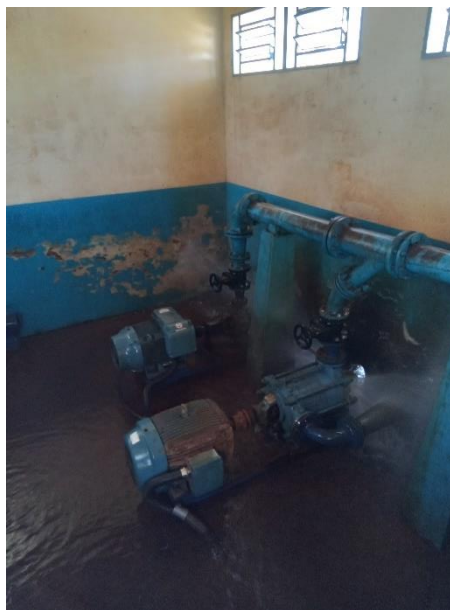
Foto 30 – Conjunto motobomba EAB01
