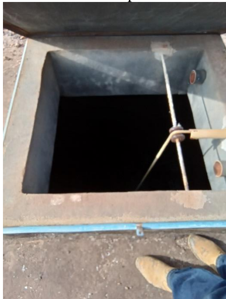
Foto 69 – Abertura para acesso RSE01
