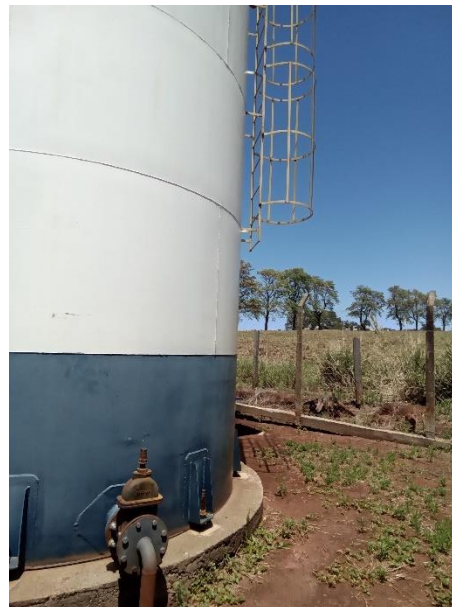
Foto 63 – Acesso escada REL Monte Carlo
