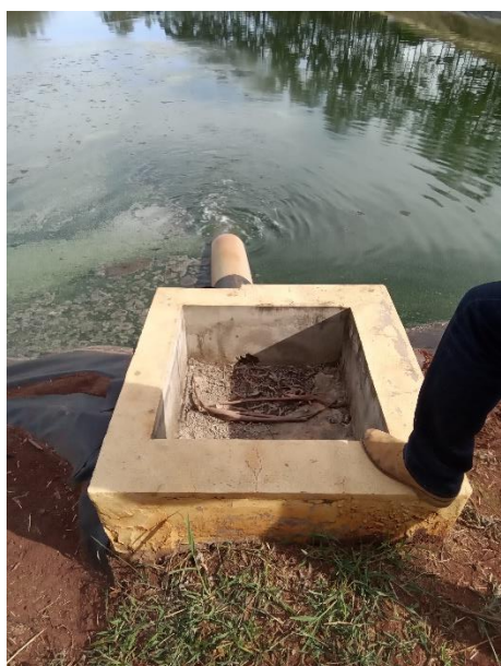
Foto 100 – Entrada lagoa anaeróbia 03
