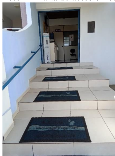
Foto 2 – Falta de acessibilidade entrada
