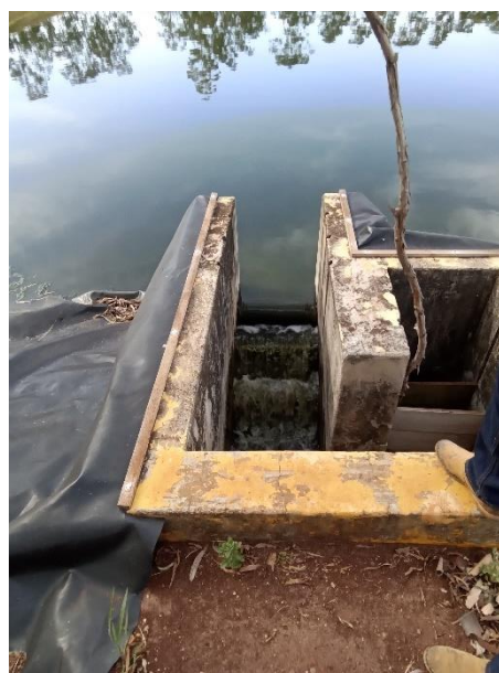
Foto 101 – Saída lagoa anaeróbia 03
