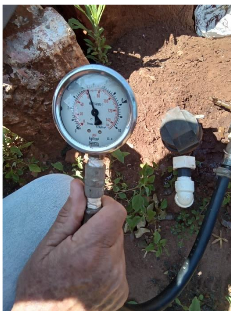
Foto 81 – Hidrômetro P02 – P = 63.00 mca
