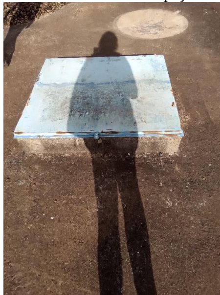
Foto 70 – Abertura de inspeção RSE01
