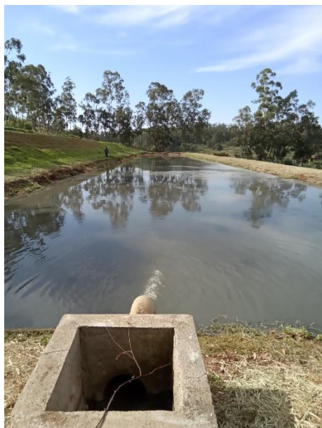
Foto 98 – Entrada lagoa anaeróbia 02
