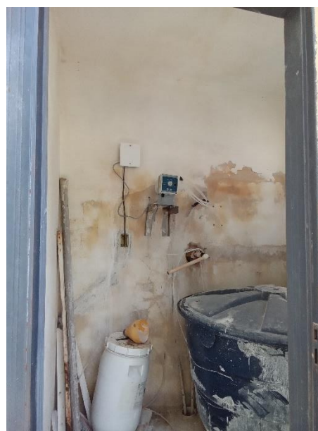
Foto 56 – Falta de identificação UTA Seringueira
