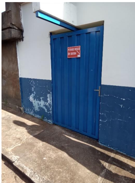
Foto 41 – Falta de Identificação EAT01
