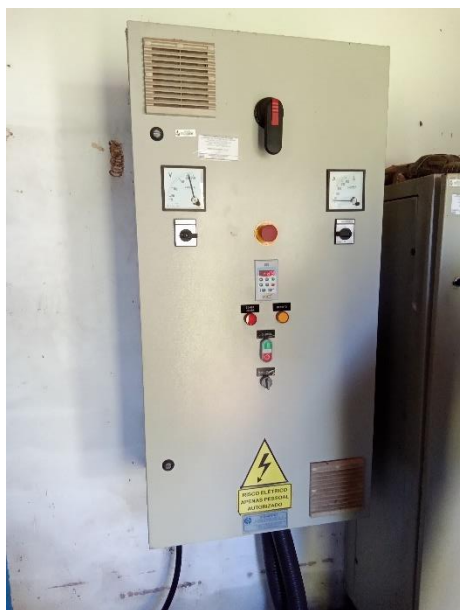
Foto 35 – Falta de identificação de casa de máquinas EAB 02
