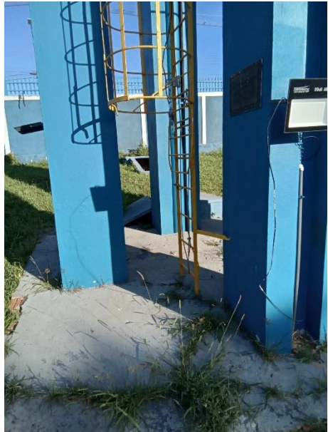
Foto 76 – Escada de acesso REL sede
