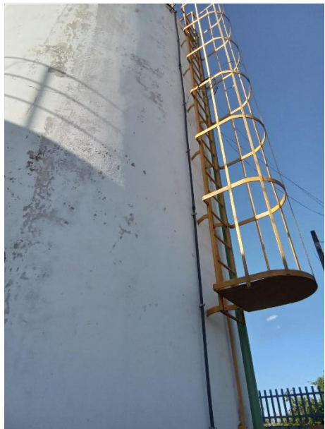
Foto 74 – Escada de acesso REL Timburi
