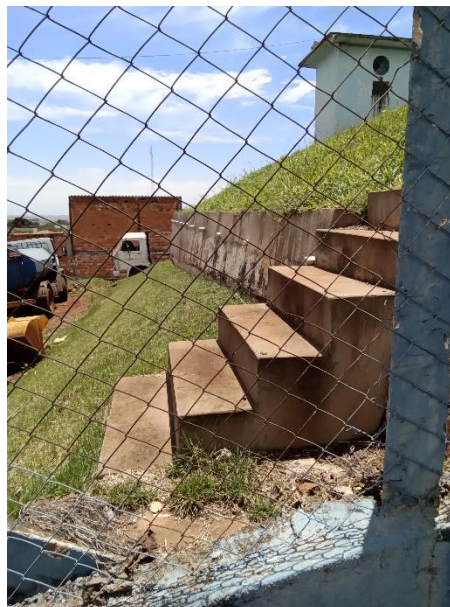
Foto 81 – Escada de acesso reservatório enterrado 1
