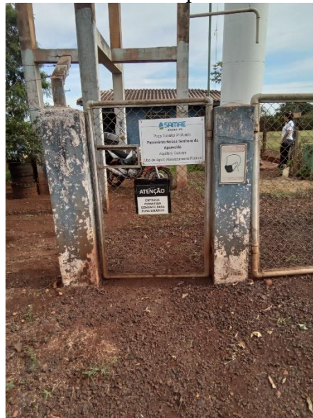
Foto 32 – Identificação poço Patrimonio Nossa Senhora de Aparecida
