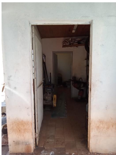
Foto 11 – Falta de identificação almoxarifado
