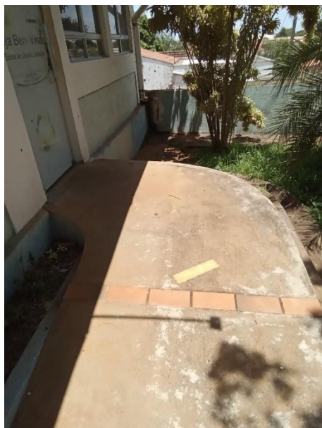
Foto 1 – Rampa de acesso ao público
