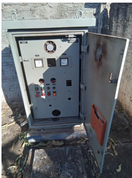
Foto 124 – Frente do quadro de comando EE esgoto Rua Paraná
