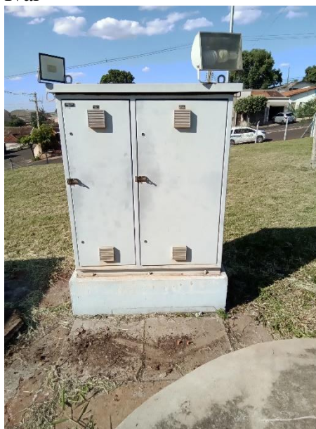
Foto 28 – Abrigo quadros de energia poço Ivai
