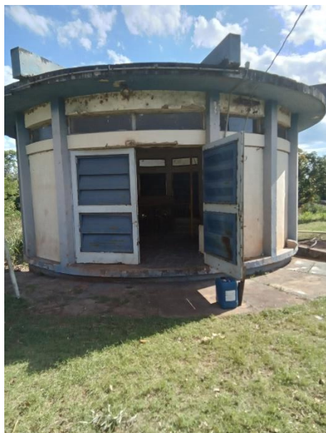
Foto 22 – Entrada casa de comando/máquinas
