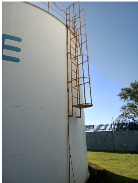
Foto 72 – Acesso RAP Timburi
