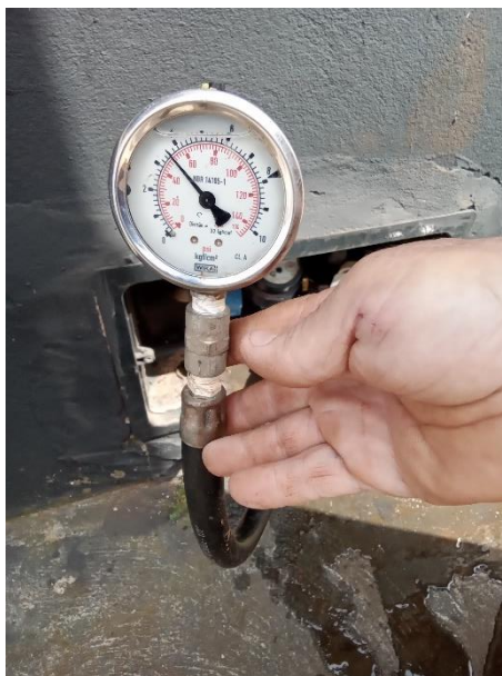
Foto 95 – Hidrômetro P03 – P = 50.00 mca
