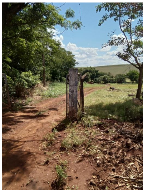
Foto 107 -Entrada ETE Antas
