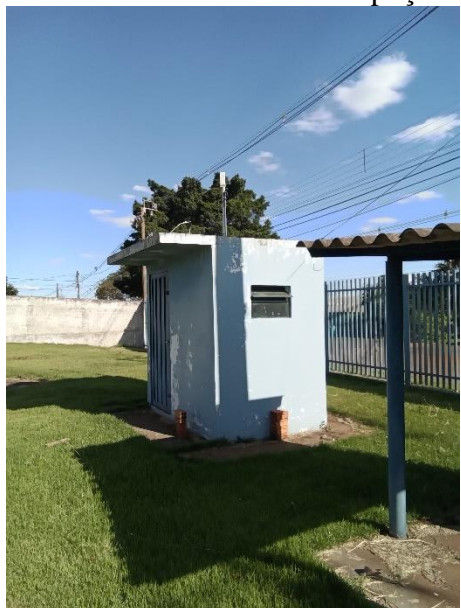
Foto 29 – Casa de comando poço Major
