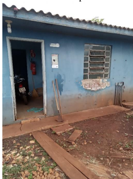
Foto 34 – Casa de comando poço Patrimônio Nossa Senhora da Aparecida
