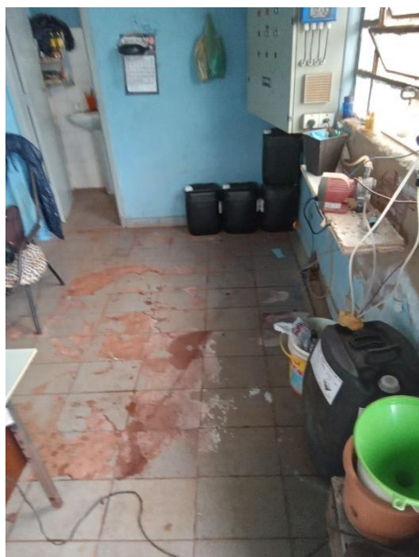
Foto 64 – Piso UTA Patrimonio Nossa Senhora de Aparecida
