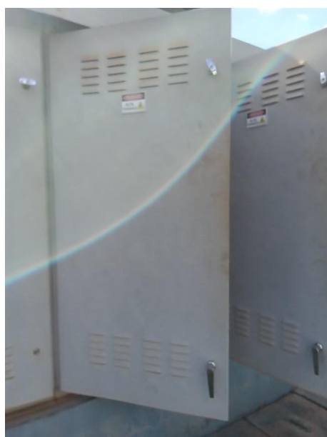
Foto 25 – Proteção quadro de comando captação superficial
