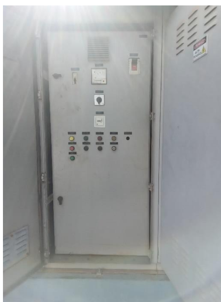
Foto 26 – Frente quadro de comando captação superficial
