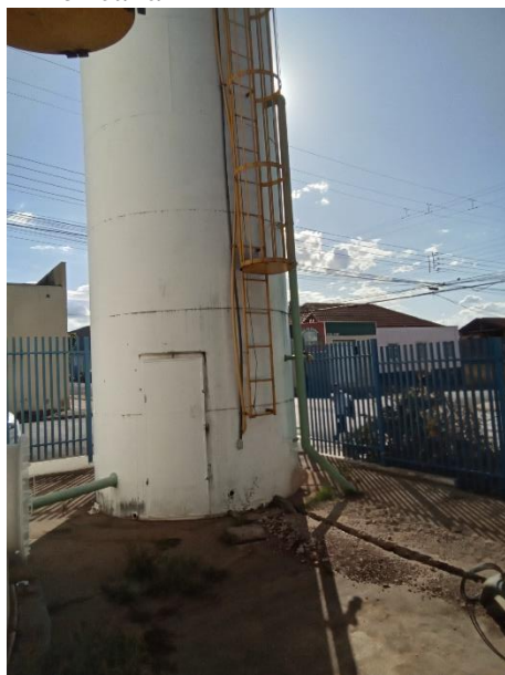
Foto 70 – Escada de acesso REL Vila Americana
