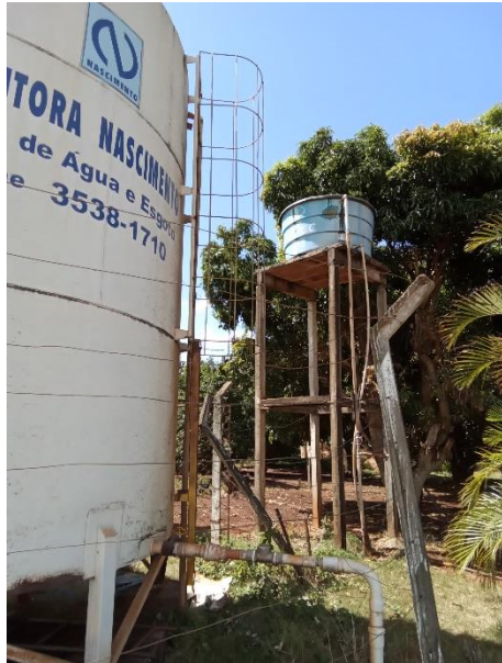
Foto 84 – Escada de acesso RAP Canoas
