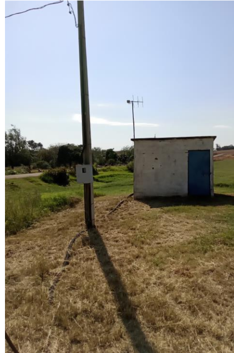
Foto 52 – Casa de comando
