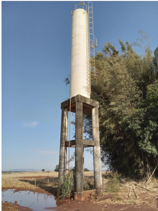
Foto 79 – Identificação e acesso REL
