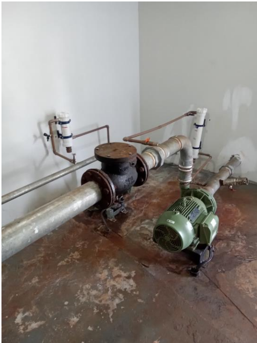
Foto 57 – UTA na estação elevatória de água
