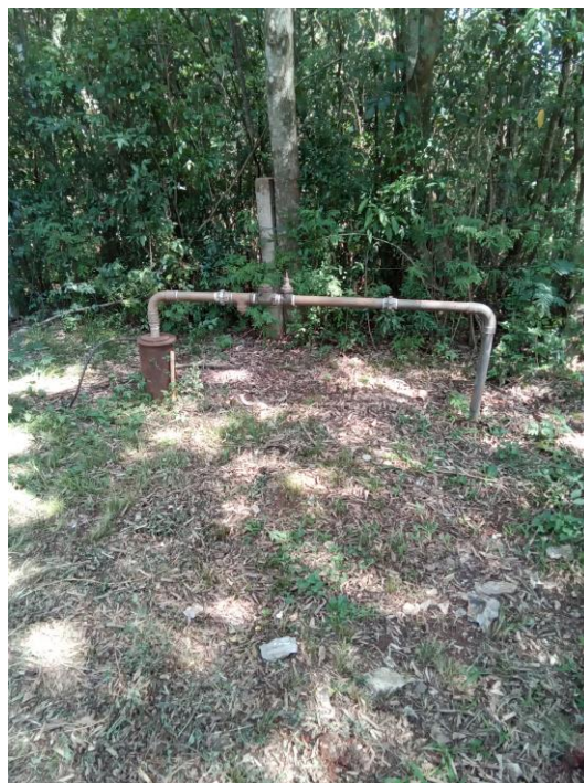
Foto 48 – Poço Arroio Fundo
