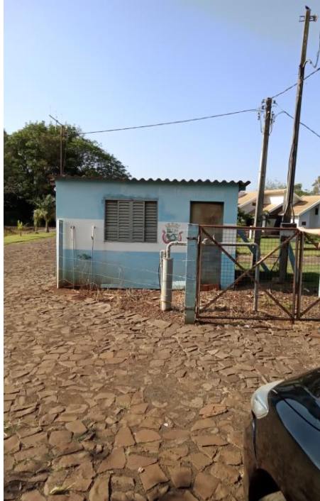
Foto 31 – Acesso e identificação Poço Linha Itapiranga
