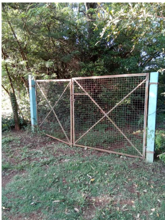
Foto 21 – Acesso Poço Km 10
