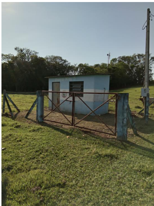
Foto 27 – Acesso e identificação Poço Km 05
