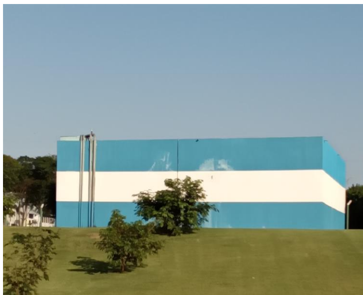
Foto 73 – Identificação e acesso
