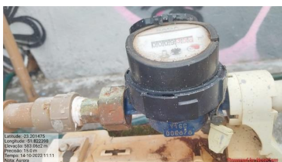
Foto 60: Ponto 01 - Ano de fabricação 2016. Foto 61: pressão = 11mca.
