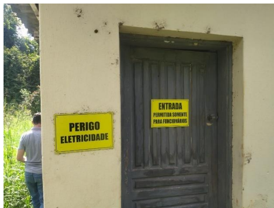
Foto 43: Sinalização do abrigo da mina.
