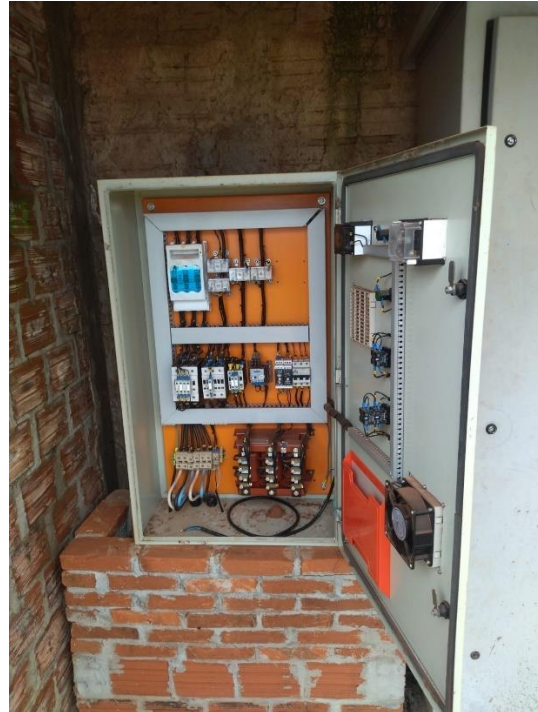
Foto 52: Ausência de diagrama unifilar.
