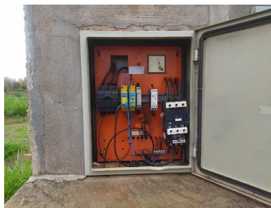
Foto 38: Quadro de Comando. Foto 39: Ausência de diagrama unifilar.
