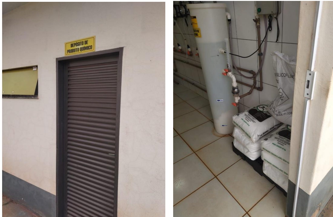
Foto 15: Identificação de acesso. Foto 16: Armazenamento de produtos químicos na Unidade de Tratamento.
