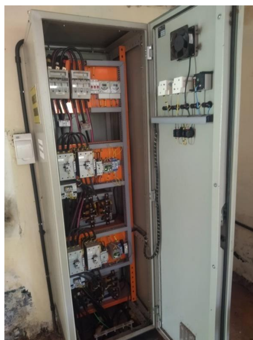
Foto 47: Quadro de comando. Foto 48: Falta de diagrama unifilar.
