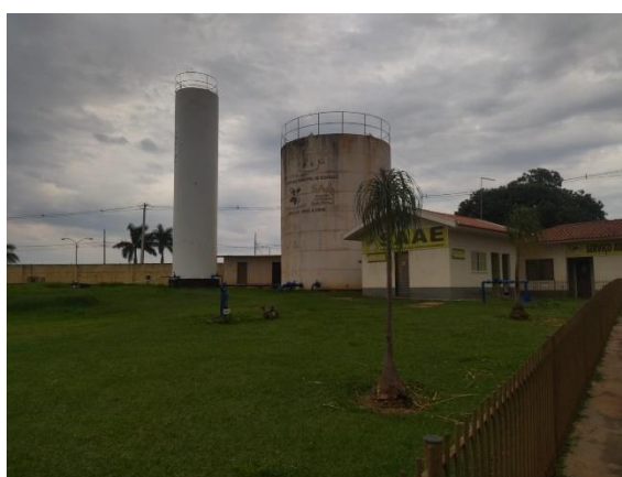
Foto 58: Vista Geral (reservatórios)
