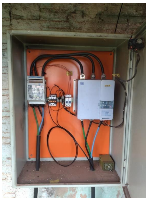
Foto 24: Ausencia de diagrama unifilar.
