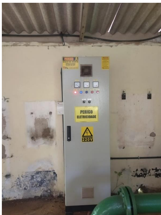
Foto 47: Quadro de comando. Foto 48: Falta de diagrama unifilar.
