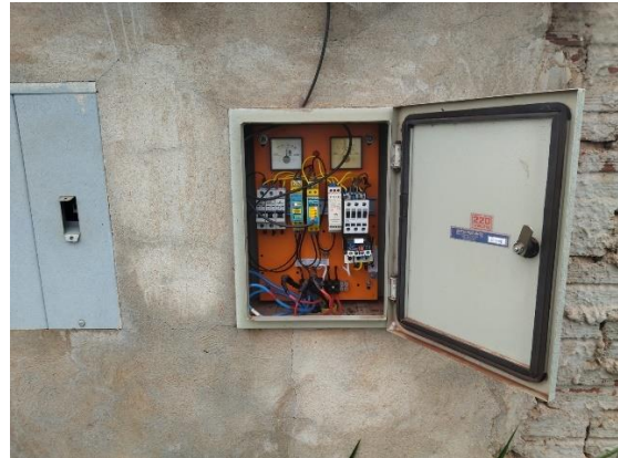
Foto 30: Ausência de diagrama unifilar.
