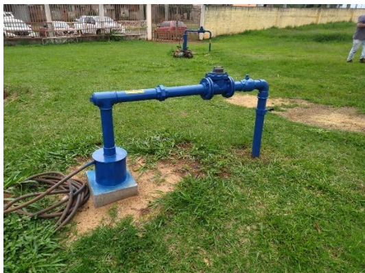
Foto 20: Laje de proteção inadequada, ausência de isolamento e identificação do poço.
