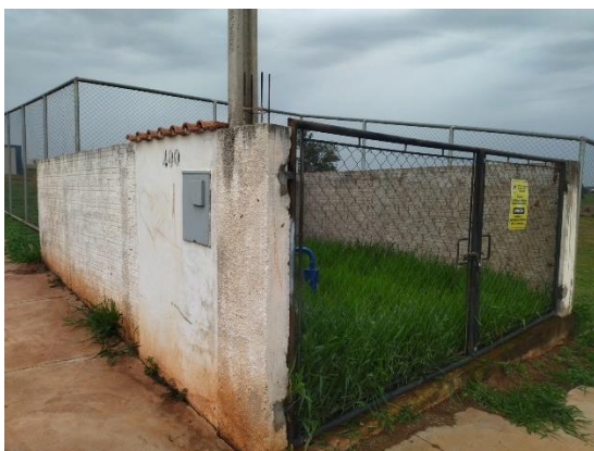
Foto 27: Falta de iluminação.
