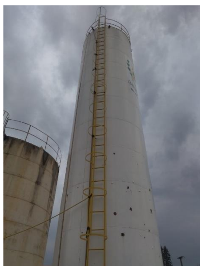
Foto 54: Escada e guarda corpo.
