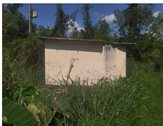
Foto 41: Falta de iluminação externa.
