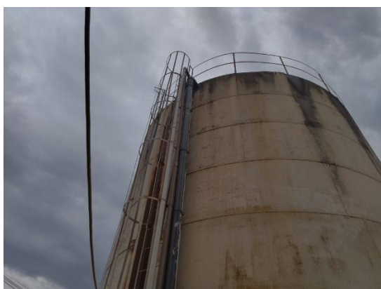
Foto 56: Escadas e guarda corpo.
