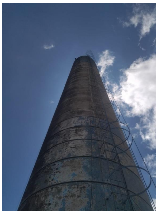
Foto 49: Escadas de acesso.
