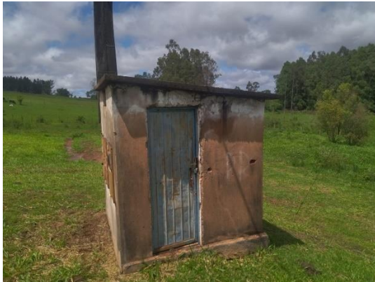
Foto 17: Estrutura da casa de comando.
