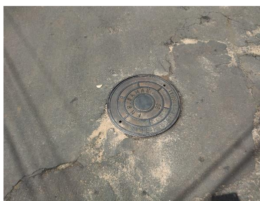
Foto 60: Tampa dos pontos de verificação de esgoto.
