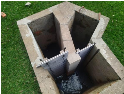
Foto 79: Caixas de divisão de fluxo.
