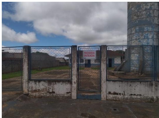
Foto 46: Acesso ao reservatório.
