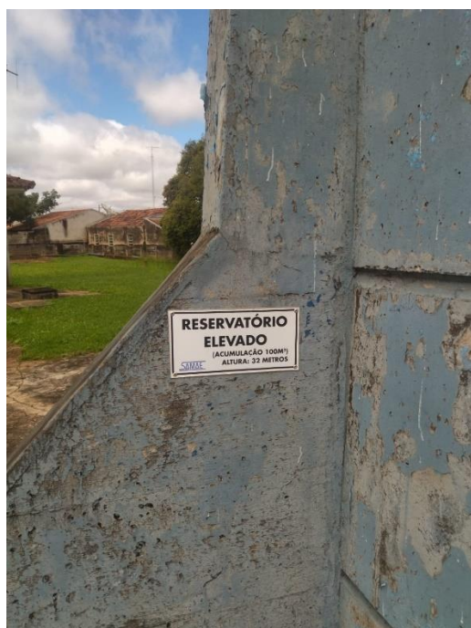
Foto 48: Identificação do reservatório.
