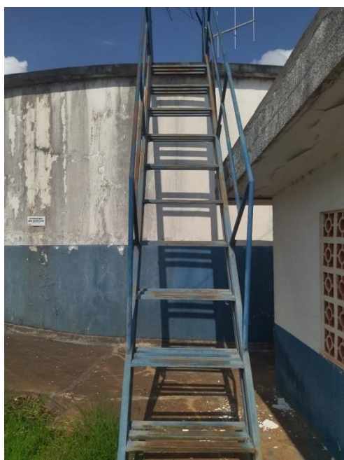
Foto 44: Escadas de acesso.
