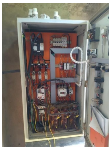
Foto 29: Quadro de comando. Foto 30: Ausencia de diagrama unifilar
