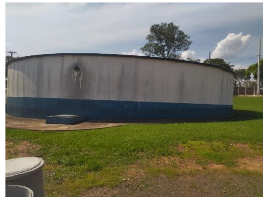
Foto 43: Vista geral do reservatório apoiado.
