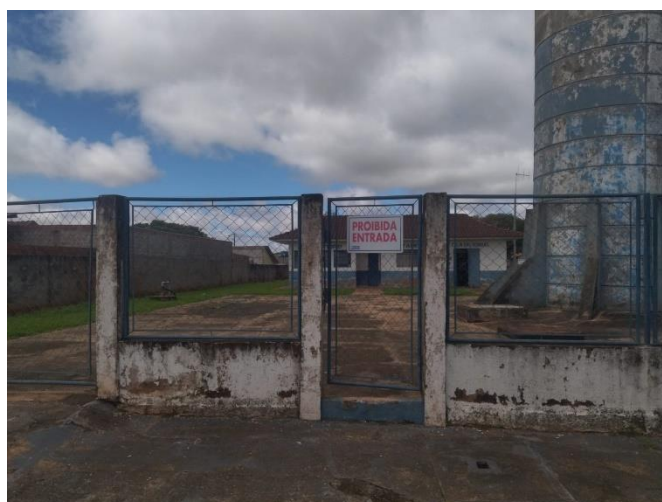
Foto 35: Acesso ao poço 04 (sem identificação de abastecimento público e outorga).
