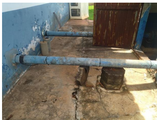
Foto 85: Ancoragens inadequadas.
