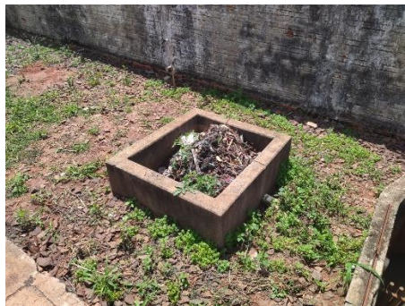
Foto 67: Disposição inadequada de lodo.
