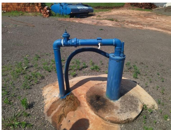
Foto 31: Estrutura do poço 03.
