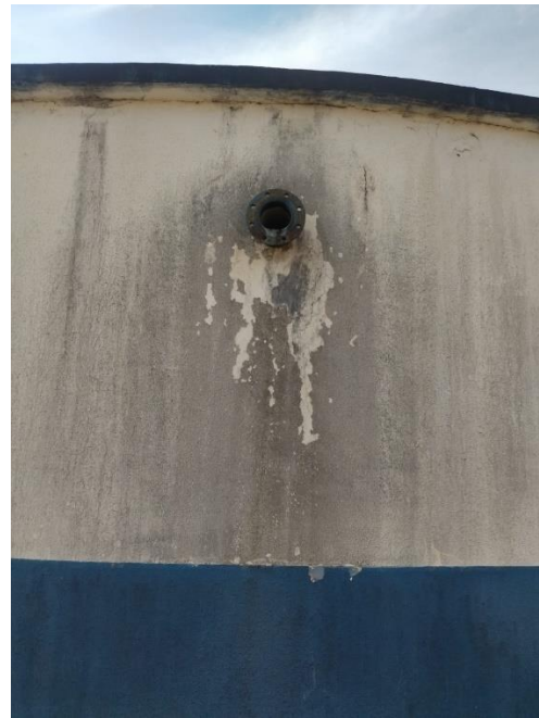
Foto 41: Locais sem telas de proteção.
