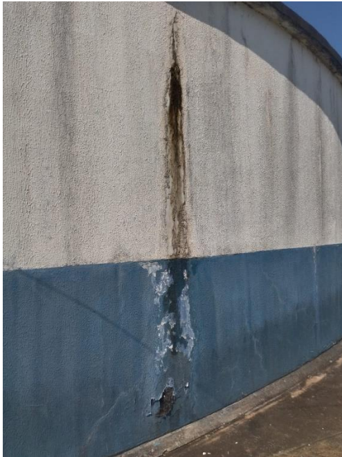
Foto 40: Vazamentos aparentes.
