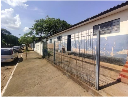
Foto 02: Condições estruturais (pintura e reparos).
