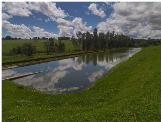
Foto 81: Vista geral (lagoa facultativa).
