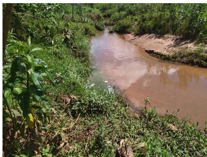
Foto 83: Ponto de lançamento (ausência de dissipador).
