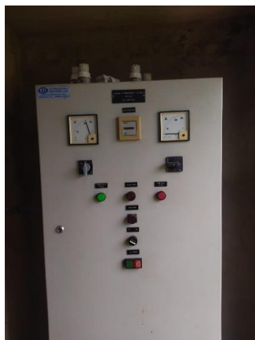
Foto 29: Quadro de comando. Foto 30: Ausencia de diagrama unifilar
