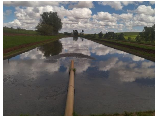
Foto 74: sinais de assoreamento (lagoa anaeróbia 01).
