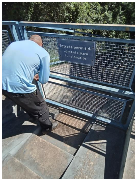
Foto 14 – Identificação captação rio
