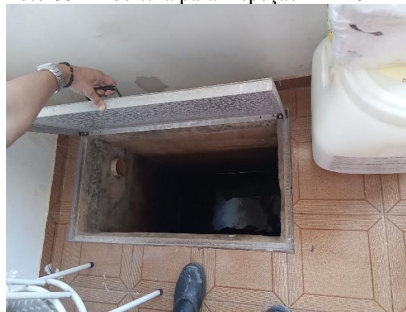
Foto 80 – Abertura para inspeção REN 02
