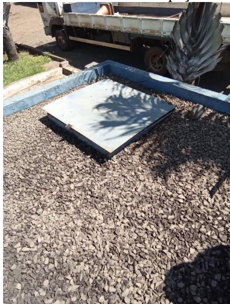
Foto 77 – Abertura de inspeção RAP sede
