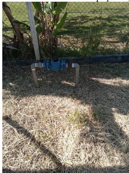
Foto 24 – Macromedidor poço Jangada
