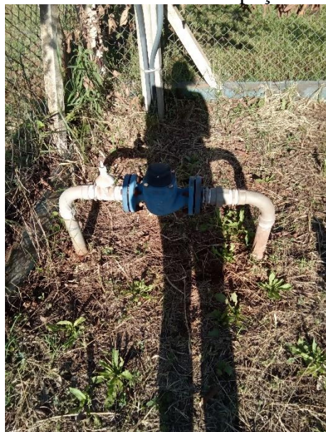
Foto 27 – Macromedidor poço Makuta
