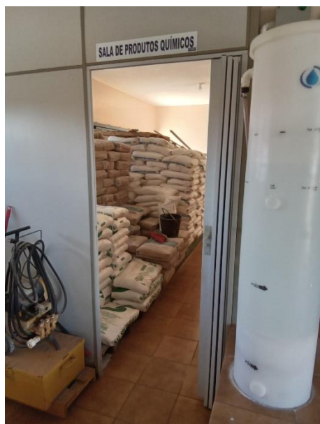
Foto 71 – Identificação de sala de produtos químicos
