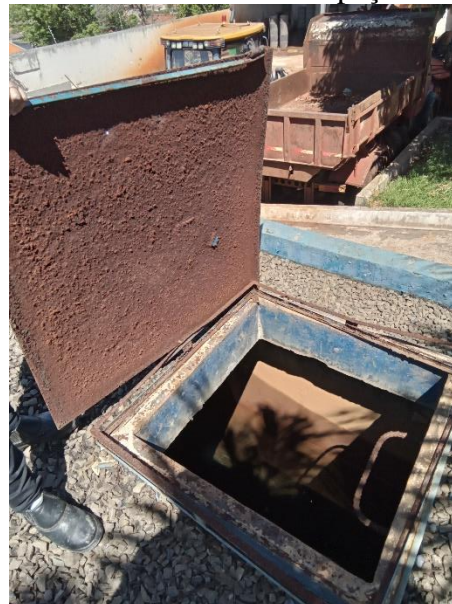
Foto 78 – Abertura de inspeção RAP sede
