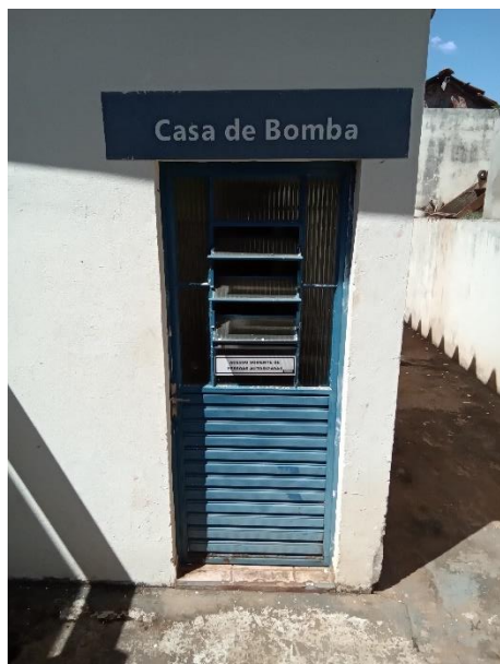
Foto 50 – Identificação elevatória sede (ETA)
