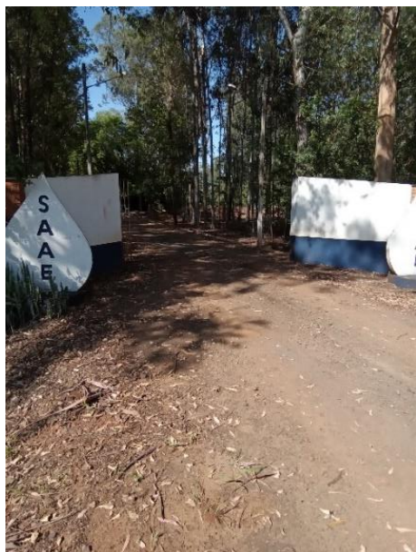
Foto 110 – Identificação ETE (entrada)
