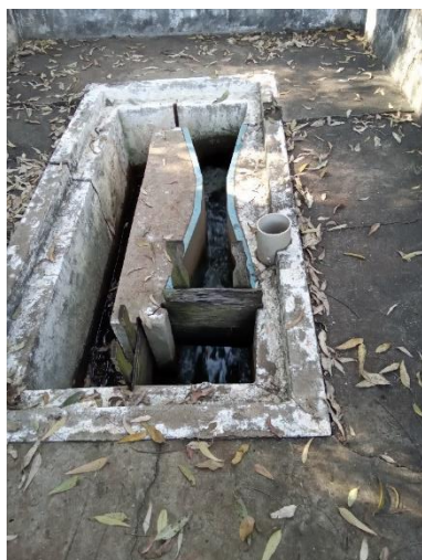
Foto 119 – Calha Parshall de saída
