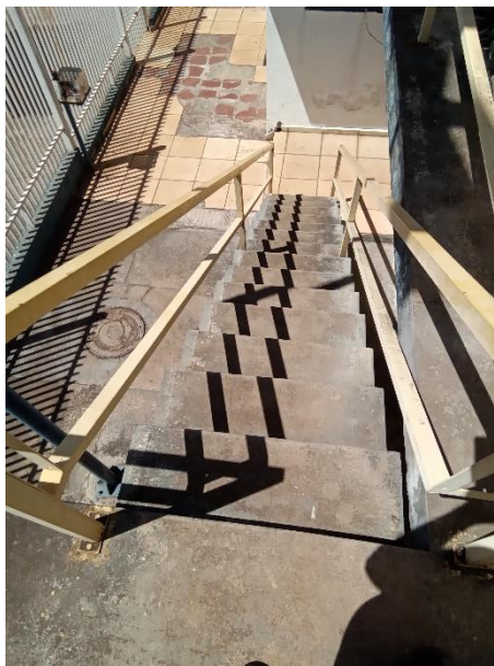
Foto 55 – Acesso a ETA
