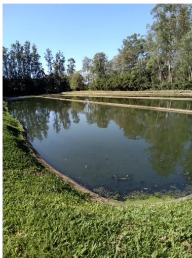
Foto 117 – Taludes da lagoa facultativa
