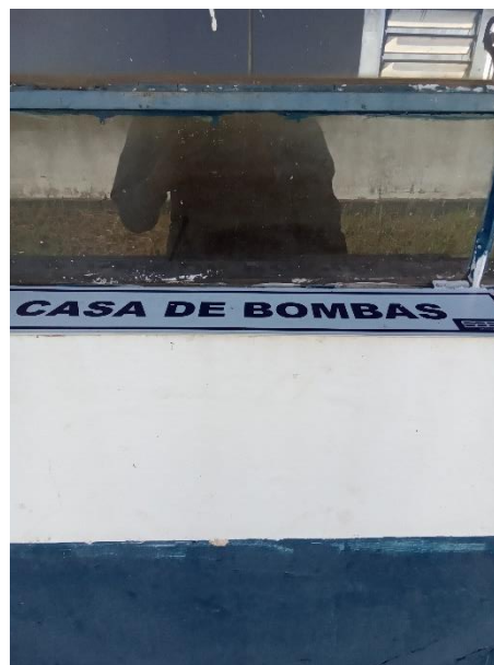
Foto 104 – Placa não colocada na Casa de Bombas EE do Badola
