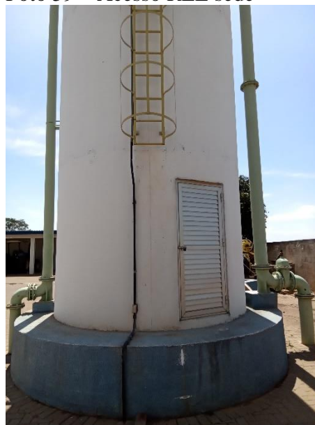
Foto 59 – Acesso REL sede
