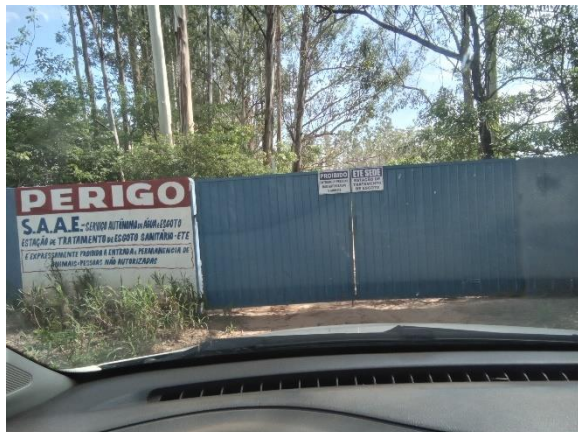
Foto 85 – Identificação ETE (entrada)
