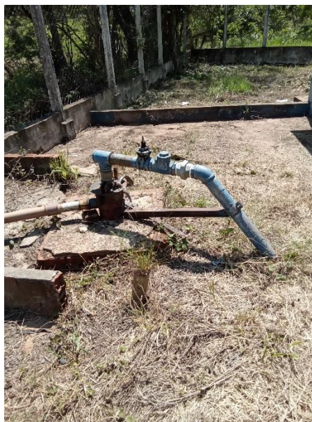
Foto 19 – Poço 2 (Vila Operária)
