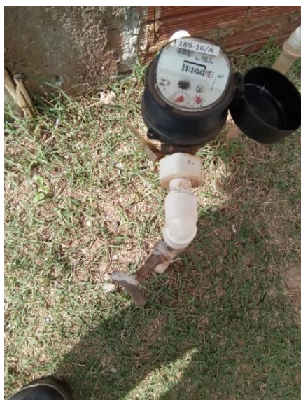
Foto 72 – Medição pressão na rede P01 P = 20.66 mca
