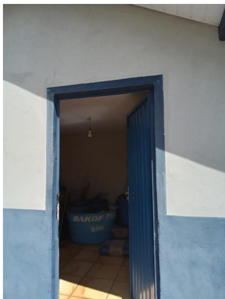
Foto 35 – Entrada casa de comando poço 1 – São José do Ivaí
