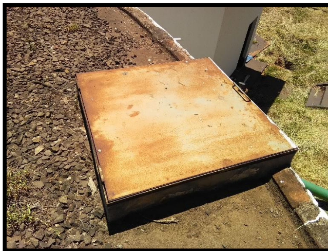
Imagem 23: Abertura de inspeção do reservatório apoiado 01
