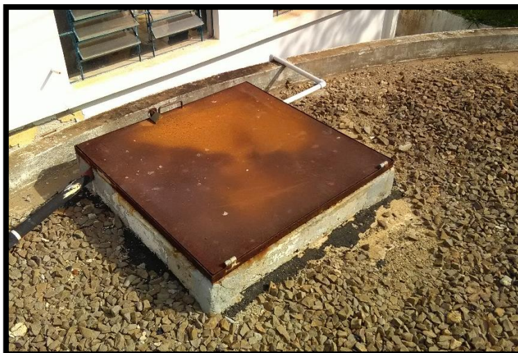
Imagem 20: Abertura de inspeção do reservatório semienterrado
