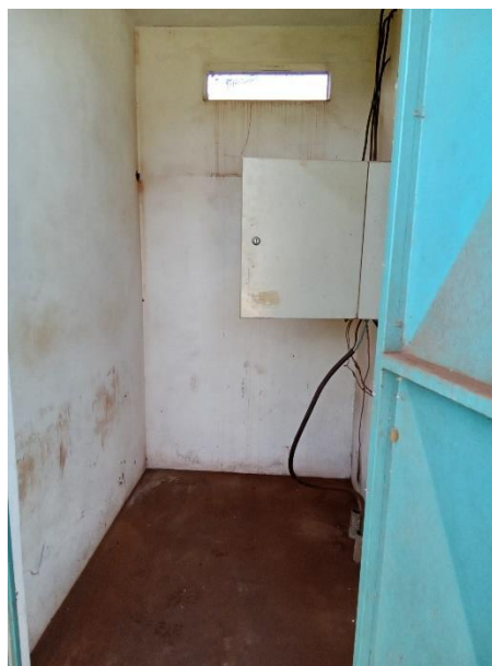
Foto 71 – Casa de comando poço Rambo
