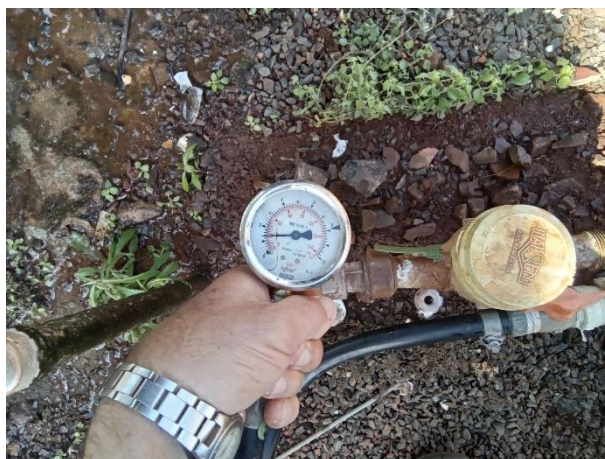
Foto 153 – Medição pressão na rede P02 = 20 mca
