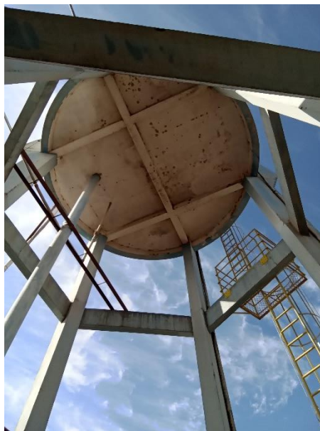
Foto 145 – Estrutura REL Centro de Eventos
