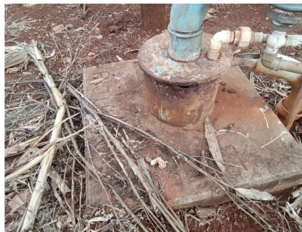
Foto 49 – Detalhe tubo de tampa poço Edézio
