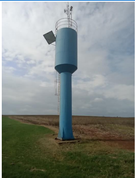
Foto 130 – Vazamento RAP Vilson
