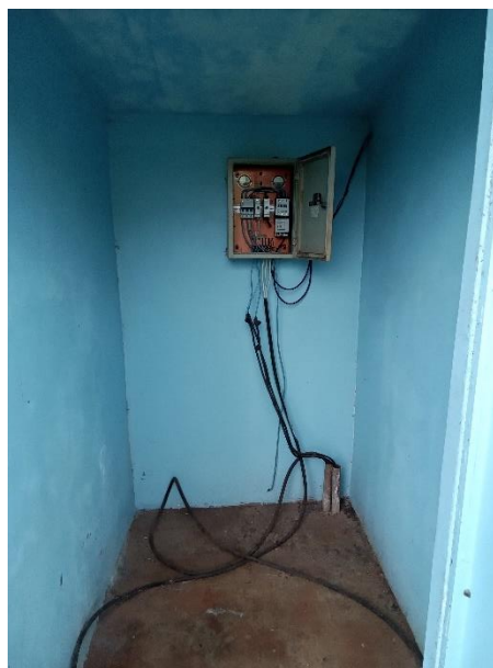
Foto 63 – Casa de comando e frente poço Valdemar Klein
