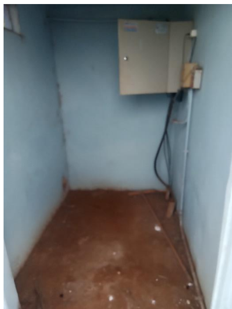
Foto 50 – Limpeza e manutenção casa de manutenção poço Edézio
