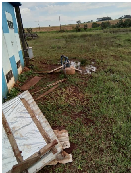
Foto 56 – Isolamento poço Hélio Bren
