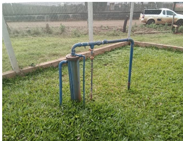
Foto 23 – Poço Oldemar Winter
