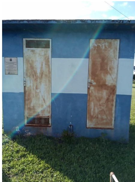
Foto 69 – Casa de comando poço Rambo
