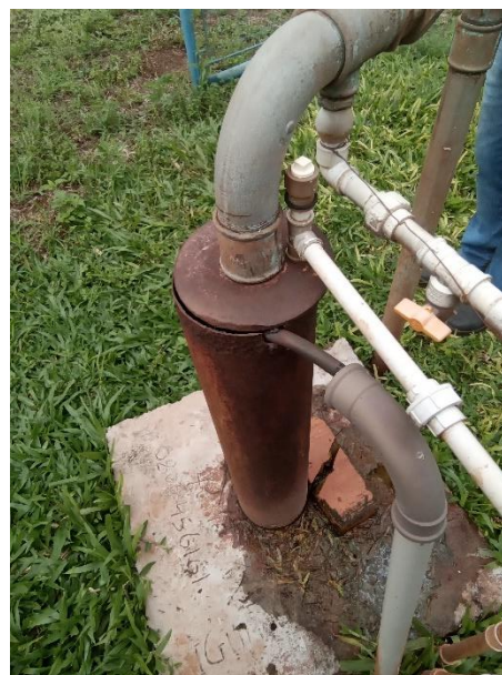
Foto 33 – Encaixe da tampa do poço Paulo Khun
