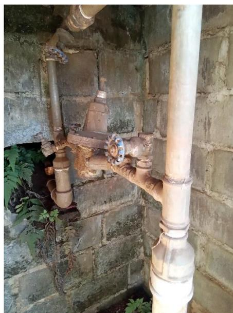
Foto 94 – Válvula redutora de pressão Av. Dalzoto (Latitude: 24°52' 32.02356''S – Longitude: 51° 32'34.7694''O)
