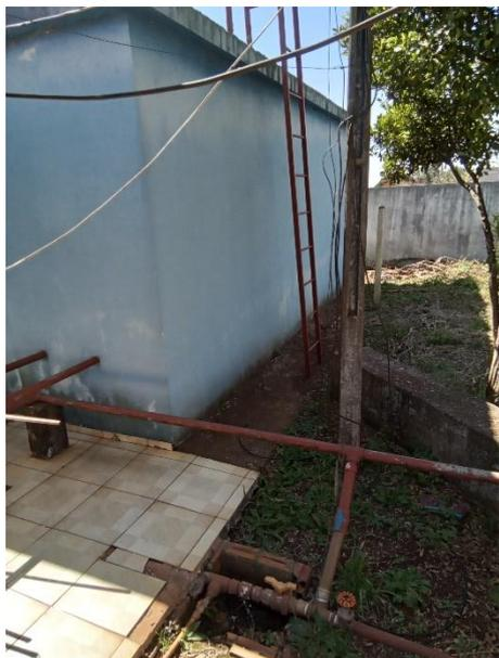
Foto 69 – Tampa de acesso inspeção RAP sede sem cadeado e excessivamente oxidada
