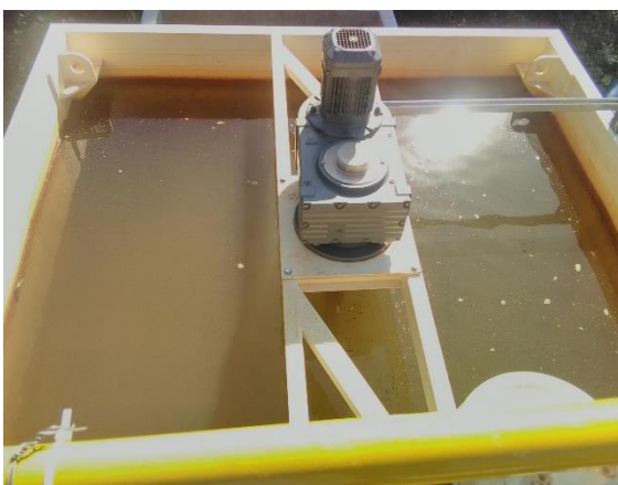
Foto 89 – Sem guarda corpo e escada de acesso ao conjunto moto bomba
