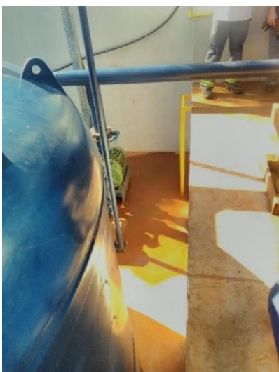
Foto 89 – Sem guarda corpo e escada de acesso ao conjunto moto bomba
