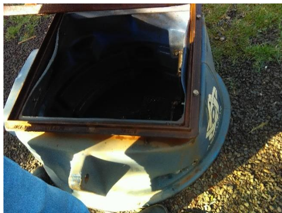
Foto 178 – Abertura inspeção EEE 001
