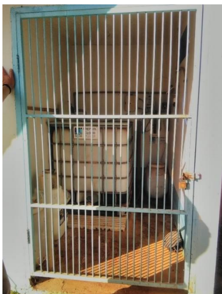
Foto 66 – Bombas dosadoras de cloro e flúor UTA 03
