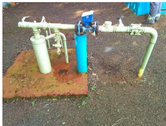
Foto 43 – Poço tubular profundo 107
