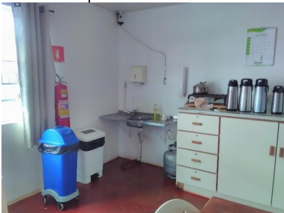
Foto 15: Gás próximo ao almoarifado
