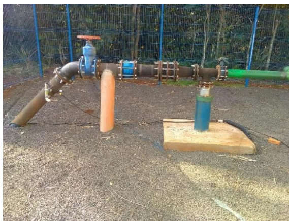
Foto 53 – Poço tubular profundo 20
