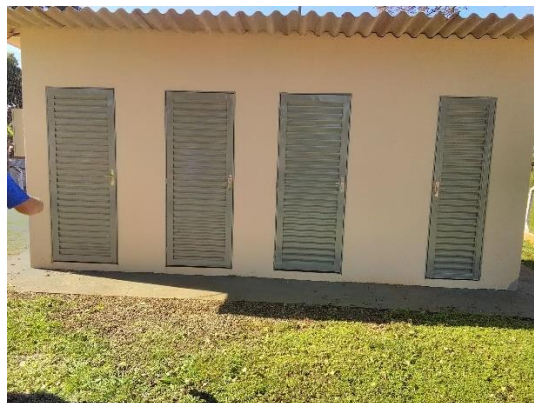
Foto 21 – Identificação abrigo casa de comando poço
