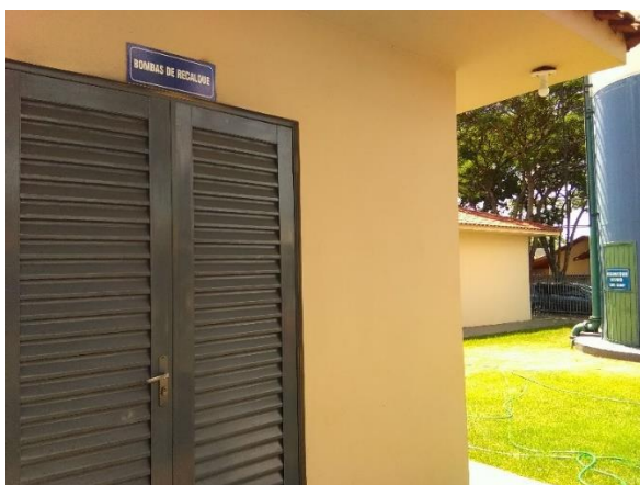
Foto 37 – Entrada da elevatória
