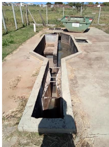
Foto 107 – Caixa de areia e calha Parshall elevatória J. Europa
