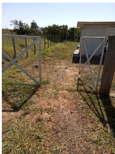
Foto 102 – Falta de identificação
