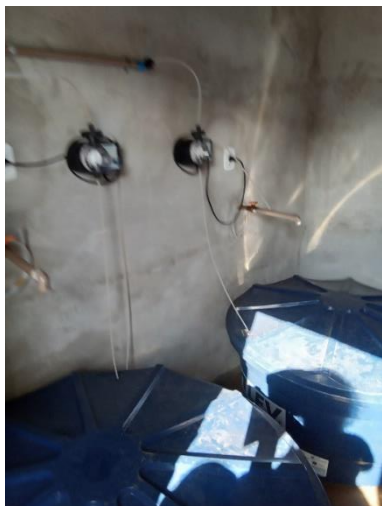
Foto 63 – Bombas dosadoras UTA Horizonte
