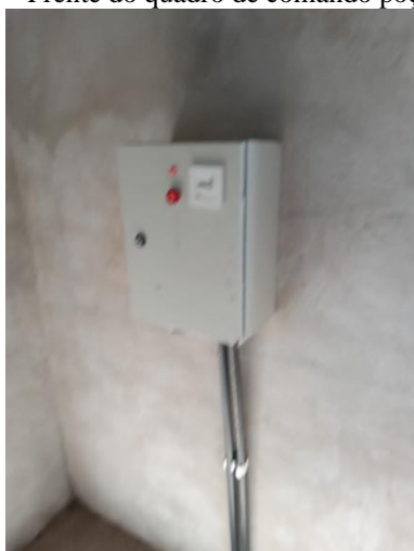
Foto 18 – Frente do quadro de comando poço Braga
