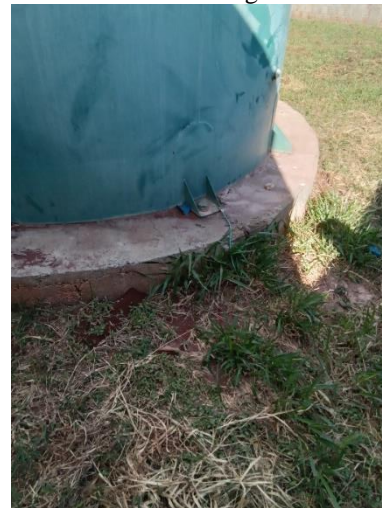
Foto 76 – Verificar sistema de para raio e aterramento o REL Braga
