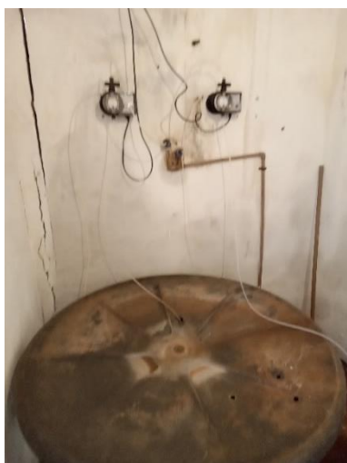
Foto 63 – Bombas dosadoras UTA Horizonte
