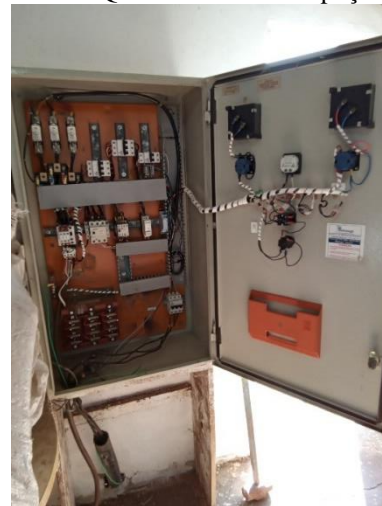
Foto 31 – Quadro de comando poço Horizonte
