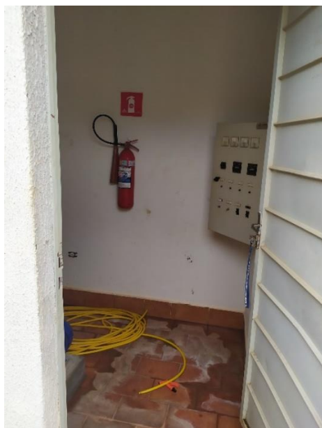
Foto 30 – Entrada da elevatória
