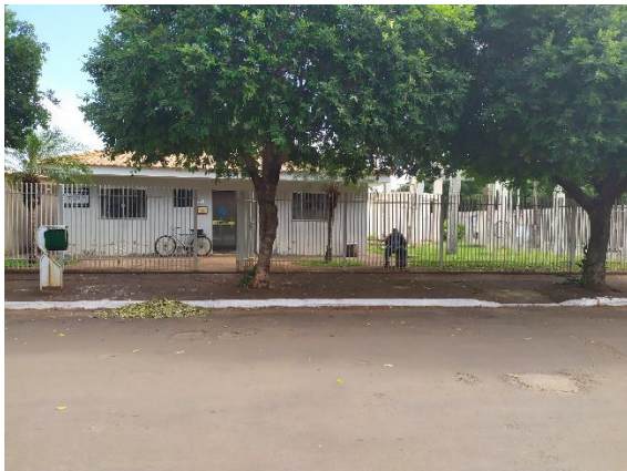
Foto 01: Fachada SAAE de Jardim Olinda
