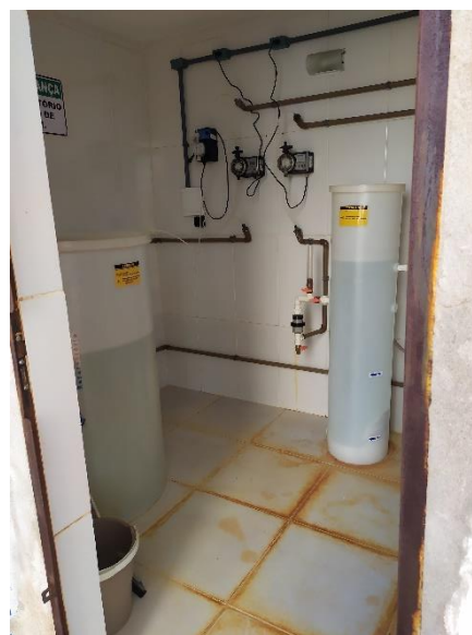
Foto 48 – Bombas dosadoras de cloro e flúor – Unidade 02
