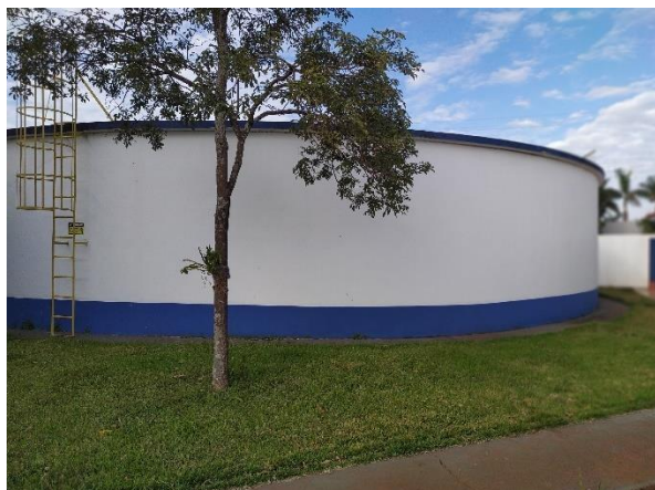
Foto 68 – Reservatório semienterrado sede
