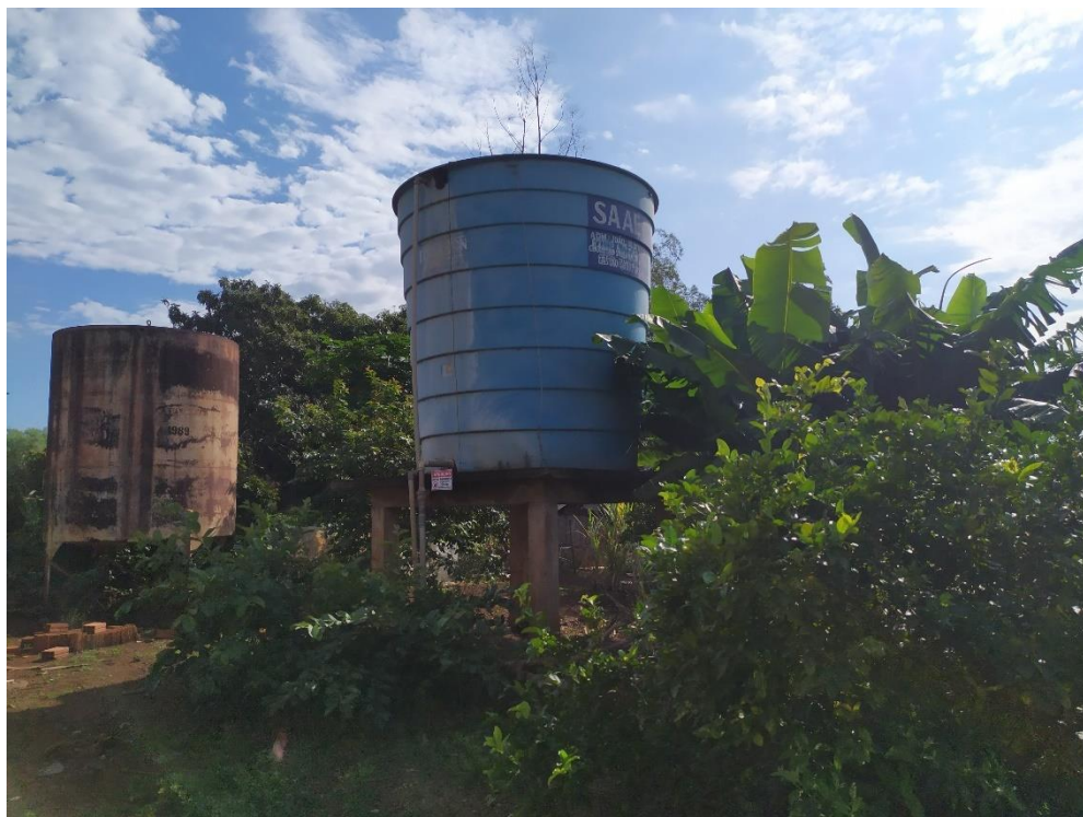
Foto 72 - Laje RAP distrito
