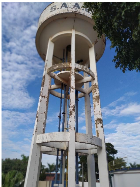
Foto 66 – Reservatório elevado (sede)
