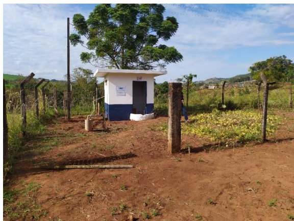
Foto 13 – Isolamento poço Silvolândia
