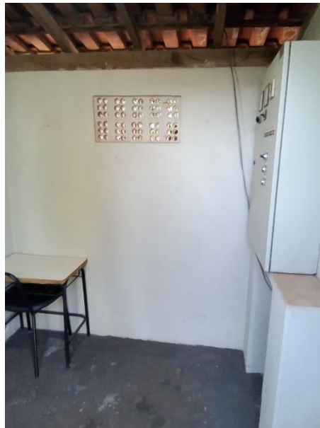
Foto 21 – Casa de comando sede
