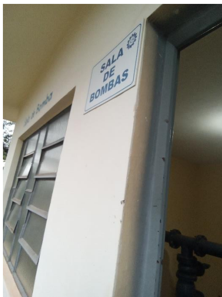
Foto 24 – Identificação casa de comando sede
