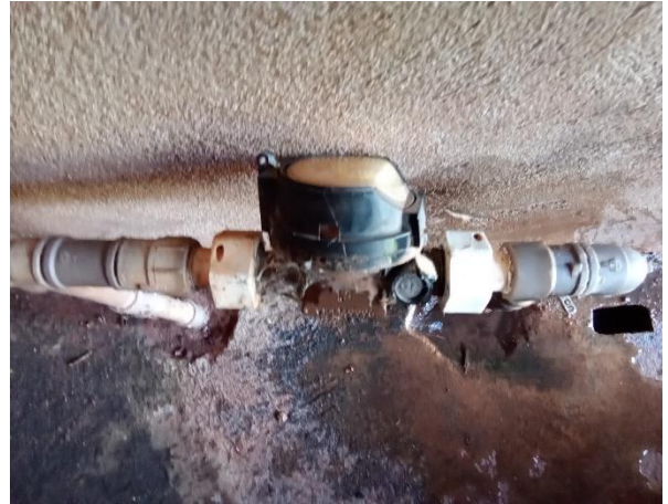
Foto 53 – Hidrômetro P02 – P = 71.00 mca
