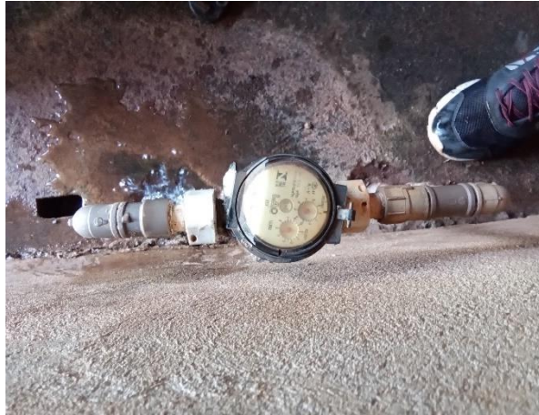
Foto 53 – Hidrômetro P02 – P = 71.00 mca
