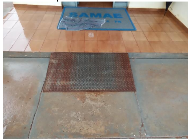
Foto 2 – Rampa de acesso
