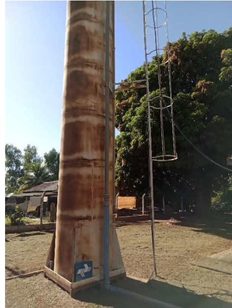
Foto 41 – Escada de acesso REL distrito
