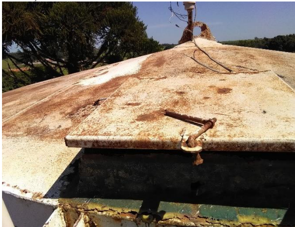
Foto 38 – Tampa acesso REL sede (foto 2021)
