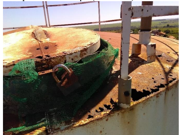
Foto 43 – Tampa de acesso REL distrito e situação estrutura topo (foto 2021)
