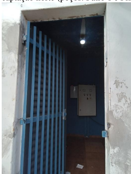
Foto 20 – Porta de acesso casa de comando captação norte (poços: Pátio 1 e Piscina)
