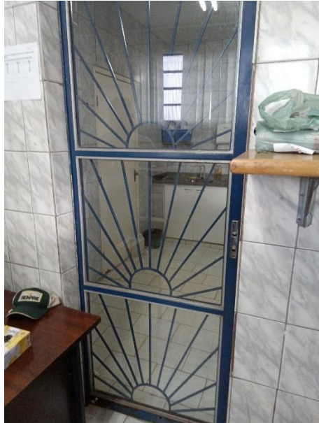
Foto 92 – Acesso laboratório de análises físico químicas
