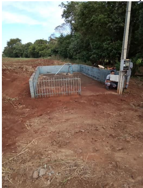
Foto 28 – Acesso e isolamento Poço Cabreira
