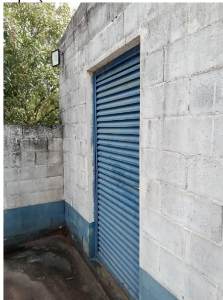
Foto 27 – Entrada casa de comando captação leste
