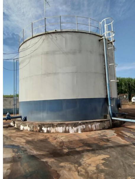
Foto 64 – Reservatório zona leste (água bruta)
