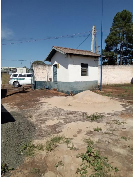
Foto 48 – Casa de comando recalque setor sul
