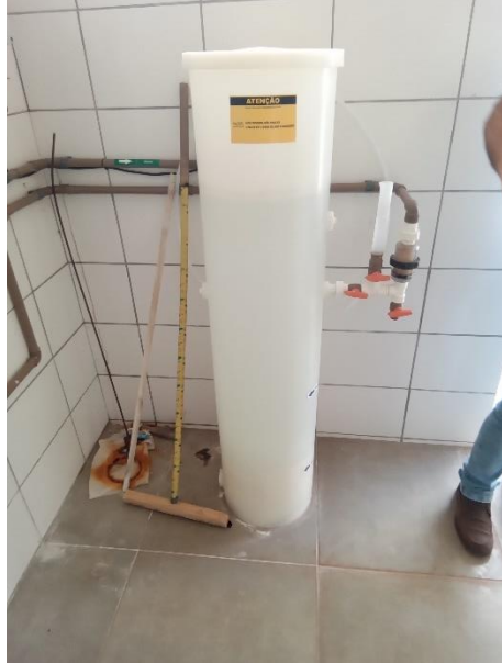
Foto 55 – Tanque de flúor UTA leste
