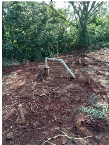
Foto 16 – Poço Pátio 1 Norte
