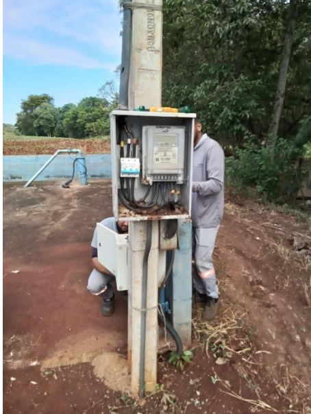
Foto 30 – Padrão de energia poço Cabreira
