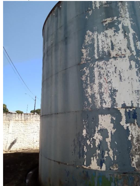
Foto 66 – Reservatório zona sul (lateral direita)
