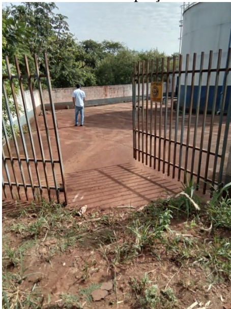
Foto 24 – Acesso captação leste
