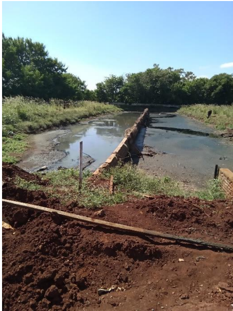
Foto 110 – Lagoa facultativa 01 (presença de gado no local)
