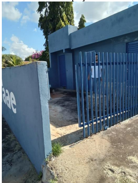
Foto 34 – Acesso poço Santa Ruth
