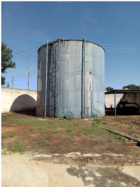
Foto 65 – Reservatório zona sul
