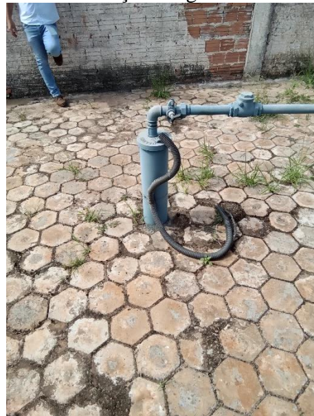
Foto 33 – Poço Tibagi III
