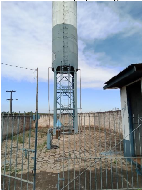
Foto 32 – Acesso poço Tibagi III
