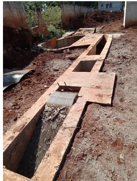
Foto 105 – Detalhe gradeamento
