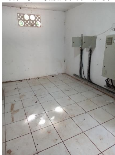
Foto 43 – Casa de comando elevatória leste
