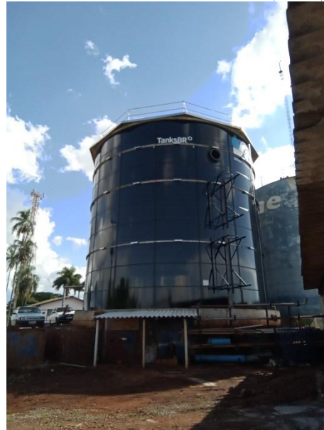
Foto 78 – Reservatório sede (novo)
