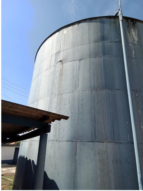
Foto 67 – Reservatório zona sul
