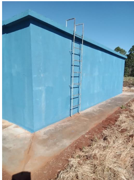
Foto 47 – Escada de acesso RAP
