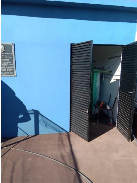
Foto 80 – Casa de comando
