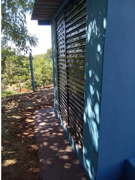
Foto 22 – Entrada casa de comando poço Vila Rural
