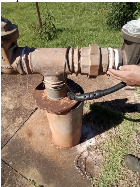
Foto 17 – Encaixe poço Matida (direita) com tampa desalinhada
