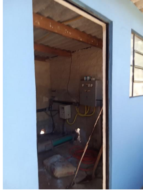
Foto 72 – Casa de comando elevatória
