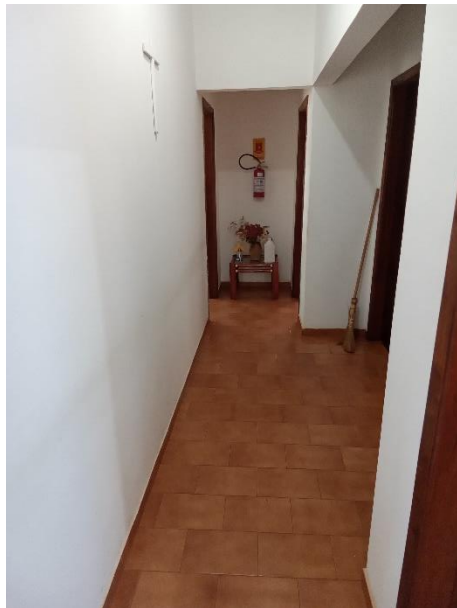
Foto 5 – Falta de identificação ambientes
