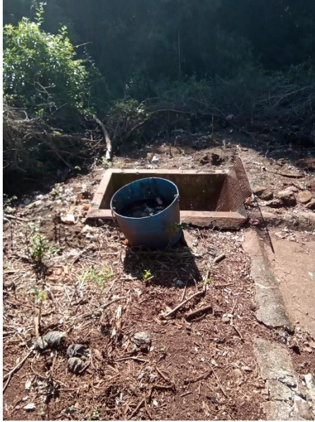
Foto 71 – Gradeamento elevatória
