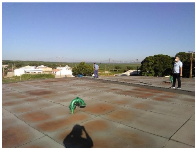
Foto 35 – Cobertura reservatório apoiado
