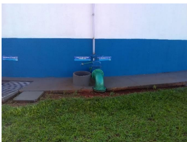
Foto 39 – Saída Zona baixa reservatório apoiado
