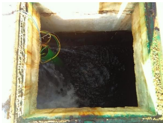
Foto 38 – Parte interna reservatório apoiado
