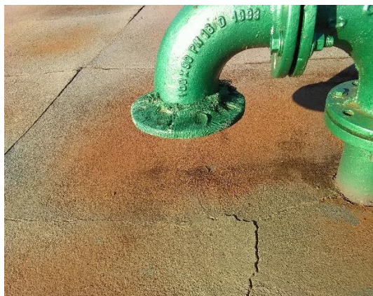
Foto 36 – Respiro reservatório elevado
