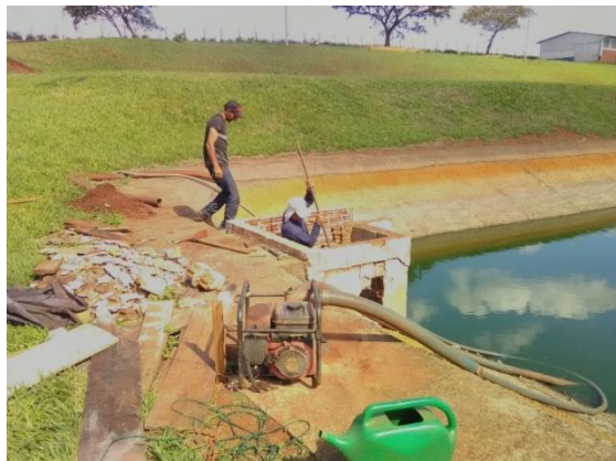
Foto 70 – Reforma saída lagoa anaeróbia 02
