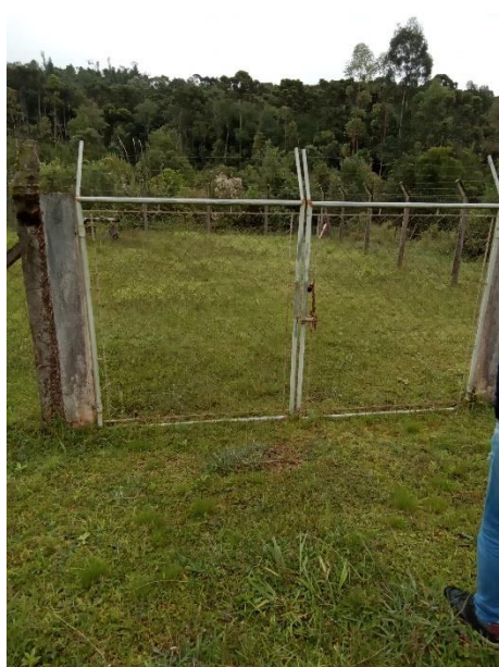
Foto 12 – Falta de identificação poço sede
