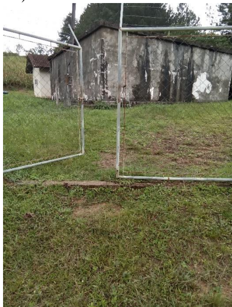
Foto 23 – Acesso reservatório apoiado (30 m 3 )
