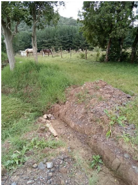
Foto 38 – Problemas no acesso a ETE
