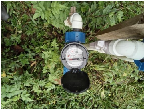
Foto 31 – Hidrômetro P01 – P = 5.60 mca (8 psi)
