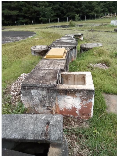
Foto 41 – Gradeamento, caixa de areia e calha Parshall (com tampas de concreto)
