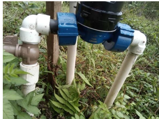
Foto 31 – Hidrômetro P01 – P = 5.60 mca (8 psi)
