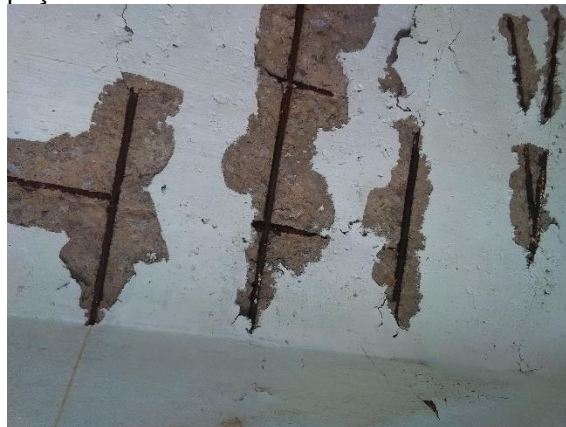
Foto 34 – Armadura exposta da casa de bombas poço da Horta
