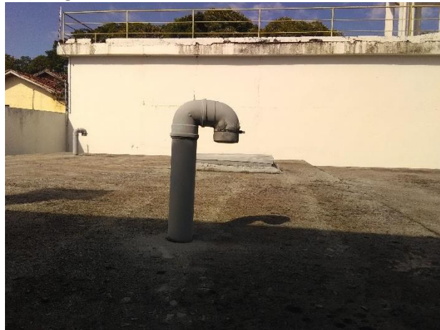
Foto 65 – Respiro reservatório semi enterrado 100 m 3 segunda célula
