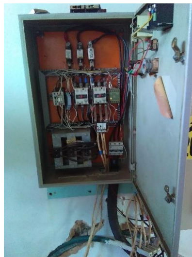
Foto 25 – Identificação poço sede
