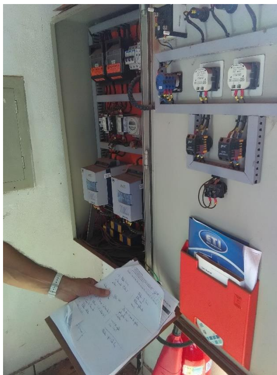
Foto 142 – Quadro de comando elevatória bacia 03
