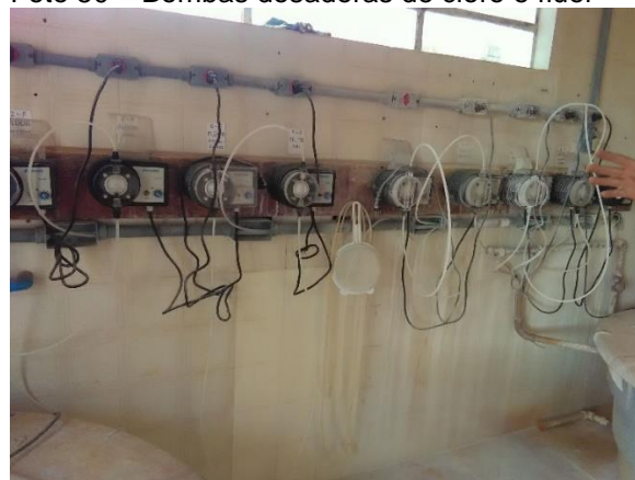
Foto 50 – Bombas dosadoras de cloro e flúor
