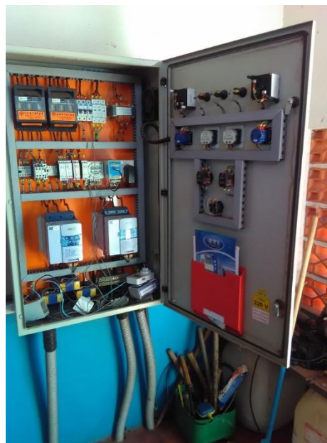
Foto 94 – Quadro de comando Booter (recalque água tratada)
