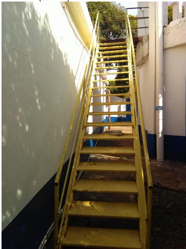
Foto 66 – Escada de acesso reservatório semi enterrado (800 m 3 )
