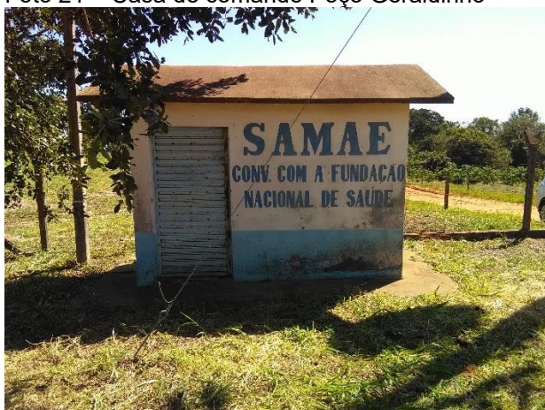
Foto 21 – Casa de comando Poço Geraldinho
