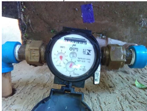
Foto 105 – Hidrômetro Rua 15 de Novembro, nº. 50 (Latitude: -23.071593661679337° – Longitude: - 52.01329808645099°)
