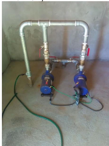
Foto 84 – Conjunto moto bomba elevatória campo
