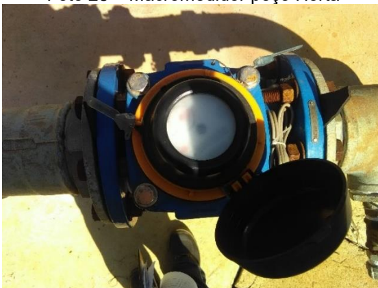
Foto 28 – Macromedidor poço Horta
