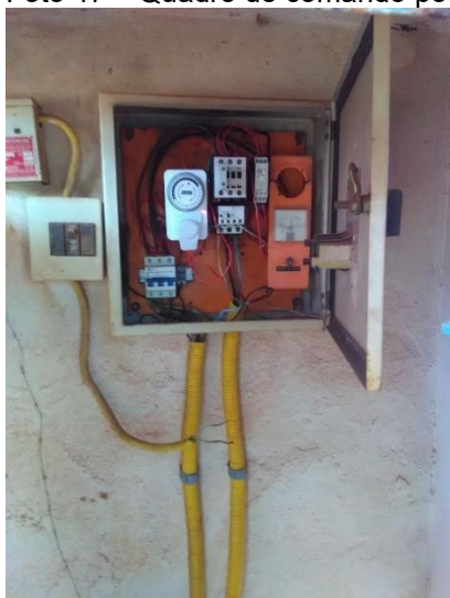
Foto 47 – Quadro de comando poço Antena
