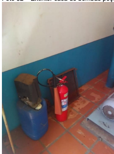
Foto 32 – Extintor casa de bombas poço da Horta
