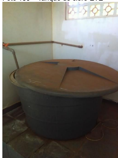
Foto 130 – Tanque de cloro ETE
