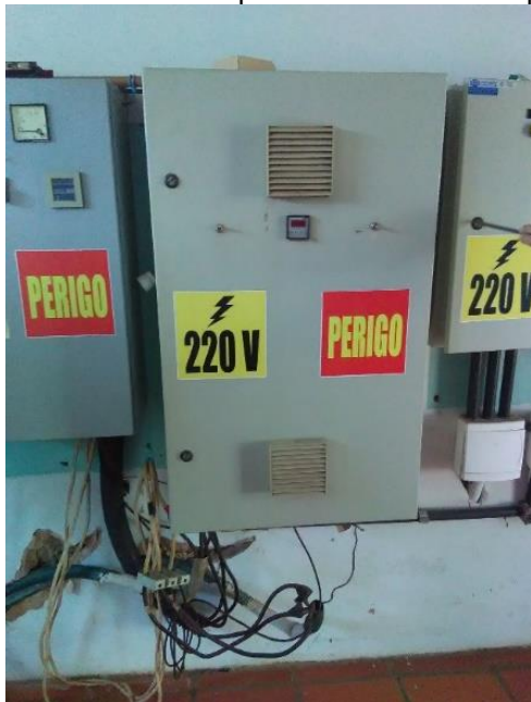
Foto 89 – Frente quadro comando recalque sede
