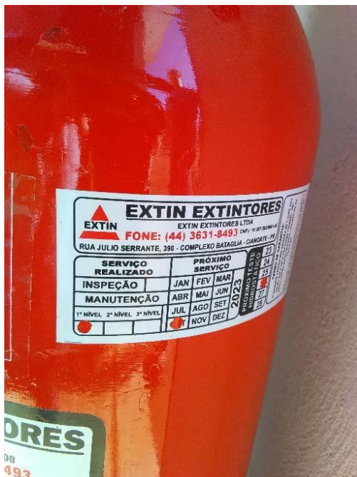
Foto 147 – Extintor Casa de máquinas elevatória bacia 03
