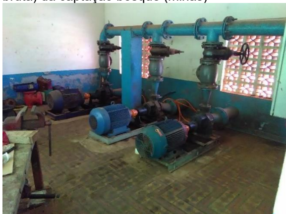
Foto 75 – Conjunto moto bomba da elevatória (água bruta) da captação bosque (minas)
