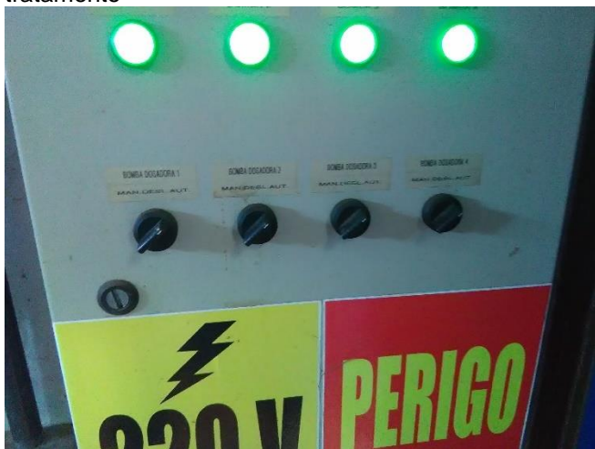
Foto 56 – Frente do quadro de comando da unidade de tratamento
