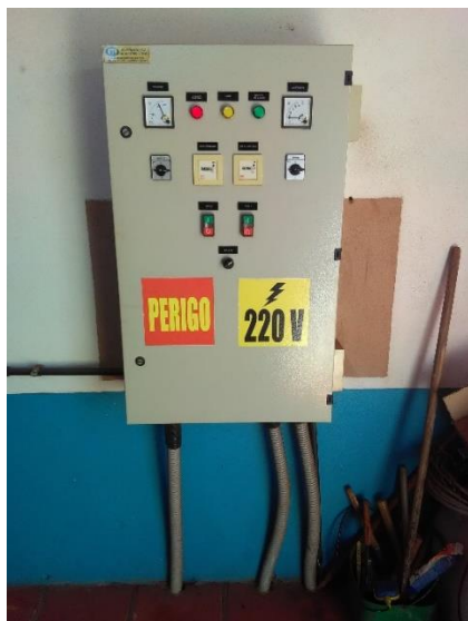
Foto 93 – Frente quadro de comando Booster (recalque água tratada)
