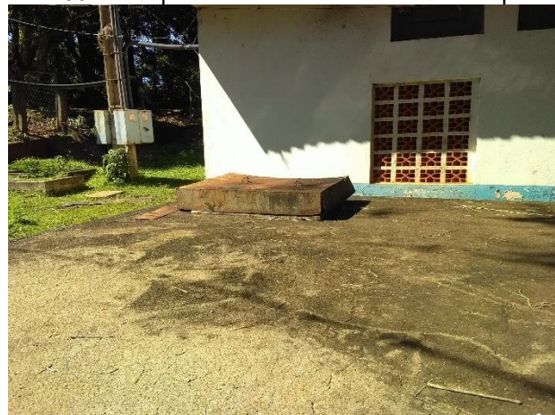
Foto 59 – Tampa de abertura reservatório bosque
