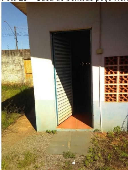
Foto 29 – Casa de bombas poço Horta
