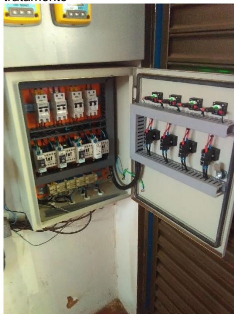
Foto 57 – Quadro de comando da unidade de tratamento
