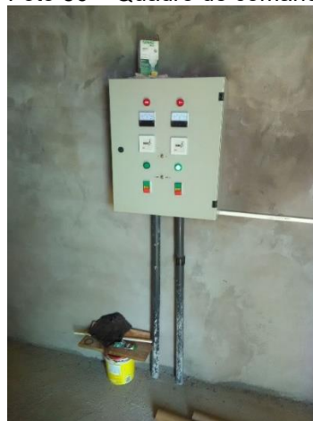
Foto 86 – Quadro de comando elevatória campo
