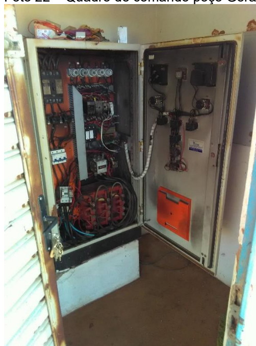
Foto 22 – Quadro de comando poço Geraldinho
