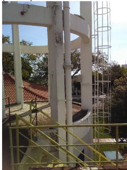
Foto 71 – Guarda corpo reservatório semi enterrado (800 m 3 ) e escada REL sede
