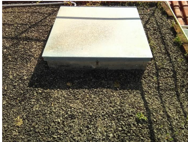
Foto 67 – Tampa de acesso ao reservatório semi enterrado (800 m 3 )
