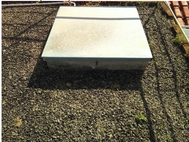
Foto 68 – Tampa acesso reservatório semi enterrado (800 m 3 )
