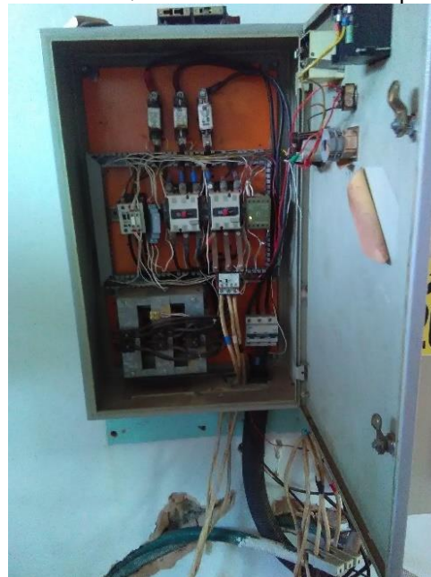
Foto 90 – Quadro de comando recalque sede
