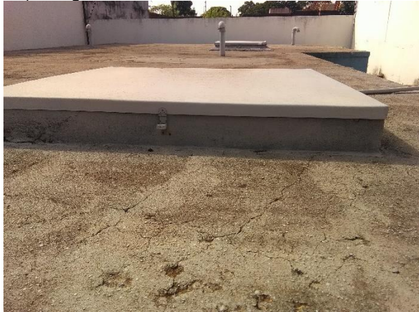
Foto 64 – Tampa reservatório semi enterrado (100 m 3 ) – segunda célula
