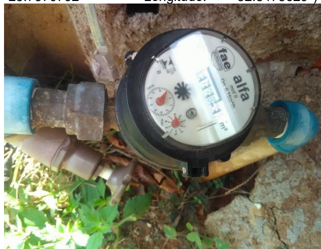
Foto 99 – Hidrômetro Rua Genova, nº 860 (Latitude: -23.7370792° – Longitude: -52.8475629°)
