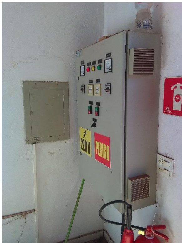
Foto 141 – Frente quadro de comando elevatória bacia 03
