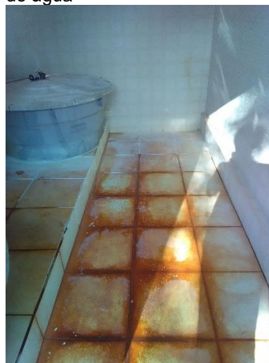
Foto 52 – Piso e manutenção unidade de tratamento de água
