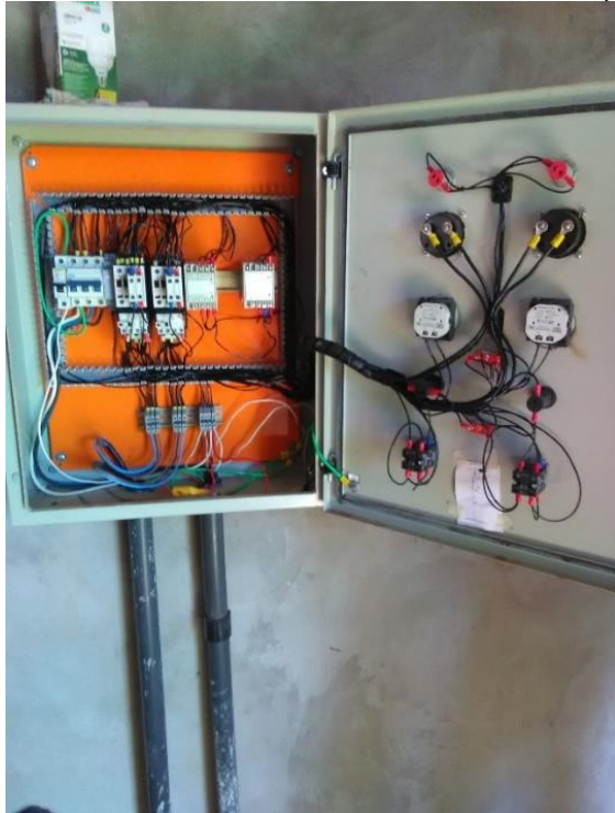
Foto 87 – Quadro de comando elevatória campo
