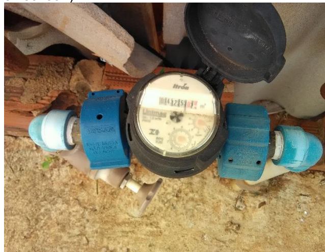
Foto 102 – Hidrômetro Rua Francisco Geovanelli, nº. 1032 1032 (Latitude: - 23.74097° , Longitude: - 52.85233° )
