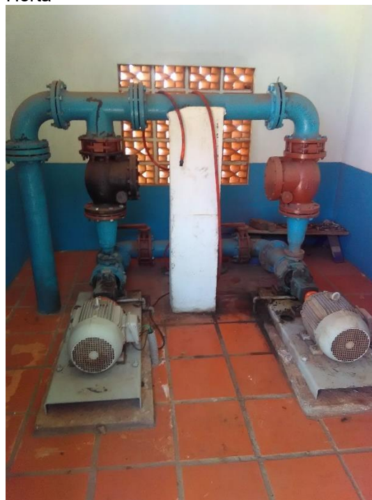
Foto 80 – Conjunto moto bomba Estação Elevatória Horta
