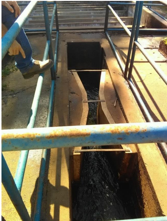
Foto 131 – Calha Parshall saída da ETE
