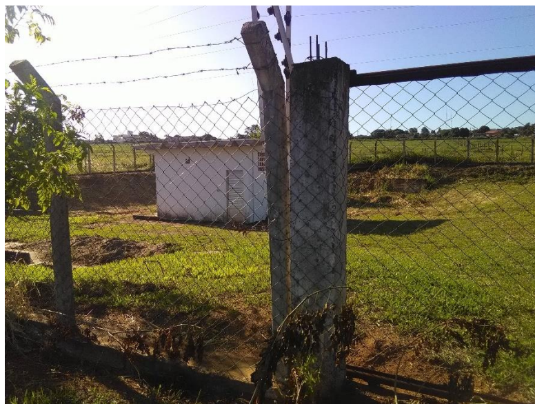
Foto 148 – Estação elevatória Bacía 2 (Posto Roseira)
