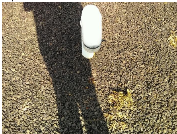
Foto 69 – Respiro reservatório semi enterrado (800 m 3 )
