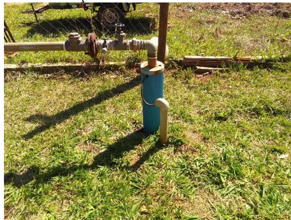
Foto 42 – Poço da Antena
