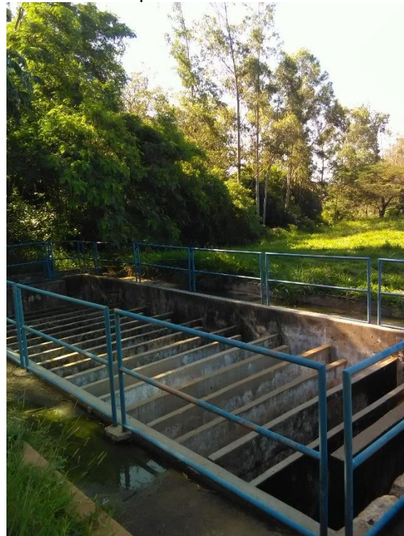
Foto 132 – Tanque de cloro ETE
