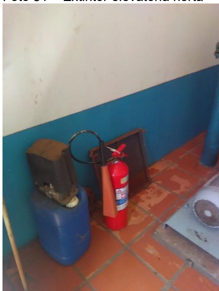
Foto 81 – Extintor elevatória horta
