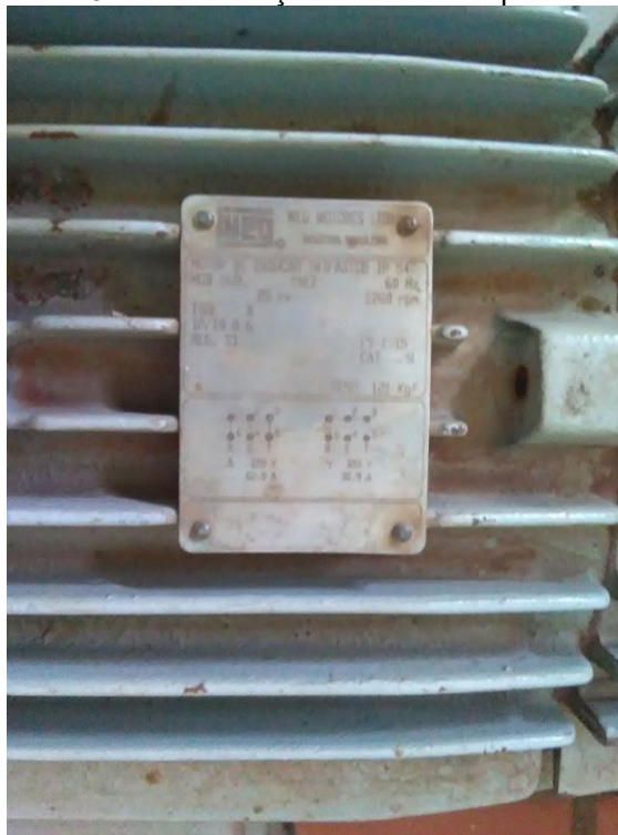
Foto 91 – Identificação bomba recalque sede
