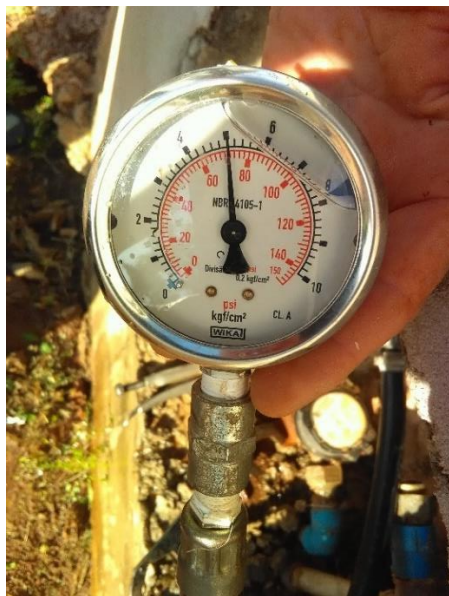
Foto 95 – Medição pressão na rede: Latitude: -23.7344735° - Longitude: - 52.84477179 - P=71 mca
