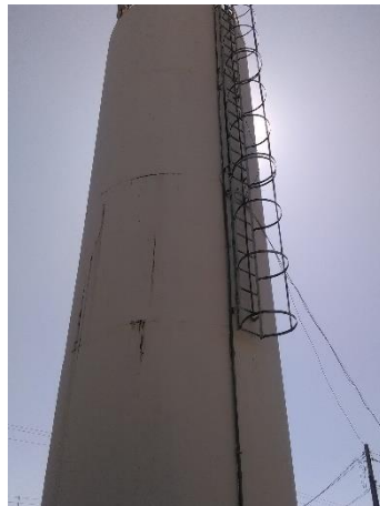
Foto 61- Reservatório elevado campo
