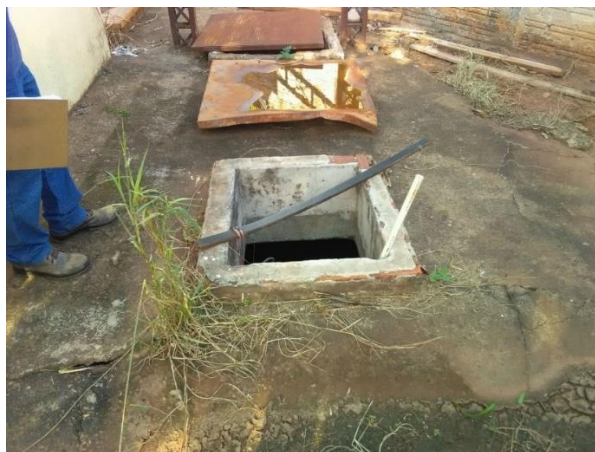
Foto 146 – Falta de tampa elevatória bacía 03
