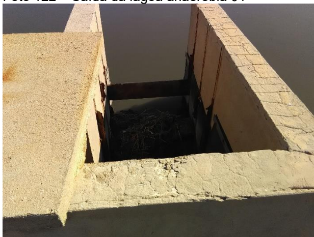
Foto 122 – Saída da lagoa anaeróbia 01
