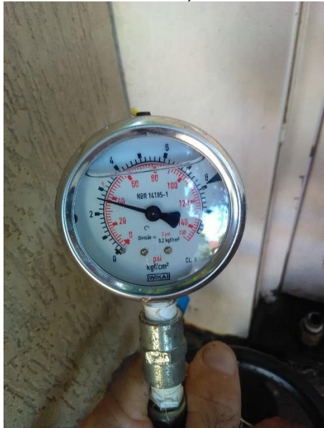
Foto 104 – Medição pressão na rede Rua 15 de Novembro, nº. 50 (Latitude: - 23.071593661679337° – Longitude: - 52.01329808645099°) - P=37 mca
