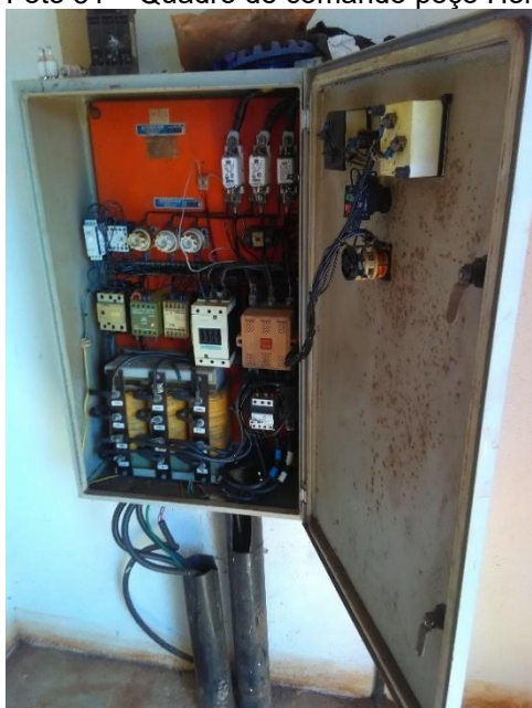
Foto 31 – Quadro de comando poço Horta
