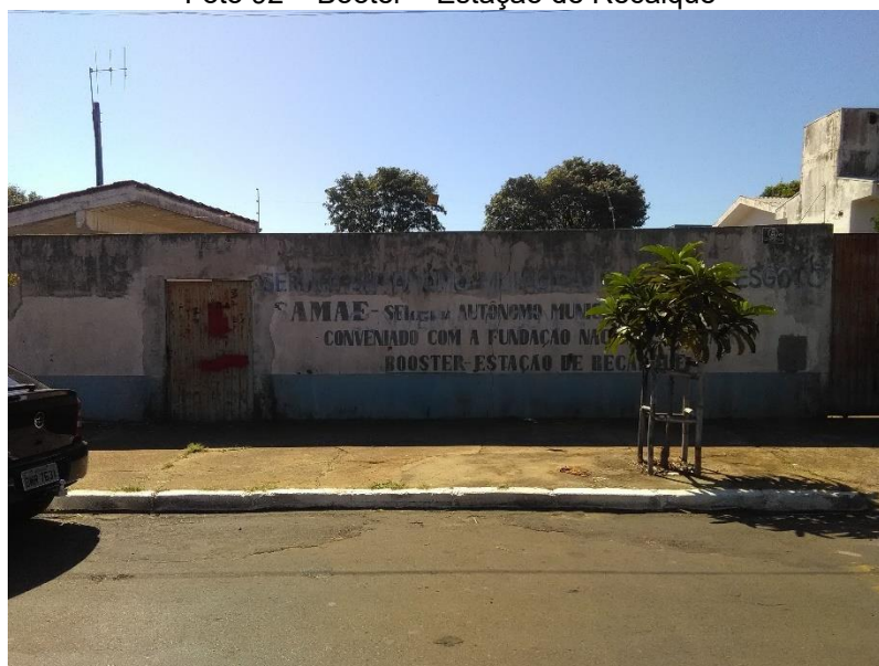
Foto 92 – Booter – Estação de Recalque
