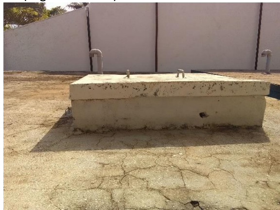
Foto 63 – Tampa reservatório semi enterrado 100 m 3 (segunda célula)
