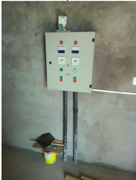
Foto 39 – Frente quadro de comando poço Campo
