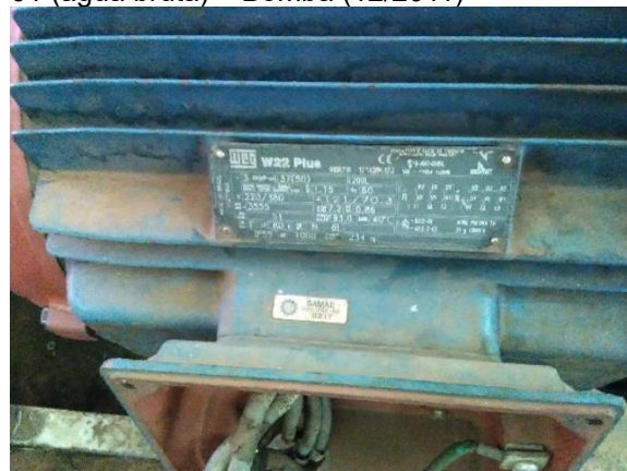
Foto 76 – Identificação bomba elevatória captação 01 (água bruta) – Bomba (12/2011)
