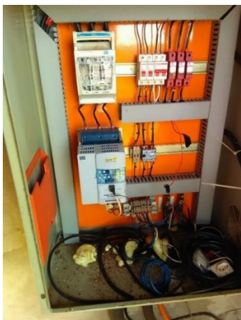
Foto 137 – Quadro de comando estação elevatória 03
