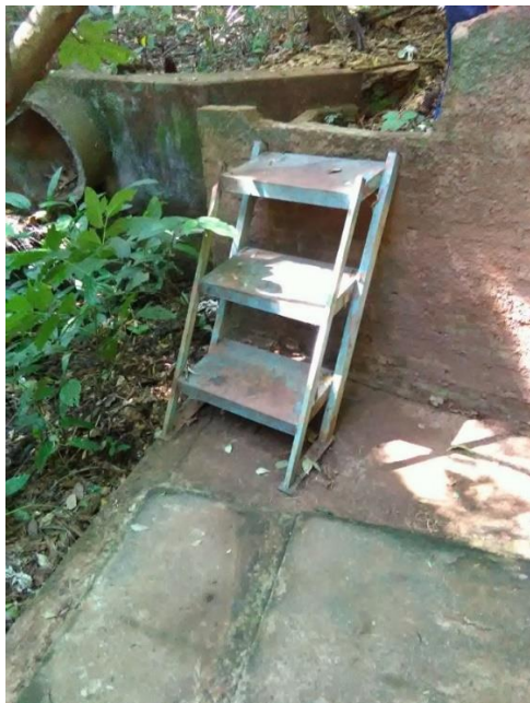
Foto 17 – Escada de acesso Mina 02
