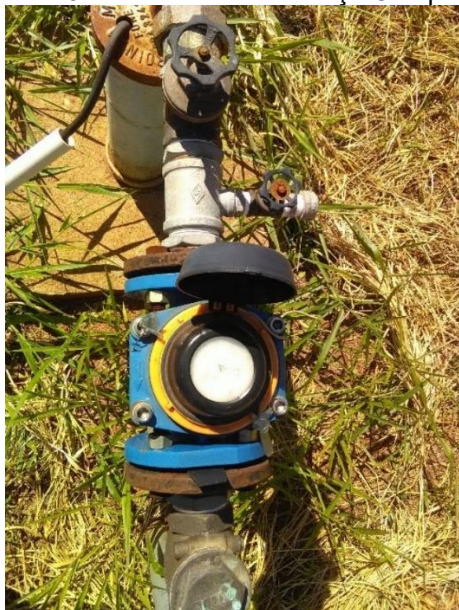
Foto 37 – Macromedidor Poço Campo
