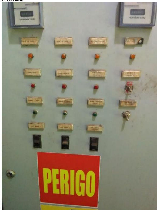
Foto 77 – Frente quadro de comando captação minas
