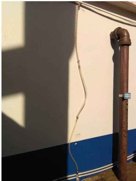
Foto 70 – Medidor de nível e extravasador de água tratada
