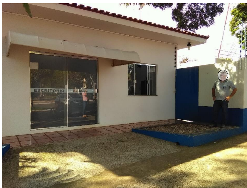
Foto 01 – Fachada área comercial
