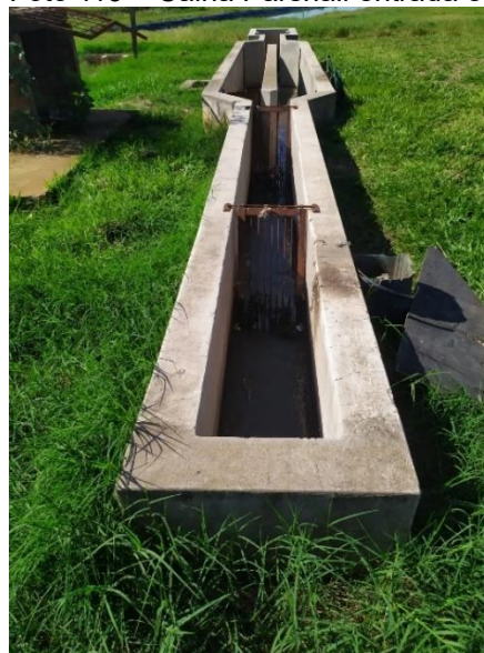
Foto 119 – Calha Parshall entrada e grades
