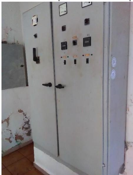
Foto 37 – Quadro de comando elevatória captação 01
