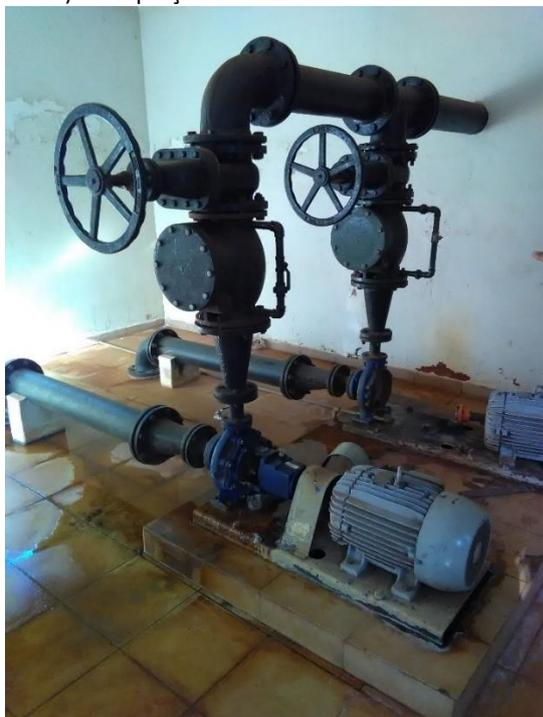
Foto 35 – Identificação bomba elevatória captação 01 (água bruta) – Bomba (01/2015)
