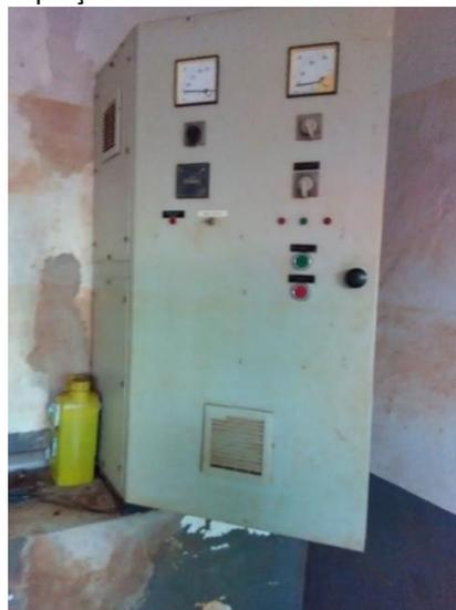
Foto 40 – Quadro de distribuição da elevatória da captação 02
