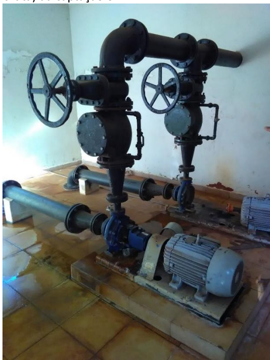
Foto 34 – Conjunto moto bomba do da elevatória (água bruta) da captação 01
