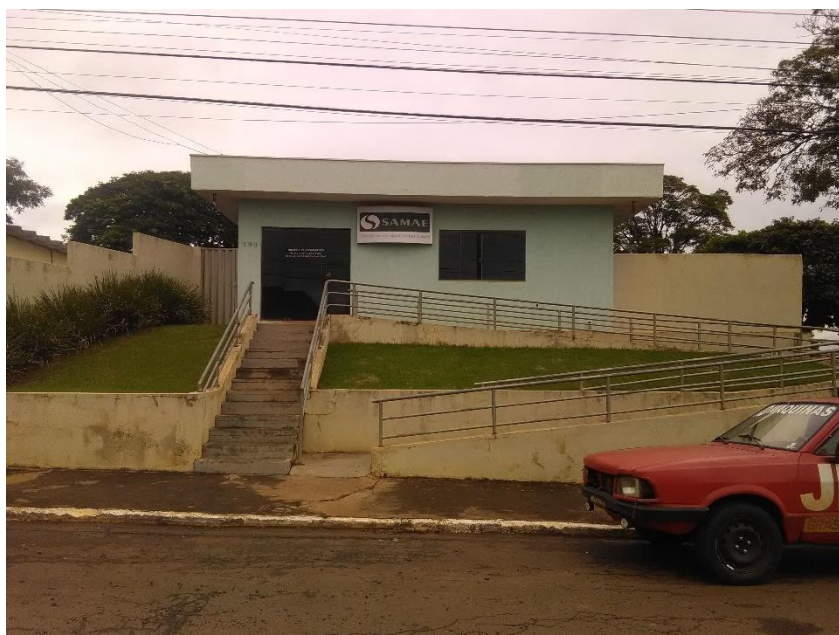
Foto 01 – Fachada área comercial
