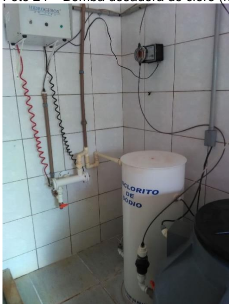
Foto 24 – Bomba dosadora de cloro (foto 02)
