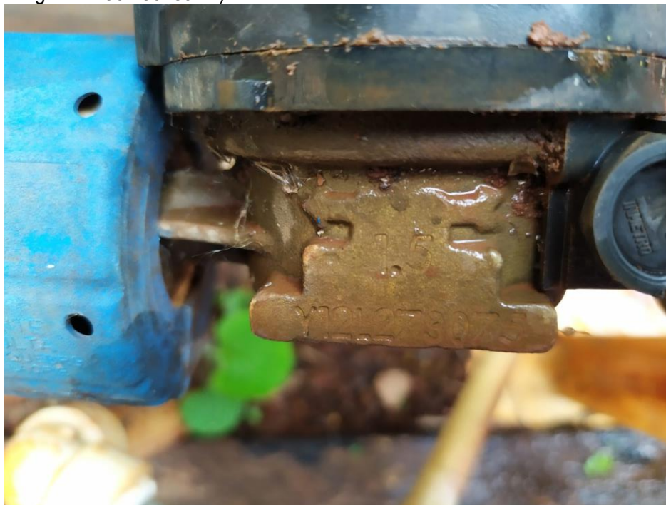
Foto 46 – Ano fabricação hidrômetro Estrada Principal nº. 31 (Latitude: -23.522590°S e Longitude: -50.786289°W)
