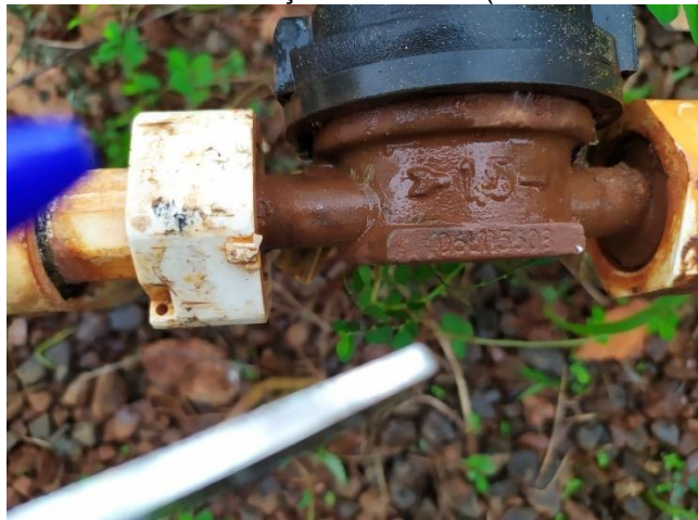
Foto 51 – Ano fabricação hidrômetro (Latitude: -23.5190657°S e Longitude: -50.7851217° W)
