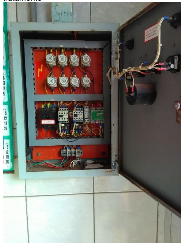
Foto 27 – Quadro de comando da unidade de tratamento
