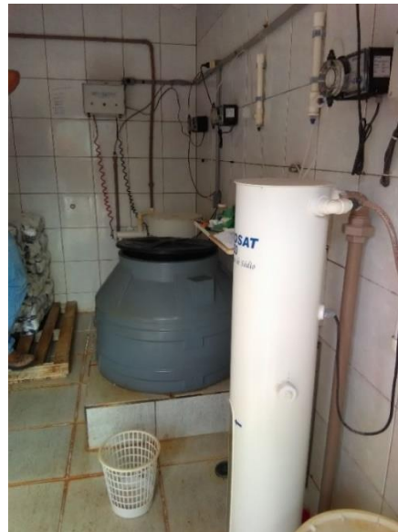
Foto 23 – Situação hidráulica da unidade de tratamento
