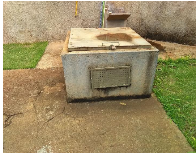
Foto 29 – Reservatório enterrado 300 m 3
