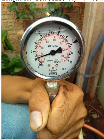
Foto 45 – Medição pressão na rede: Estrada Municipal nº. 31 (Latitude: -23.522590°S e Longitude: -50.786289°W) - P=16 mca
