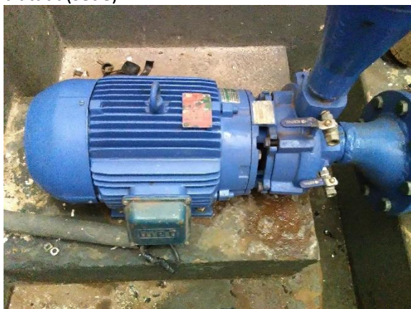
Foto 42 – Conjunto moto bomba recalque de água tratada(sede)
