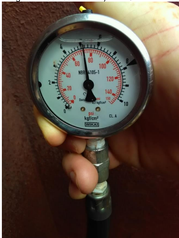
Foto 49 – Medição pressão na rede Rua Guanabara, no. 263 (Latitude: -23.5190657°S e Longitude: -50.7851217° W) - P=73 mca
