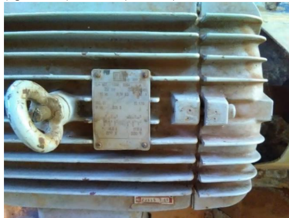
Foto 35 – Identificação bomba elevatória captação 01 (água bruta) – Bomba (01/2015)
