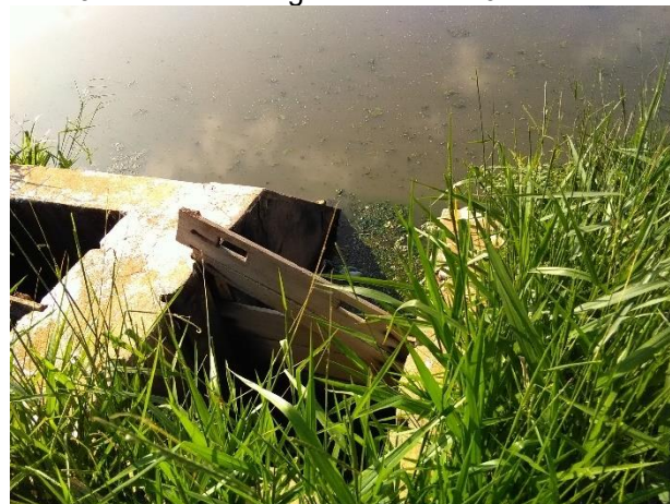
Foto 62 – Saída da lagoa anaeróbia 02
