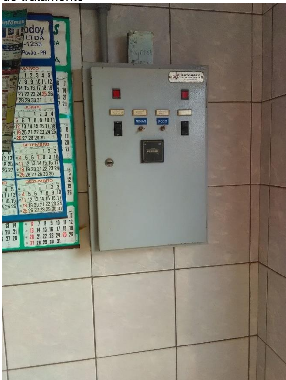
Foto 26 – Frente do quadro de comando da unidade de tratamento
