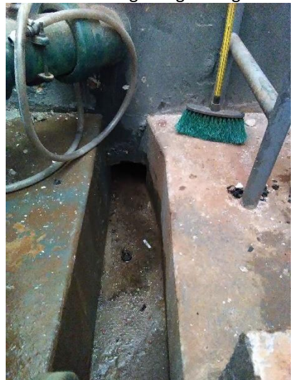
Foto 43 – Drenagem água da graxeta
