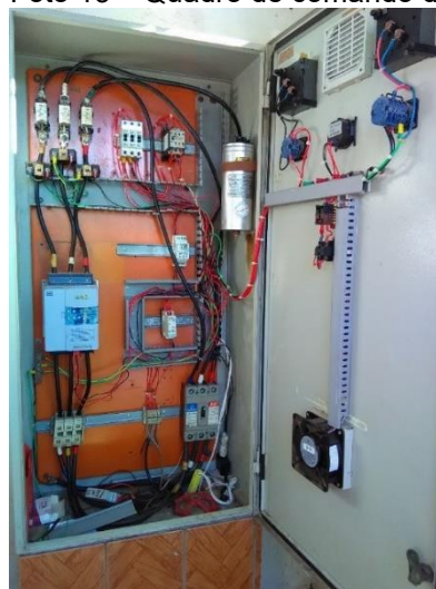
Foto 13 – Quadro de comando do poço 01
