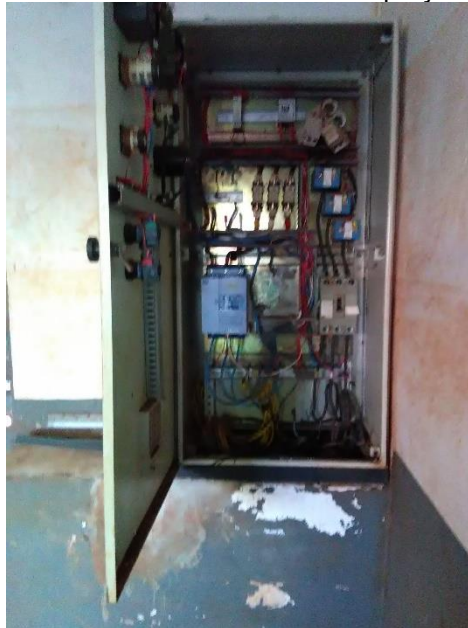
Foto 21 – Quadro de comando captação 02
