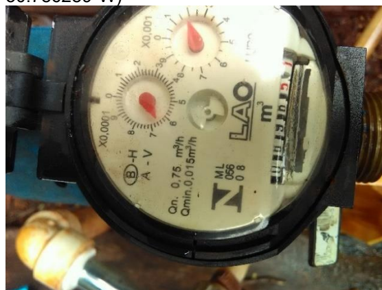
Foto 46 – Hidrômetro Estrada Principal nº. 31 (Latitude: -23.522590°S e Longitude: -50.786289°W)
