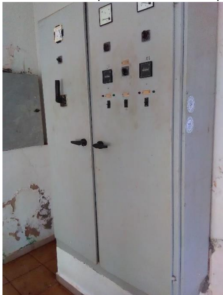
Foto 36 – Frente quadro de comando captação 01
