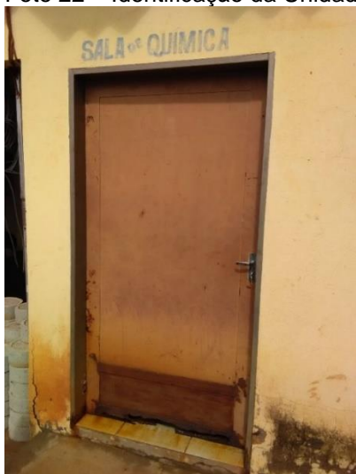
Foto 22 – Identificação da Unidade de Tratamento
