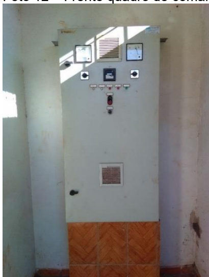
Foto 12 – Frente quadro de comando do poço 01
