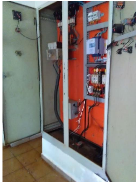
Foto 37 – Quadro de comando elevatória captação 01
