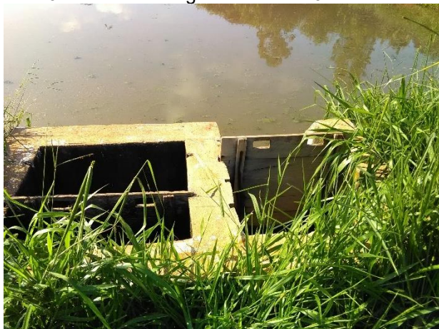
Foto 61 – Saída da lagoa anaeróbia 01
