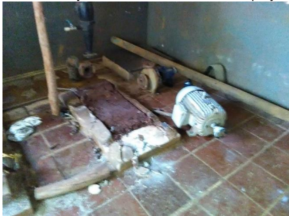
Foto 38 – Conjunto moto bomba elevatória captação 02
