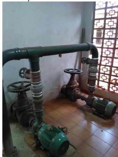
Foto 40 – Frente quadro de recalque (água tratada)
