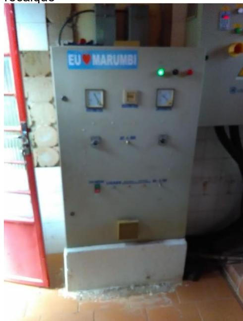
Foto 33 – Quadro da bomba de recalque
