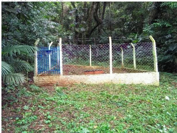
Foto 04 – Caixa onde junta águas mina 01 e 02
