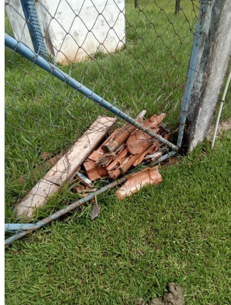
Foto 19 – Isolamento danificado poço 2
