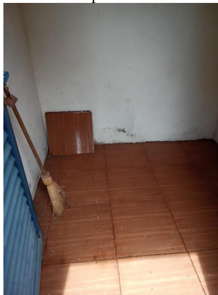
Foto 11 – Limpeza casa de comando poço 1
