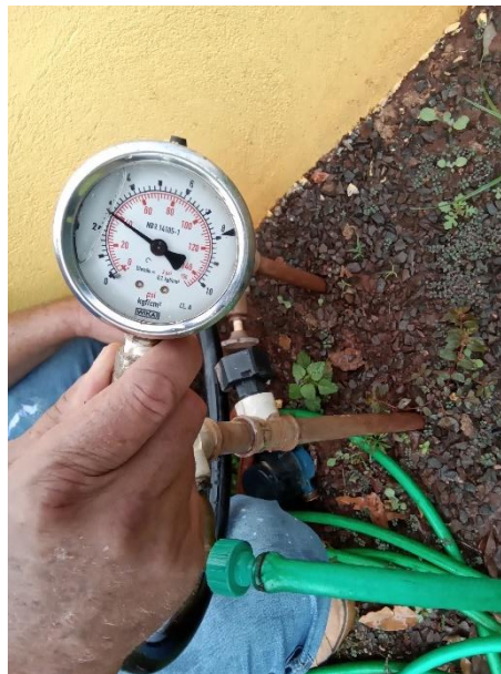
Foto 36 – P01 - Medição pressão na rede P01 = 40.00 mca
