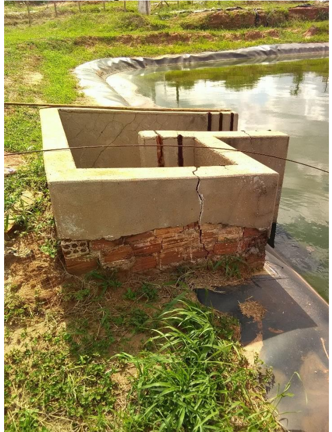
Foto 69 - Dispositivo de saída da lagoa anaeróbia 01
