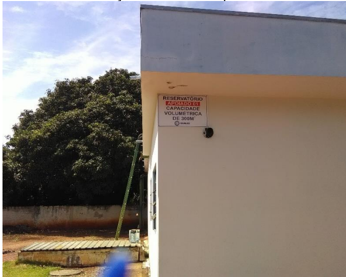
Foto 25 – Identificação reservatório apoiado 01
