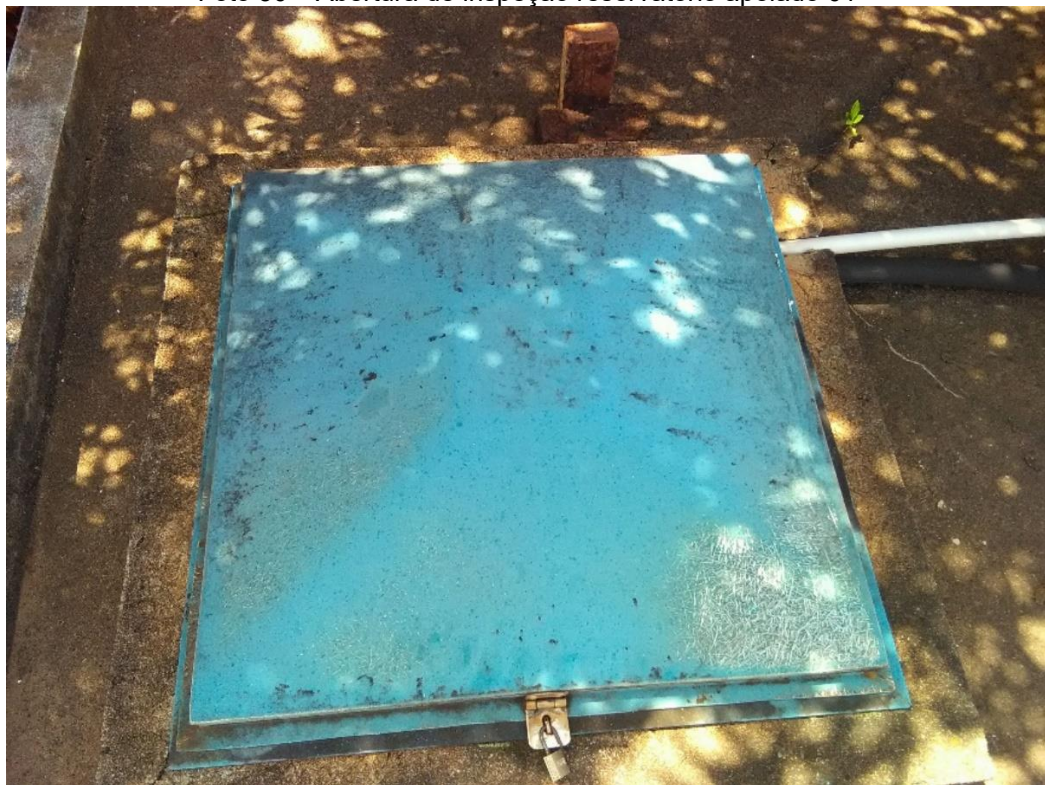
Foto 30 – Abertura de inspeção reservatório apoiado 01
