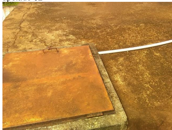
Foto 23 – Abertura de inspeção reservatório apoiado 02
