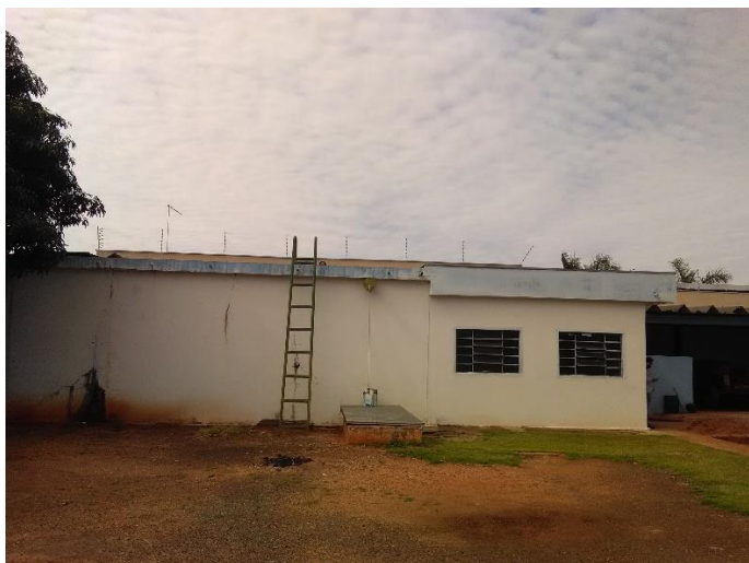
Foto 27 – Vista lateral reservatório apoiado 01 e escada
