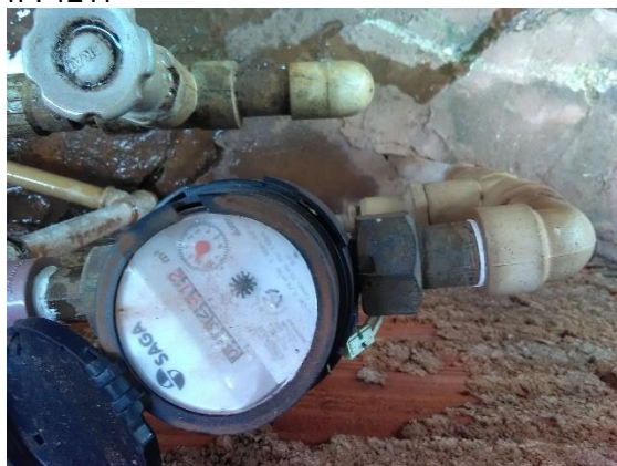
Foto 52 – Hidrômetro Rua Presidente Vargas, nº. 1211
