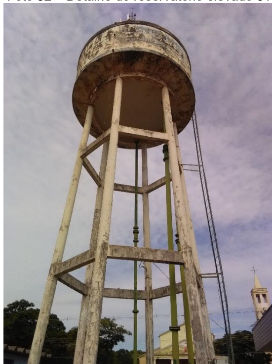
Foto 32 – Detalhe do reservatório elevado 01
