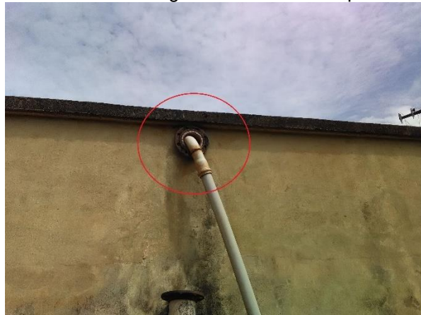
Foto 24 – Entrada água no reservatório apoiado 02
