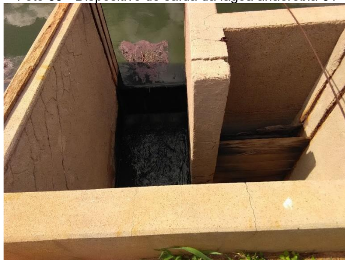
Foto 69 - Dispositivo de saída da lagoa anaeróbia 01
