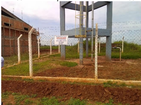
Foto 33 – Identificação reservatório elevado 03
