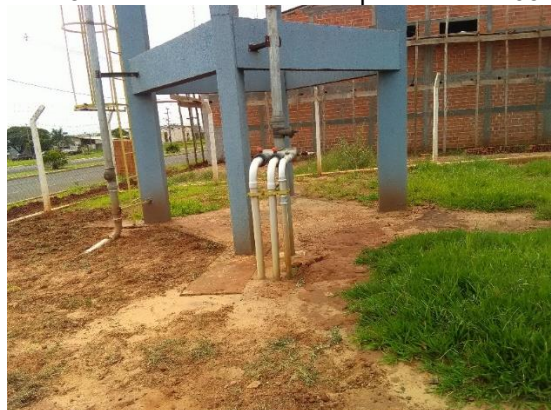
Foto 34 – Detalhe do reservatório elevado 03
