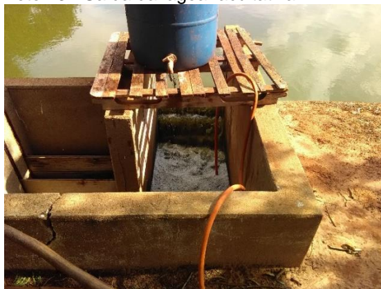
Foto 75 - Ponto de coleta de amostra na saída da ETE
