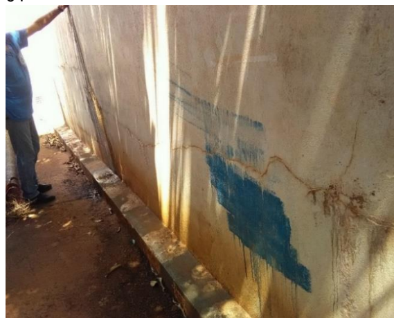
Foto 28 – Detalhe fundo reservatório apoiado 01
