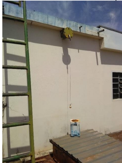
Foto 26 – Nível do reservatório apoiado 01
