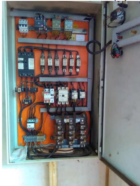
Foto 17 – Quadro de comando poço 07
