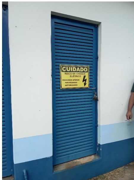
Foto 27 – Acesso casa de comando poço Bela Vista
