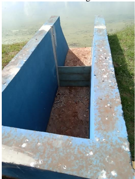
Foto 167 – Saída da lagoa facultativa 02
