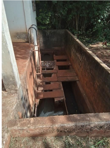
Foto 152 – Gradeamento ETE sede
