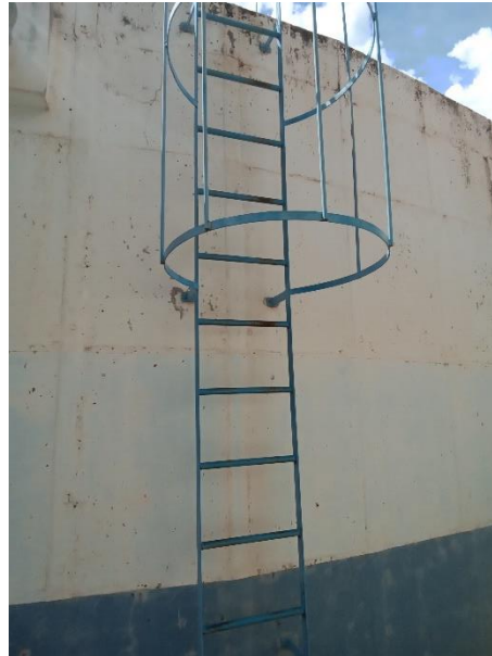
Foto 116 – Escada de acesso RAP poço 3
