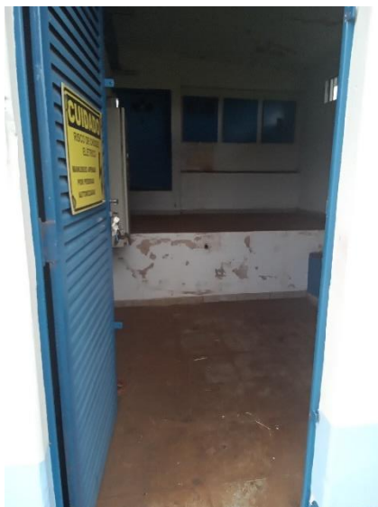
Foto 59 – Acesso elevatória Bela Vista
