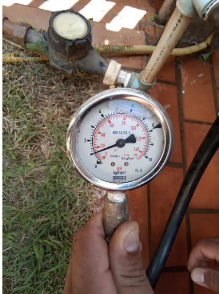
Foto 132 Medição pressão na rede P01 = 14.00 mca
