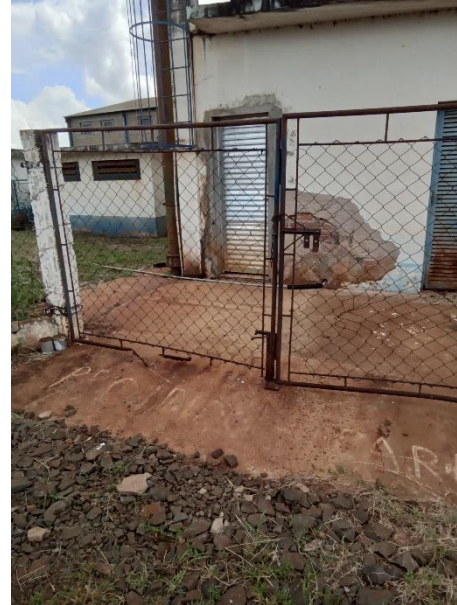
Foto 17 – Falta de identificação poço 2 (acesso restrito e identificação unidade)
