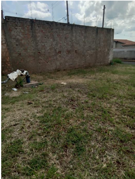
Foto 34 – Falta de isolamento poço Celso Fontes
