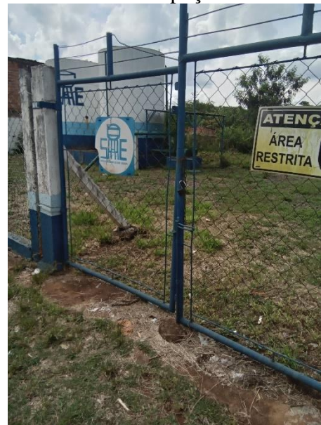
Foto 23 – Acesso poço Bela Vista
