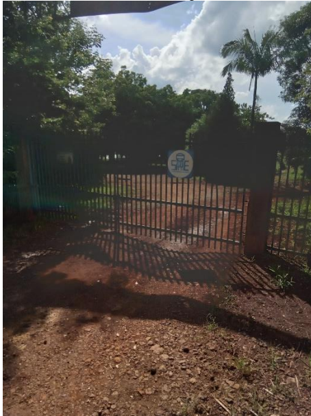
Foto 151 – Identificação ETE sede
