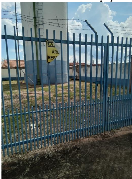
Foto 36 – Acesso casa de comando poço Celso Fontes
