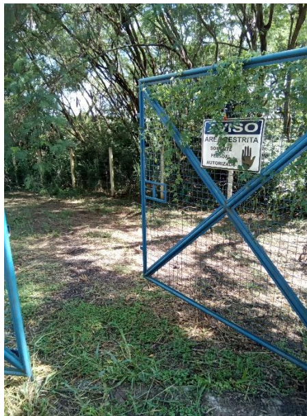
Foto 168 – Entrada ETE distrito
