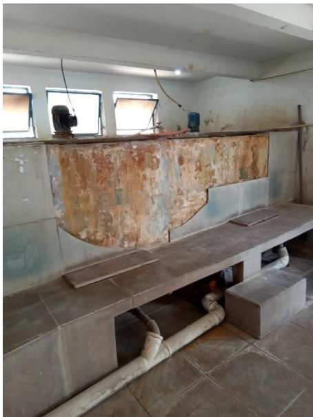
Foto 86 – Estrutura do tanque de sulfato
