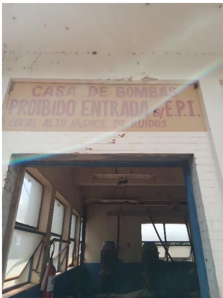
Foto 41 – Identificação casa de comando
