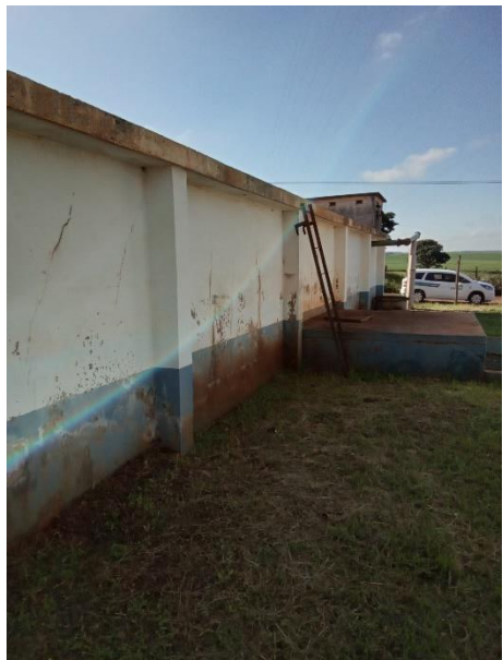
Foto 123 – Escada de acesso RAP Crispi
