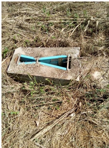
Foto 170 – Calha Parshall saída ETE distrito
