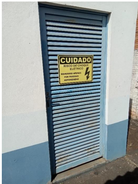
Foto 30 – Entrada casa de comando poço 3
