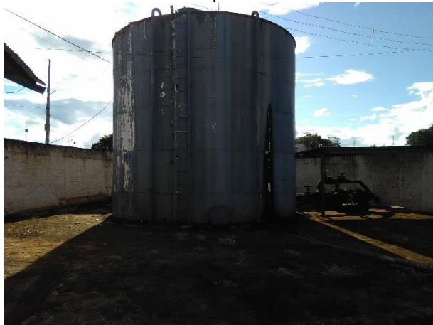
Foto 35 – Reservatório apoiado zona sul 600 m 3
