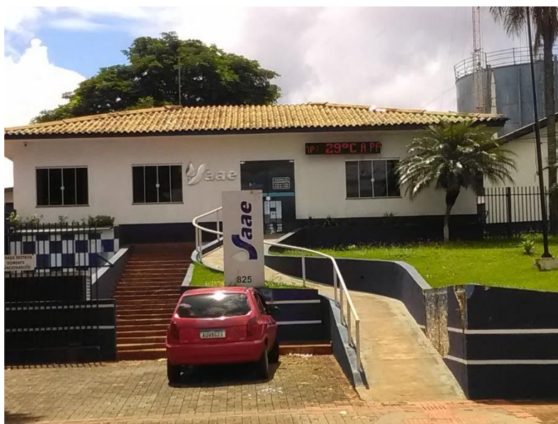
Foto 01 – Fachada área comercial
