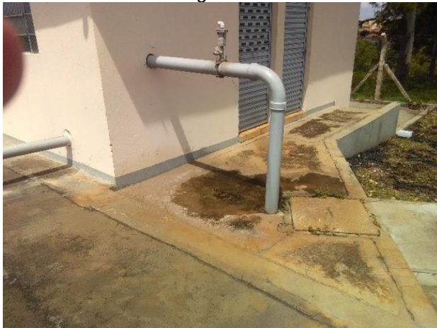
Foto 25 – Tomada de água Reservatório 300 m 3
