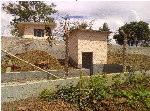
Foto 23 – Reservatório apoiado 300 m 3
