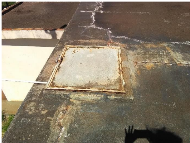
Foto 29 – Tampa de inspeção reservatório apoiado 100 m 3
