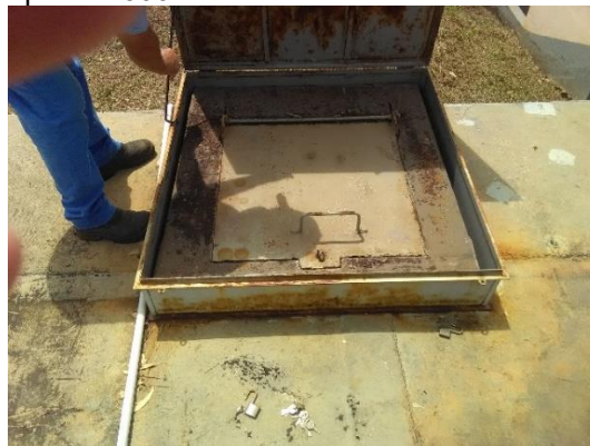
Foto 24 – Abertura de inspeção do reservatório apoiado 300 m 3
