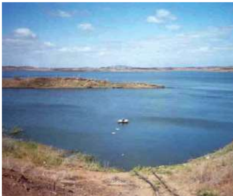
Figura 9 – Tomada de água flutuante sem passadiço (acesso necessita barco/bote).
