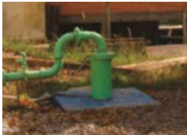
Figura 7 – Manancial subterrâneo com estrutura adequada (principais pontos: existência de laje de cobertura, tubo de revestimento a mais de 50 cm da superfície e lacre entre tubos de revestimento e de captação)
