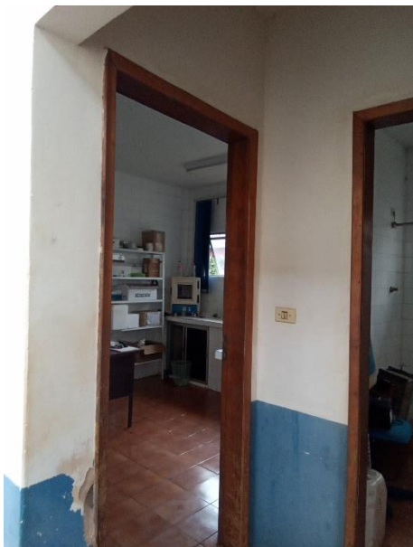
Foto 58 – Falta de identificação de laboratório de análises físico químicas
