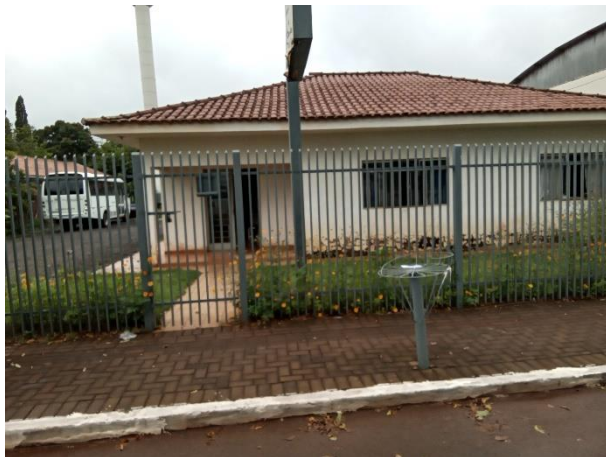
Foto 1 – Fachada SAMA E
