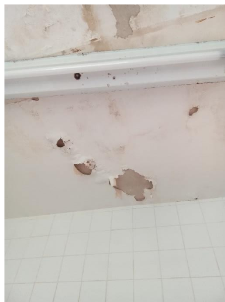
Foto 34 – Situação laje UTA sede
