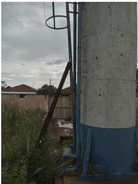
Foto 46 – Acesso REL distrito
