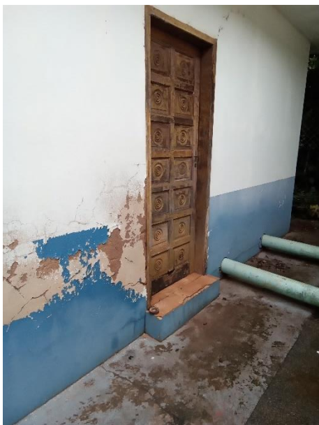
Foto 22 – Falta de identificação AAB02
