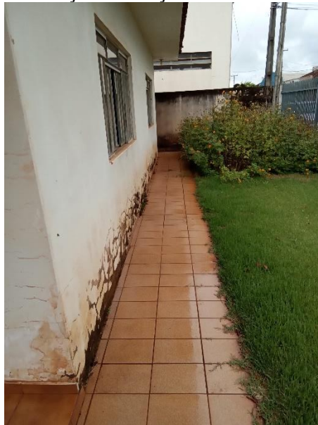
Foto 2 – Situação edificação sede
