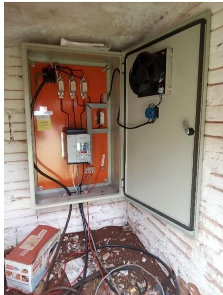
Foto 25 – Falta de identificação poço 2
