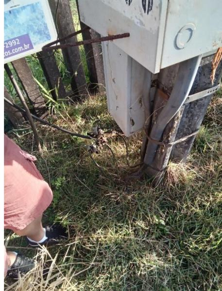
Foto 44 – Falta de isolamento e identificação poço 4 (sede)
