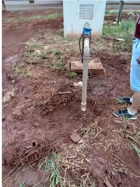
Foto 34 – Falta de isolamento e identificação
