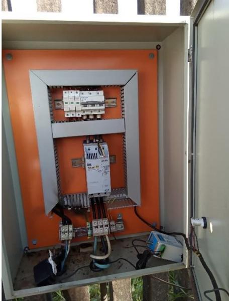
Foto 43 – Fiação exposta poço 6 (sede)
