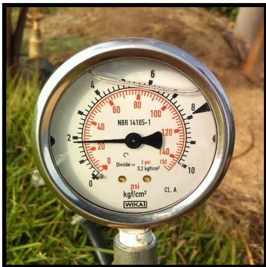
Imagem 25: Medição na Rua Arsênio Bakes
