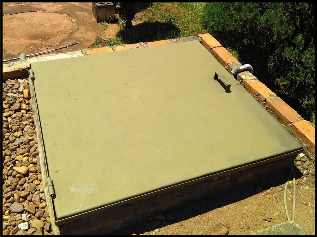
Imagem 09: Abertura de inspeção do reservatório apoiado
