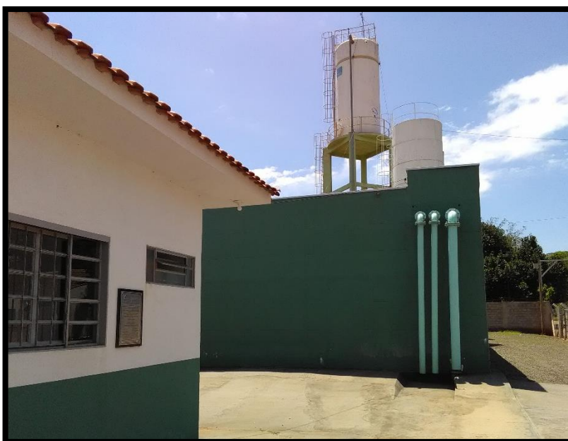
Imagem 11: Reservatórios apoiado e elevado
