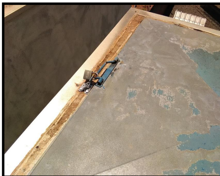
Imagem 12: Abertura de inspeção do reservatório apoiado
