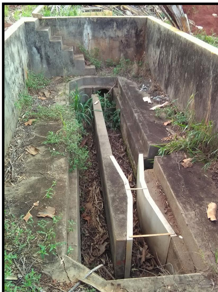
Imagem 35: Calha Parshall de entrada
