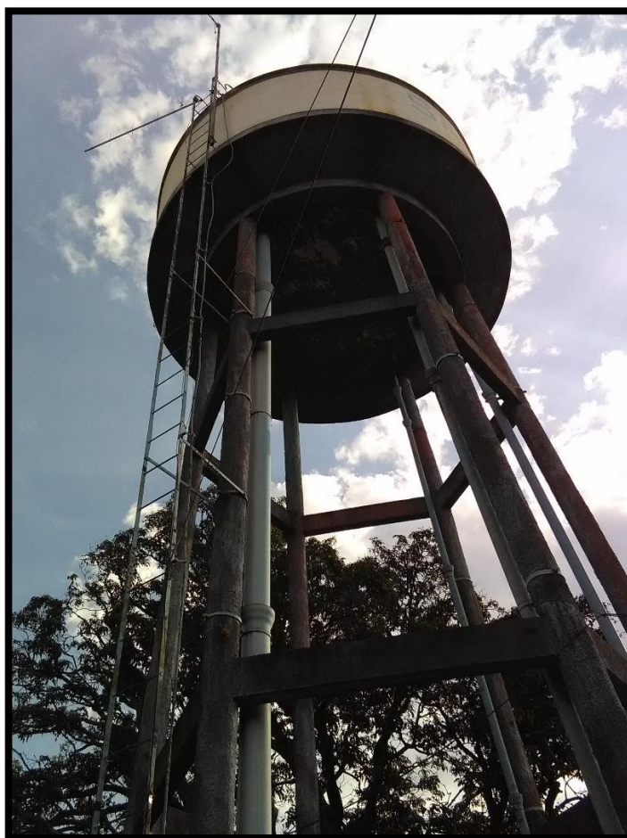
Imagem 10: Reservatório elevado (REL 01)
