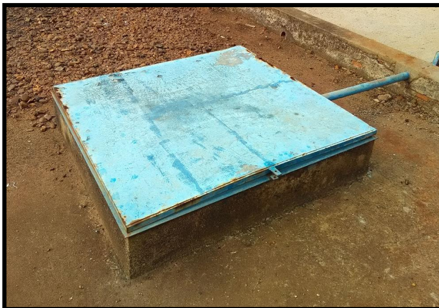
Imagem 09: Abertura de inspeção do reservatório enterrado (REN 01)
