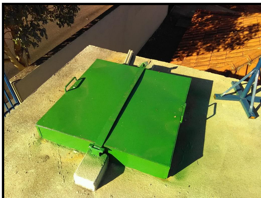
Imagem 22: Abertura de inspeção do reservatório semienterrado da sede
