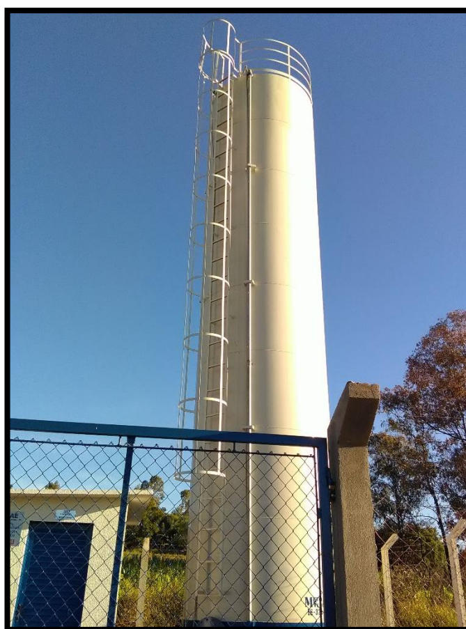
Imagem 24: Reservatório do distrito Taquara
