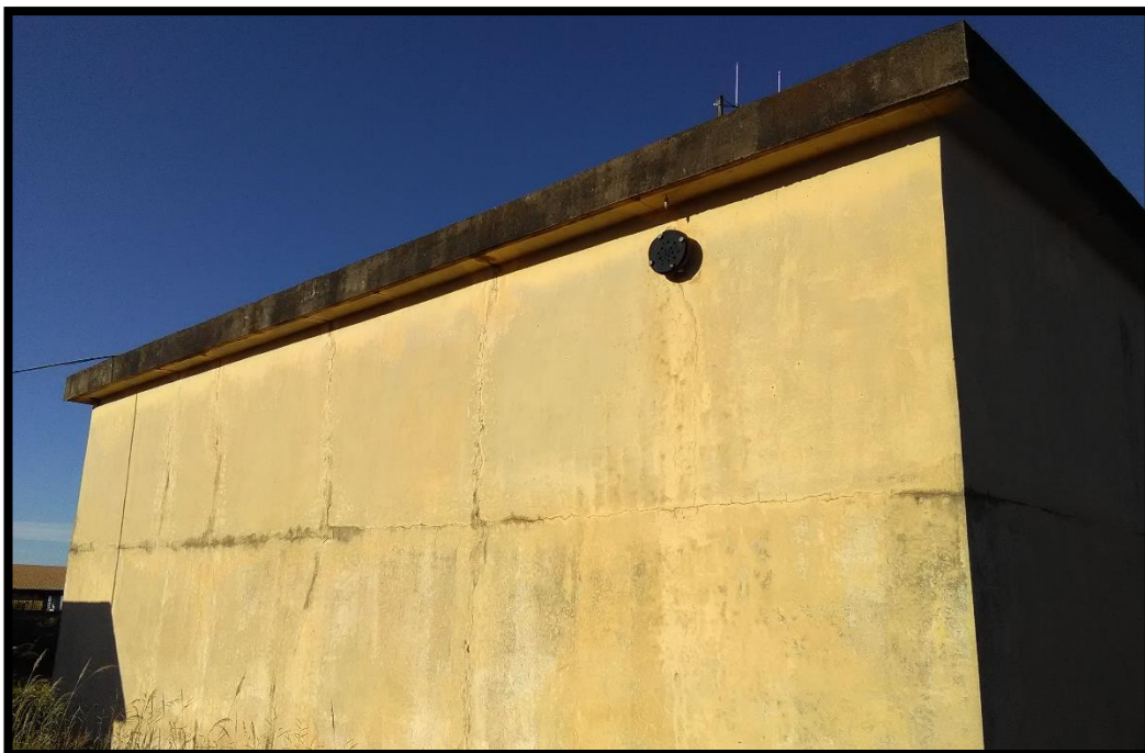
Imagem 23: Reservatório apoiado da sede
