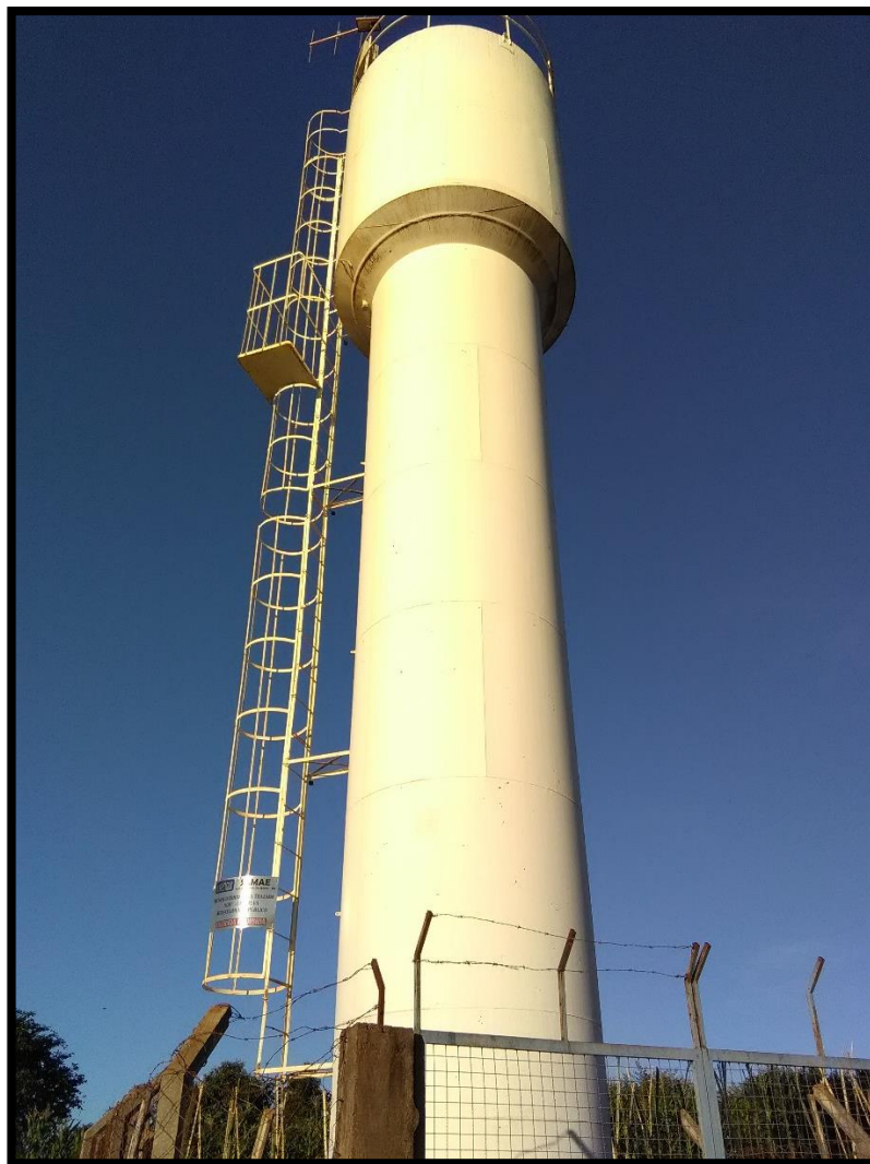
Imagem 25: Reservatório do distrito Caratuva
