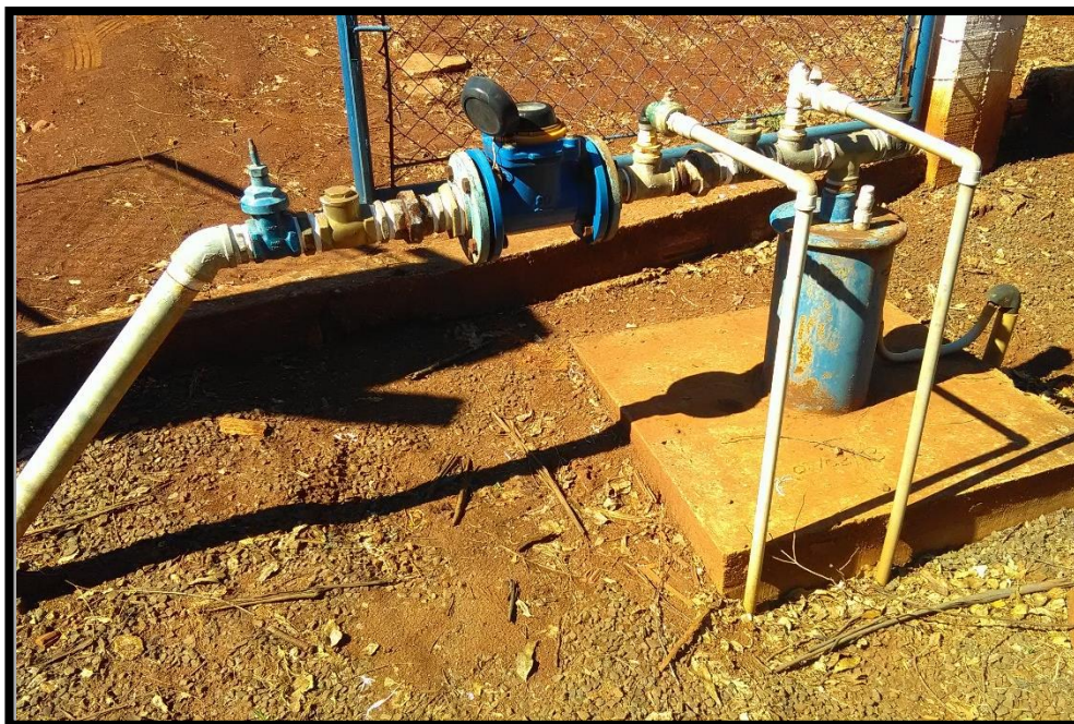
Imagem 11: Poço da Vila Nova
