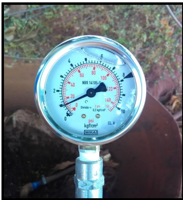
Imagem 10: Medição na Rua Ricardo Rissardo
